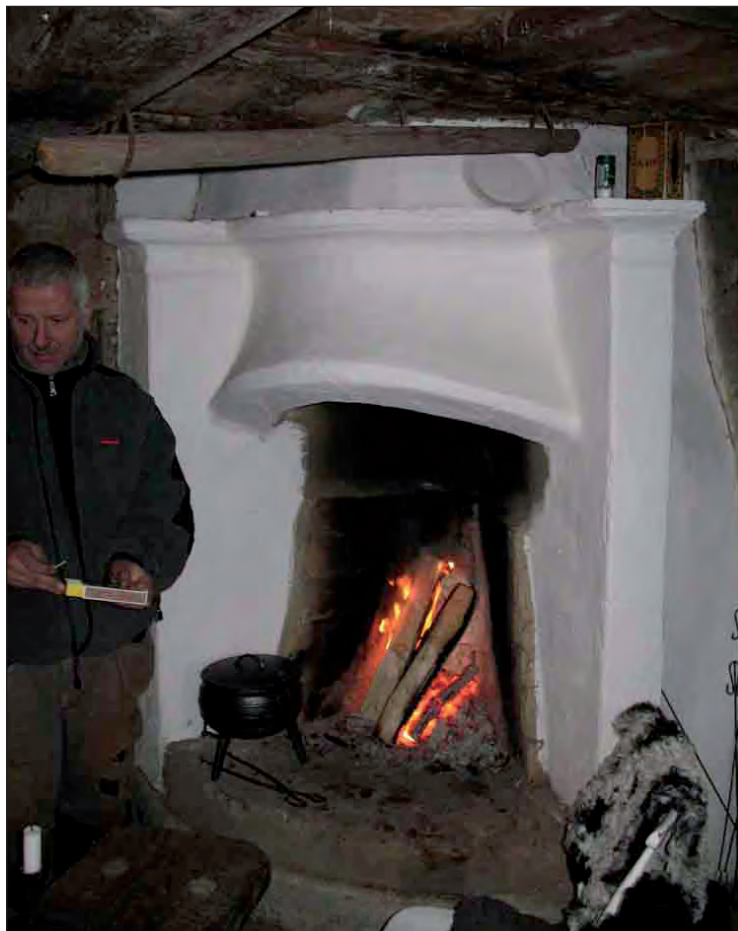
Fastighetsägare Thomas Forsberg eldar i drängstugans öppna spis. Med mur- och putsarbetena på spisar, skorsten och murstock kunde magasinets båda eldstäder åter sättas i bruk.
