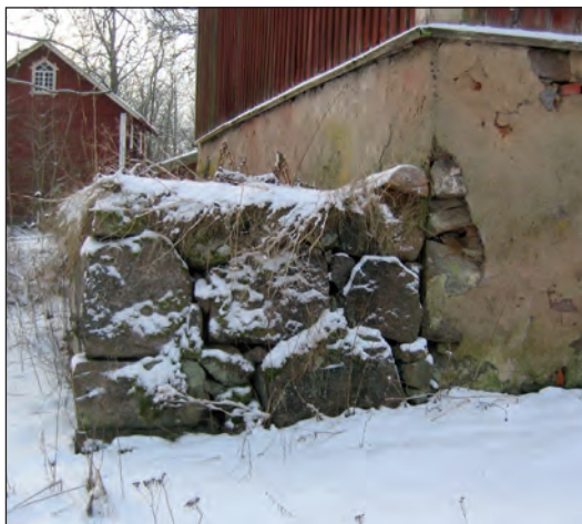
Mot öster finns en kallmurad stödmur, på vilken taklök ska ha odlats i äldre tid. Foto: Ulrika Olsson 2005, JLM.
