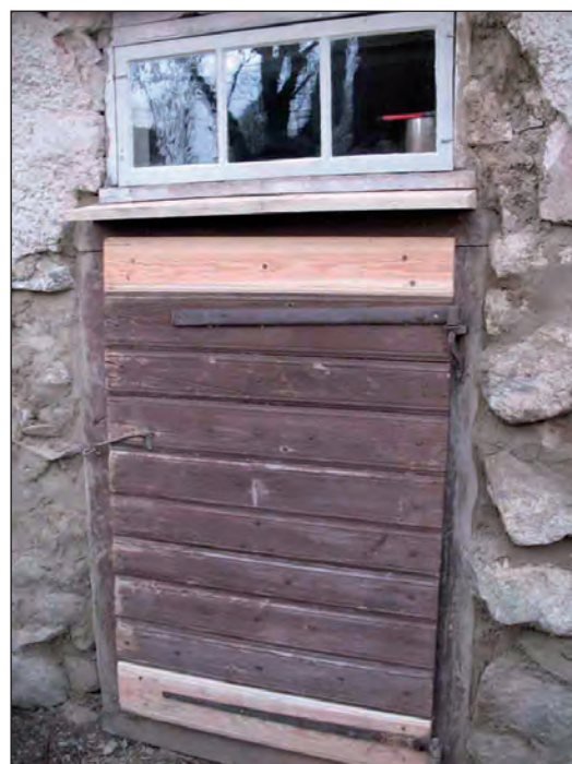
Handhyvlade panelbrädor med samma profil togs fram till lagningen av den södra källardörren.
