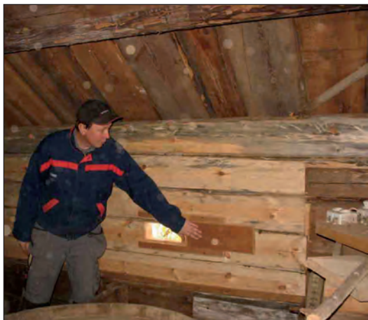
Enstaka av de reglerbara luckorna till ventilöppningar fanns kvar. Där de saknades tillverkades nya med de befintliga som förlaga. Hantverkare Johan Örfelth demonstrerar funktionen.
