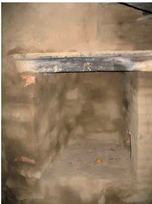
Den högra murvingen till bryggstugans öppna spis återuppmurades. Spiseln putsades med lerbruk.
