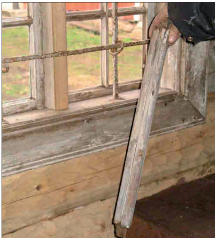
Mittposten till vishusbodens fönster fick ersättas. Den nya handhyvlades med den befintliga som förlaga
