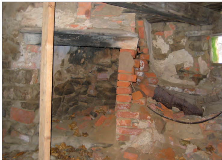
Brygghusets spiseln består av en öppen spis murad av natursten samt en bryggpanna murad av stortegel. Bryggpannan eldas via en öppning i spiseln högra murvinge. Bryggspiseln är fullständigt rämnad och av järnkaret kvarstår endast fragment. Foto: Ulrika Olsson 2005, JLM.
