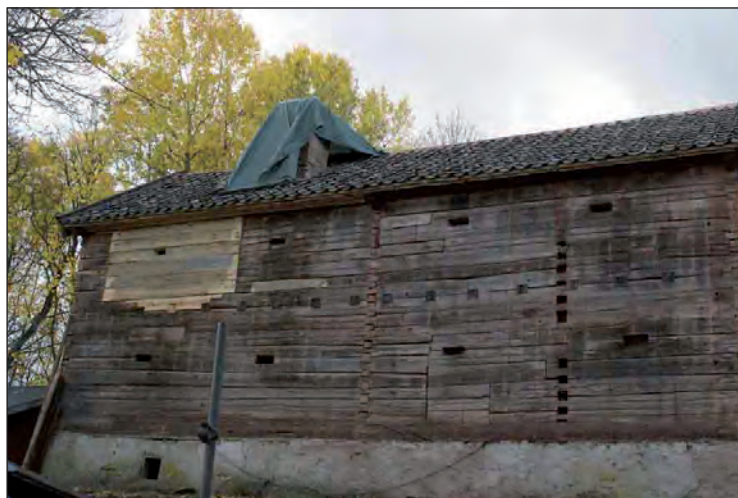
Timmerlagning i den östra väggen. Då panelen togs ned framkom den väderbitna och omålade timmerfasaden.
