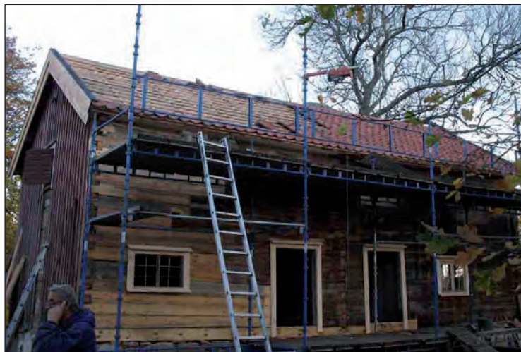
Magasinet tak erhöjll åter en täckning av gammalt handslaget lertegel.
