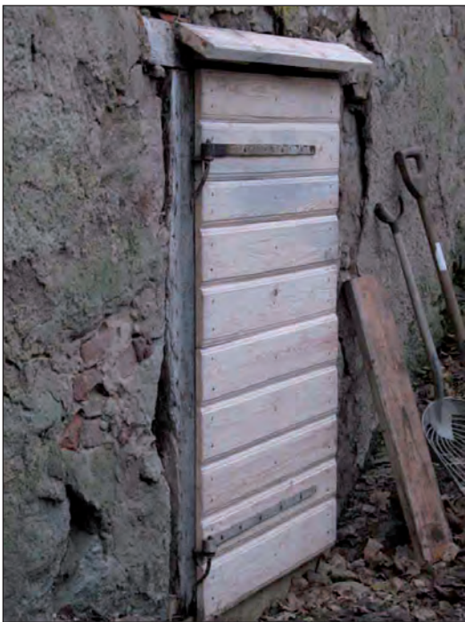
Den ursprungliga bräddörren till matkällaren åt norr kläddes om med panel och försågs med smidda bandgångjärn i ursprunglig tappning.
