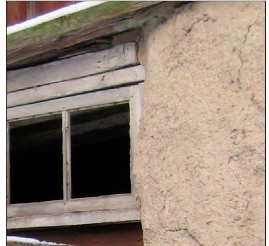
Detalj av källarvåningens puts före restaurering. Putsen som bedömdes ha hög ålder var en spritputs av naturligt hydrauliskt kalkbruk, i ett tunt påslag.
