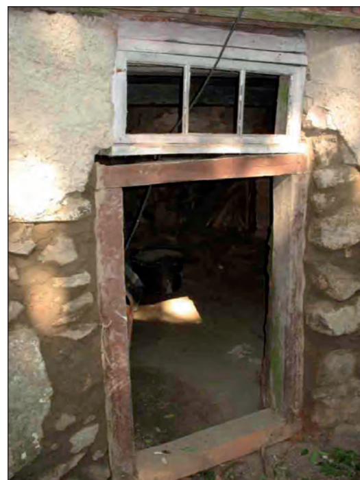
De rämnade delarna av södra källarmuren återuppmurades med natursten och lerbruk.
