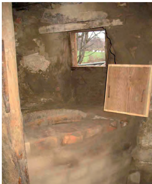
Själva bryggghusspiseln fick muras om från grunden med begagnat stortegel. Här syns den nya luckan till ventilöppningen i muren.
