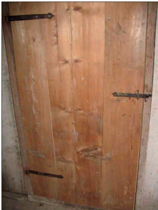
Dörren mellan förstuga och stuga saknades och fick därför rekonstrueras.
