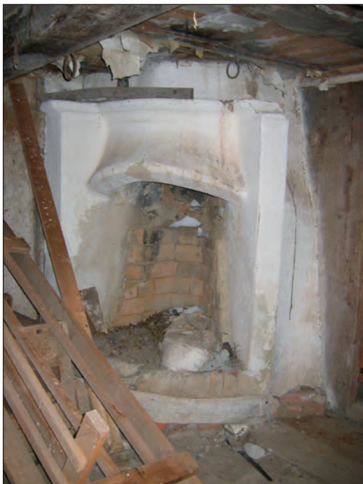
Drängstugans öppna spis har mindre skador, bland annat saknas krönet på ena murvingen och teglet i själva härden behöver sättas om. Foto: Ulrika Olsson 2005 JLM.
