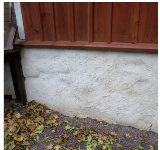
Sockeln efter omputsning. Foto: Margareta Olsson 2016.
