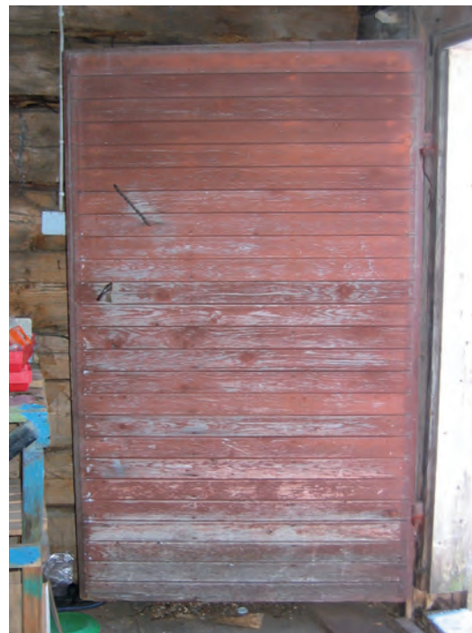
Boddörrarna i gårdsfasaden har klätts om med smal fasspantpanel, någon gång på 1930-40-talen. Foto: Ulrika Olsson 2005, JLM.
