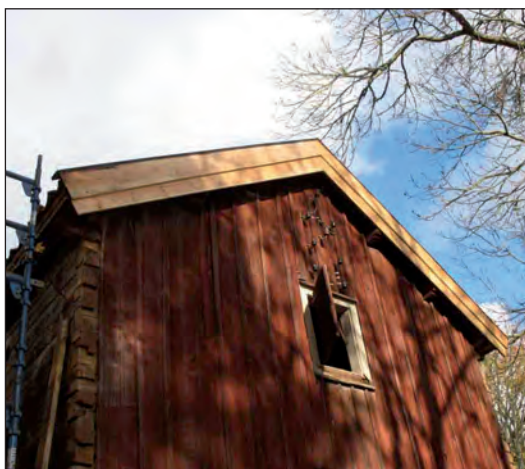
Nya dubbla vindskivor och stormlister av sågade furubrädor sattes upp, dock utan avrundade nedre hörn.
