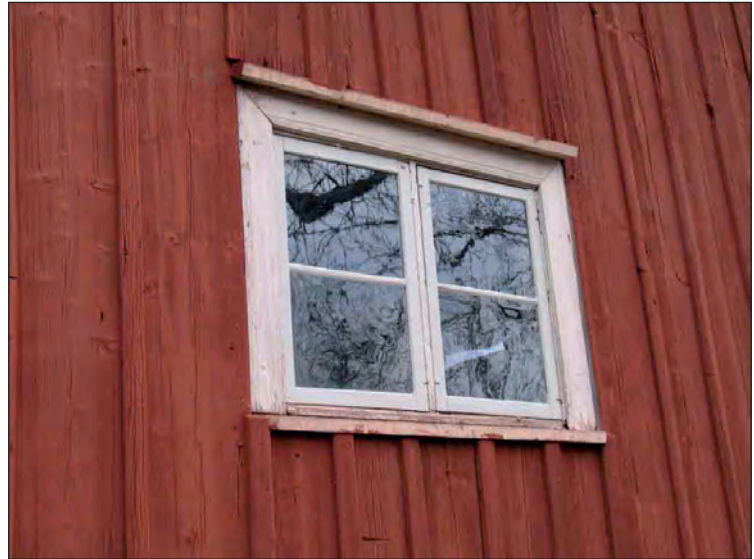
Originalfodren kring drängstugans fönster kunde bevaras medan de flesta av fodren på framsidan fick ersättas.
