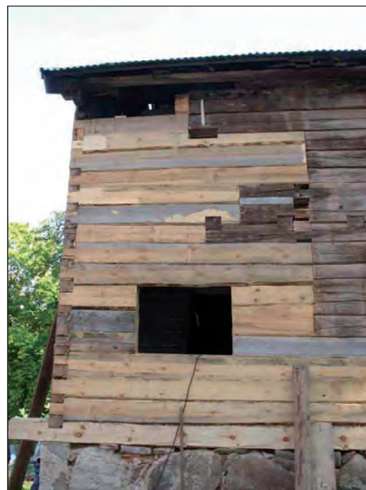
Syllen åt väster fick bytas till två-tredjedelar av sin fulla längd. En sektion av timmerväggens norra del fick ersättas i sin helhet.
