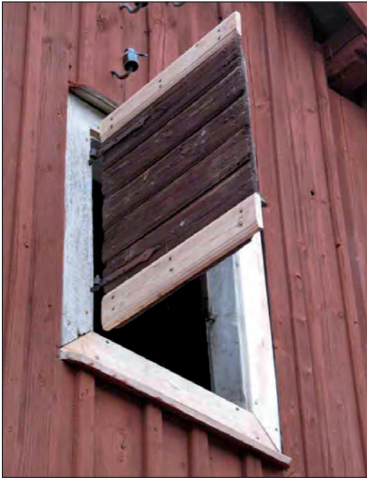
Luckan i den södra gavel med lagningar i panel och foderomfattning. Isolatorerna till gårdens äldre elledning bevarades.
