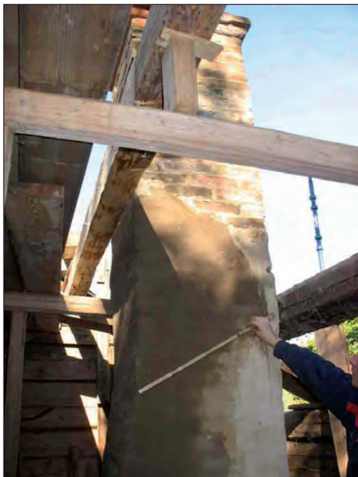
Skorsten och murstock efter ommurning. Hantverkare Johan Örfelth markerar hur stor del av murstocken som murats om.
