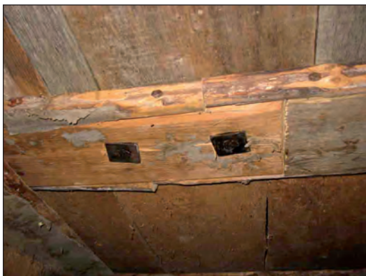
En av mellanbjälklagets bjälkar i anslutningen till östra ytterväggen lagades. Blandskaven drogs ihop med gängbult med fyrkantsbricka och mutter i smide.
