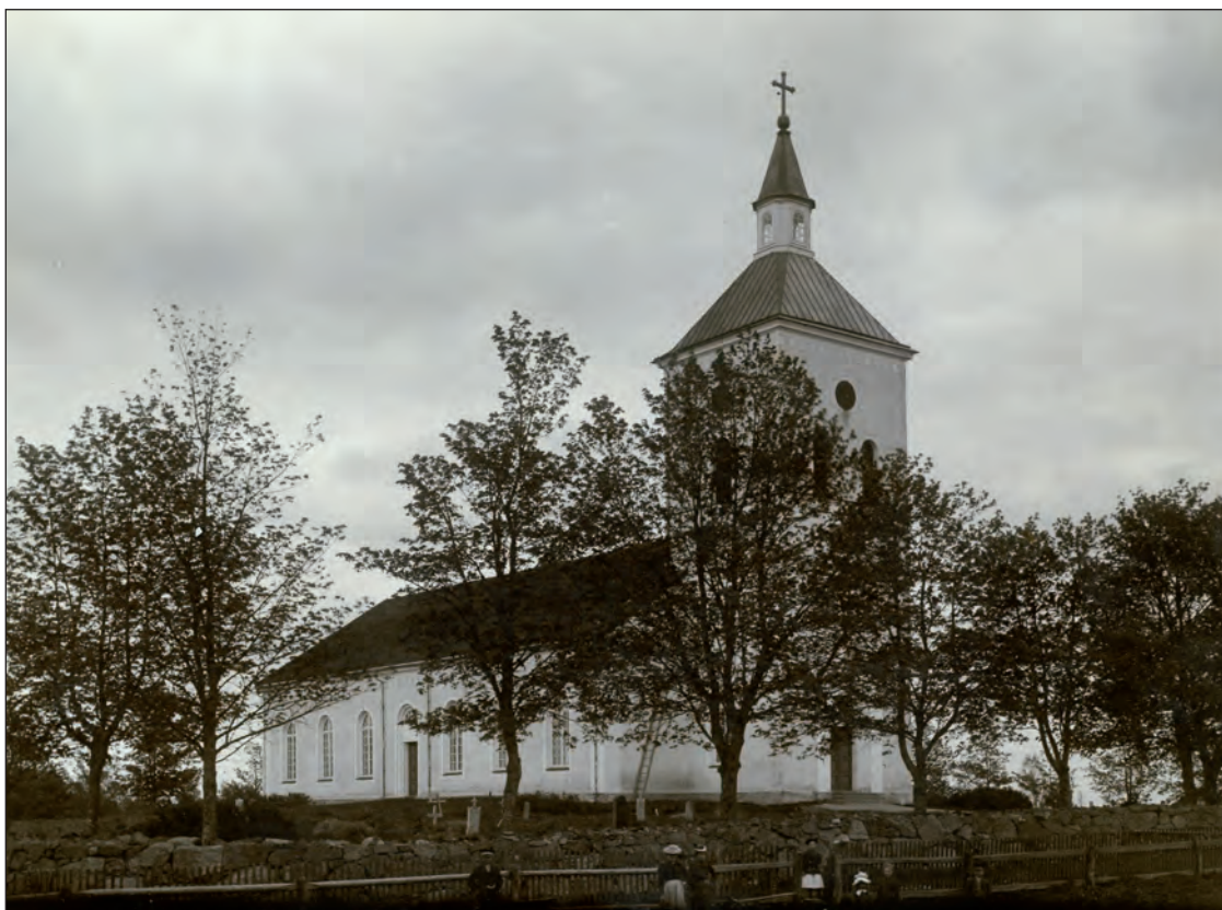
Hultsjö kyrka vid 1900-talets början. Kyrkan har vid denna tidpunkt alltså kvar sitt ursprungliga tegeltak medan plåttaket på tornet nyligen lagts om. Notera att fönstren har en ljus kulör och att lanterninen har en plåtbeklädd bas som var målad i fasadens vita kulör.
