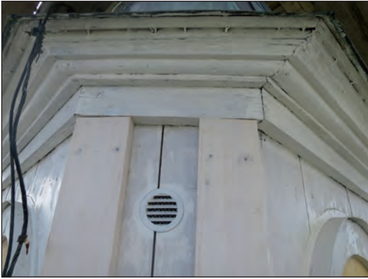
Lanterninen försågs med en ventil på nordöstra fasaden.
