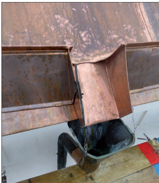
Befintliga vattkupor och stuprör bibehölls men vissa krökar fick bytas ut mot nya.
