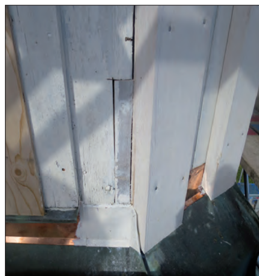
Den nya ståndskivan drogs upp bakom foder och pilastrar och målades i fasadkulör för att inte påverka intrycket av lanterninens höjd.
