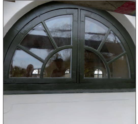
Lunettebågen över nordentrén bevarades som referens över fönstrens äldre färgsättning.
