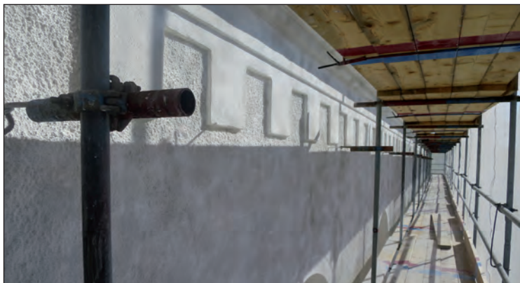
Kyrkans södra fasad efter blästring. Putsen var i ett gott skick med mycket få skador.
