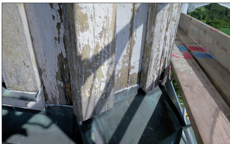
Ståndskivan mot fasaden, hade en otät anslutning med omvikt spikad kant.
