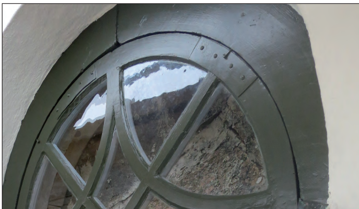
Detalj av västportalens rosettfönster. Bågarna återmonterades med omvikt nytillverkad klippspik. Samtliga bågar ställdes med distanser av plast på karmbottenstycket för att minska risken för röta.
