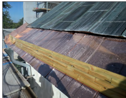
Fotplåten drogs upp ca 20 cm under befintlig plåttäckning.
