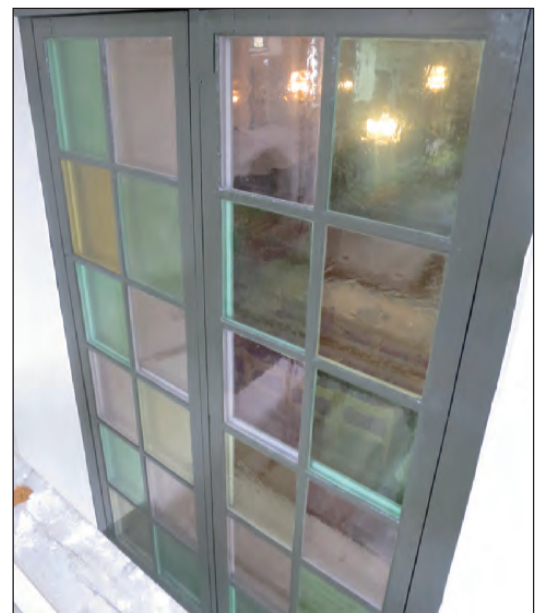
Trasiga rutor i korfönstren ersattes med tonat antikglas i grönt, gult och rosa.
