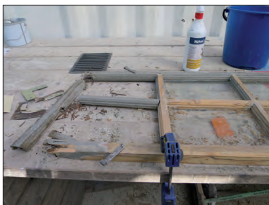
Rötskadade delar i bågarnas bottenstycken lagades i med nytt profilhyvlat furuvirke av högsta kvalitet.
