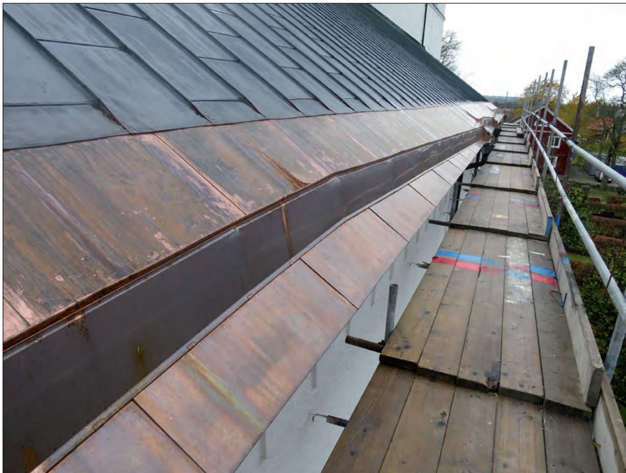
Den nya ståndrännan på långskeppet utfördes enligt Bygg-AMA förstärkt med trästomme. Takutsprång gjordes utan knäckning enligt tidigt 1900-talsutförande.
