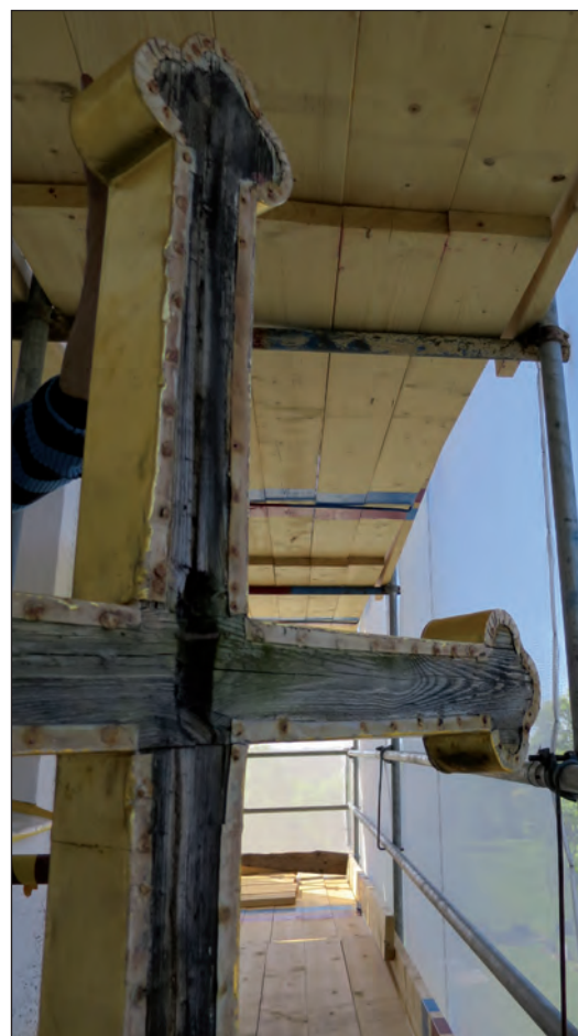
Baksidan av dekorkorset till västportalens krön. Korset var mycket autentiskt bevarat. Kopparplåten var fäst med smidd spik. På baksidan fanns spår av järnmönja troligen från en omförgyllning på 1900-talet.
