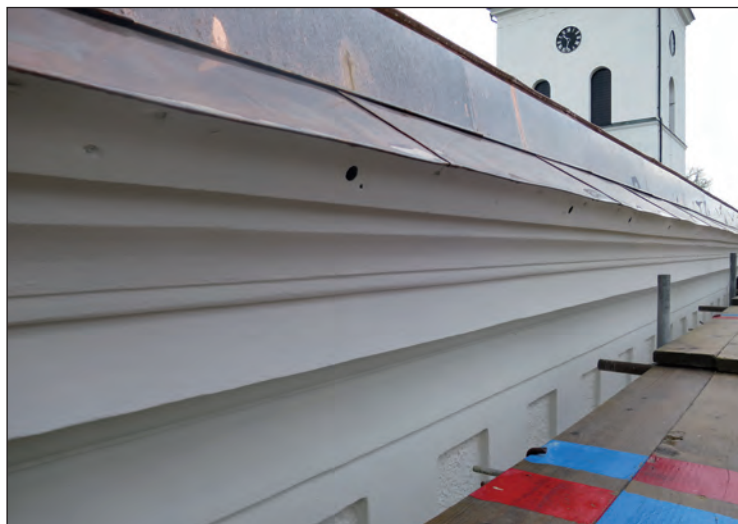
Takfotsbrädan målades med linoljefärg i brytning, NCS S 0502-Y, som liknade fasadputsens vita kulör
