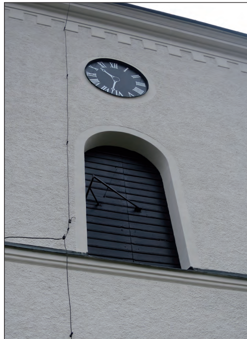
Tornur och ljudluckor målades om med järnoxidsvart linoljefärg Silverfärgen till urtavlor och visare bröts fram på plats.
