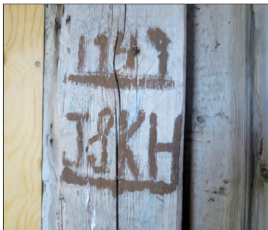
Någon av hantverkarnas inskription i lanterninen vid renoveringsarbetena 1949.
