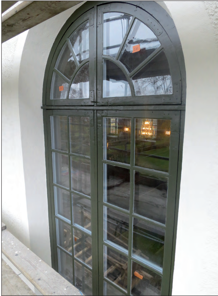
Renoveringen av kyrkans fönster gjordes grundligt i arbetsbod med färgborttagning, trälagningar, kittkomplettering och ommålning med linoljefärg. Befintlig gröngrå kulör bibehölls, efter att prov tagits på en opåverkad yta.
