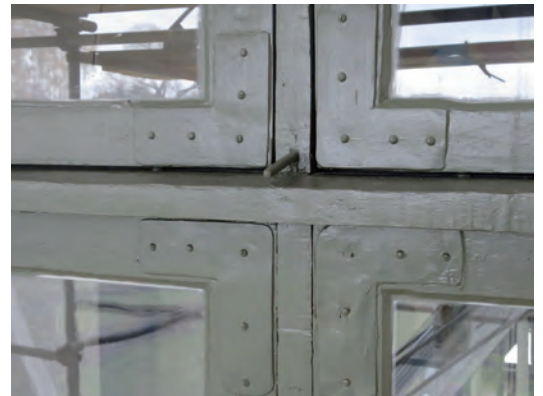
Samtliga hörnbeslag sattes tillbaka med ny spårskruv med kullrig skalle.
