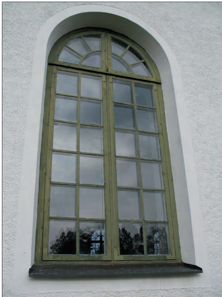
Fönstren har sannolikt aldrig genomgått någon mer omfattande renovering. I utsatta vädersträck är såväl färgskikt och kittfalsar krackelerade.
