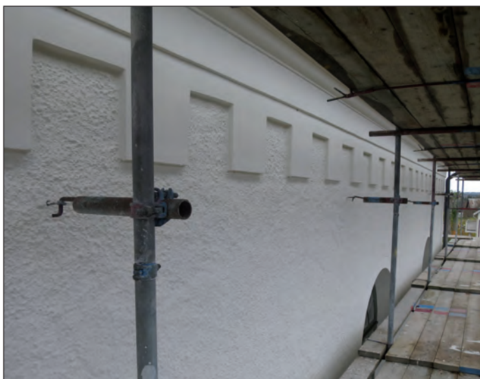
Sektion av långskeppets fasad. Putsen var i god kondition och endast ett fåtal putsläggningar behövde göras.
