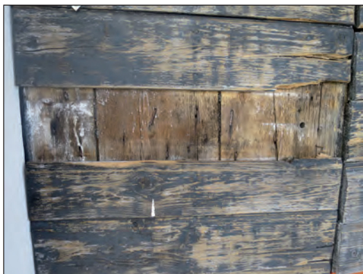
Enstaka spruckna brädor i ljudluckornas spontade panel byttes. De nya togs fram med maskinhyvel med befintlig panel som förlaga.
