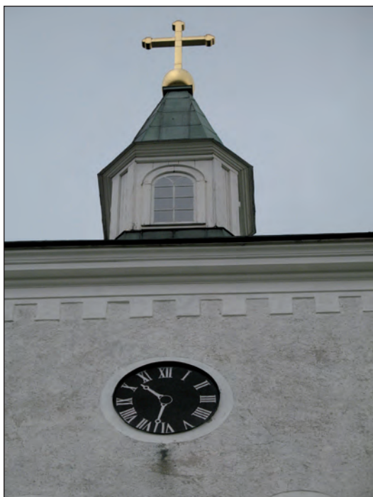
Tornet saknar tornur men har sentida urtavlor i plåt med visare och romerska siffror målade med silverfärg.
