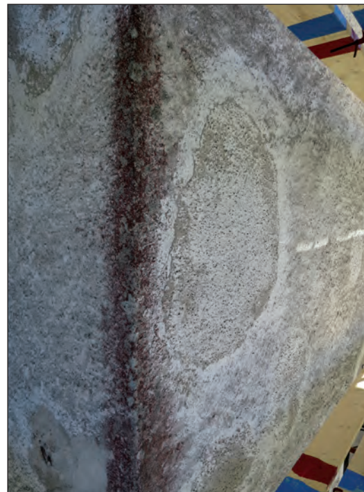
Misspyrdande äldre lagningar på tornet knackades inte ned utan slipades enbart ned i kanterna.
