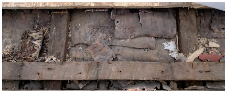
Kyrkans längskepp var fram till 1965 täckt med lertegel. Nävertäckningen påträffades i takfoten då ståndrännan revs.
