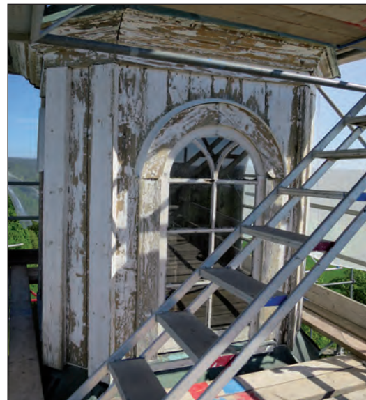
Lanterninens fasad efter skrapning.
