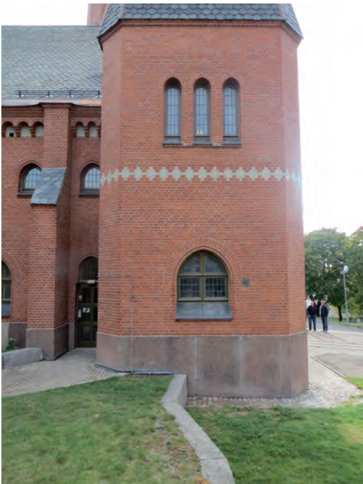
Det lägre trapptornet efter avslutade arbeten.
