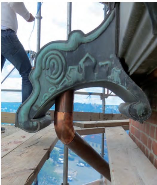
Ovan: Det nya stupröret monterat under utkastaren. Till höger: Avvattningssystemets tråg och utkastare inför arbetena.
