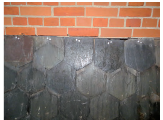
Skifferplattorna demonterades, ny papp lades och plattorna återmonterades med rostfri, syrafast skruv eller spik.
