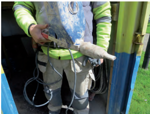
Fogarna fylldes med hjälp av en fogspruta.
