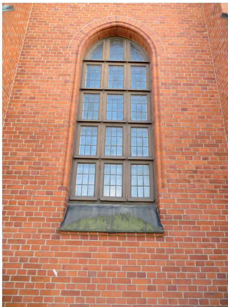
Ett parti av långhuset med ett fönster mellan två kontreforer.
