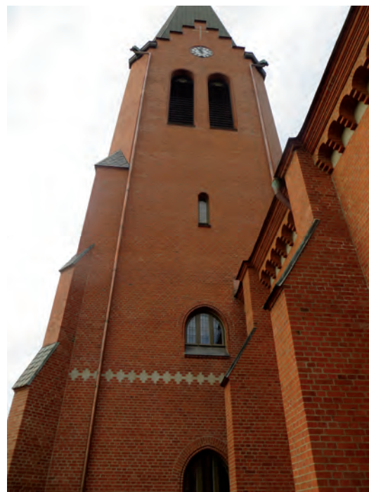
De nya stuprören på tornets östra sida.
