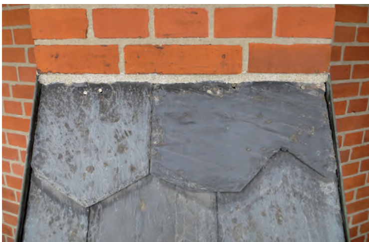
På kontreforererna avslutades skifferytan upptill av en fog som anslöt till tegelfogarnas utseende.
