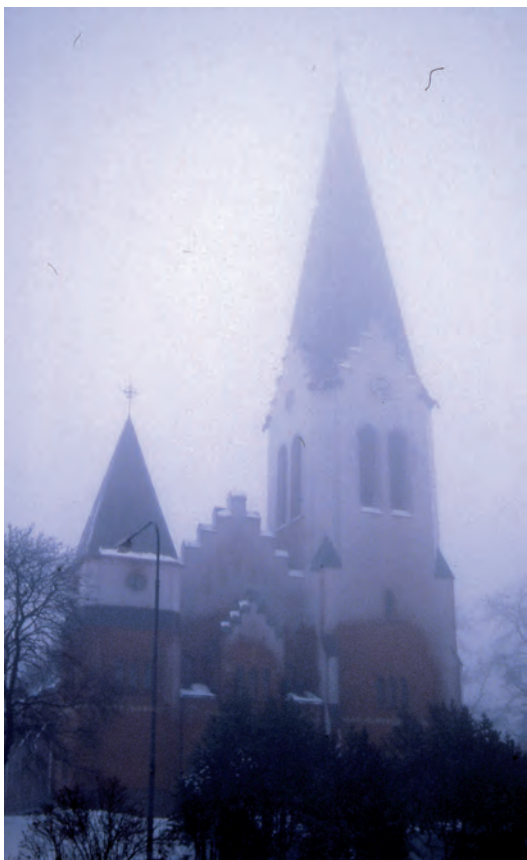
En dimmig och fuktmättad dag omkring 2000 visar var murverket är som kallast och därför särskilt utsatt för frost och nollpunktspassager.
