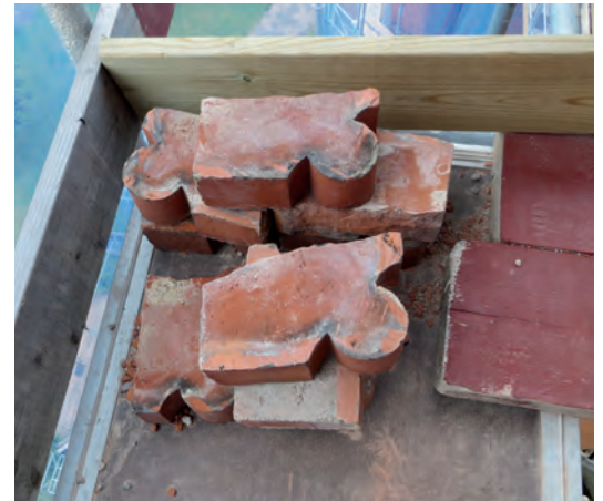
Demonterat formtegel.
