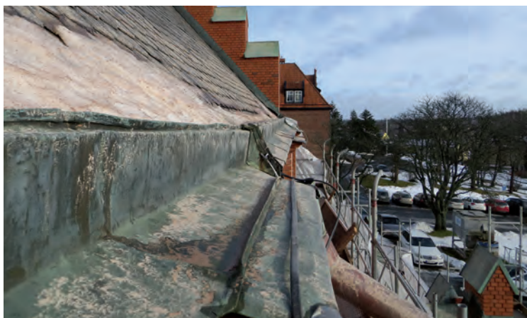
Den befintliga takfoten på långhusets södra sida. Den hade troligen tillkommit vid skiffertaksomläggningen 1983.
