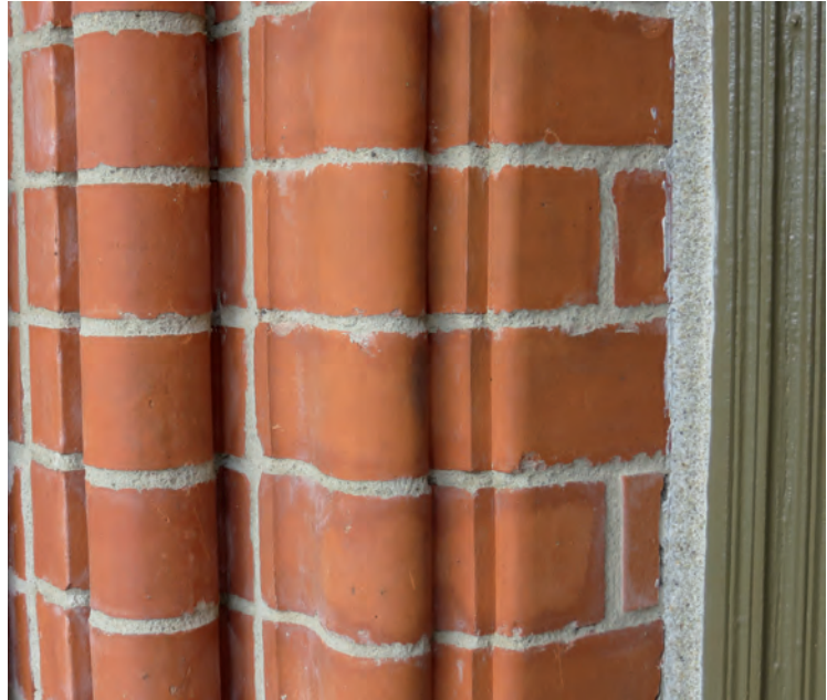
Ovan: Detalj av dörrnisch med bruksfog mellan tegelstenarna och sandbläst mjukfog mot snickerierna.
