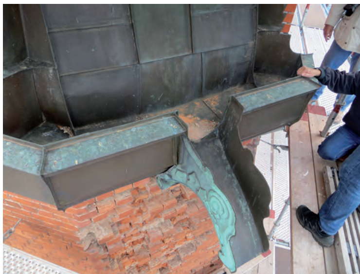
Ovan: Det nya stupröret monterat under utkastaren. Till höger: Avvattningssystemets tråg och utkastare inför arbetena.
