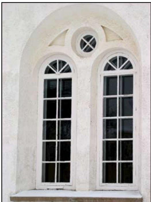
Fönsterbågarna är de ursprungliga med blåsta glasrutor.
