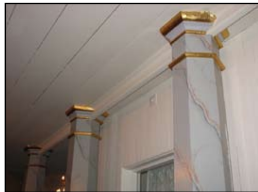
Järnvägsrälsen som bär läktaren har troligen en direkt koppling kring järnvägsdragningen genom Bankeryd 1864.
