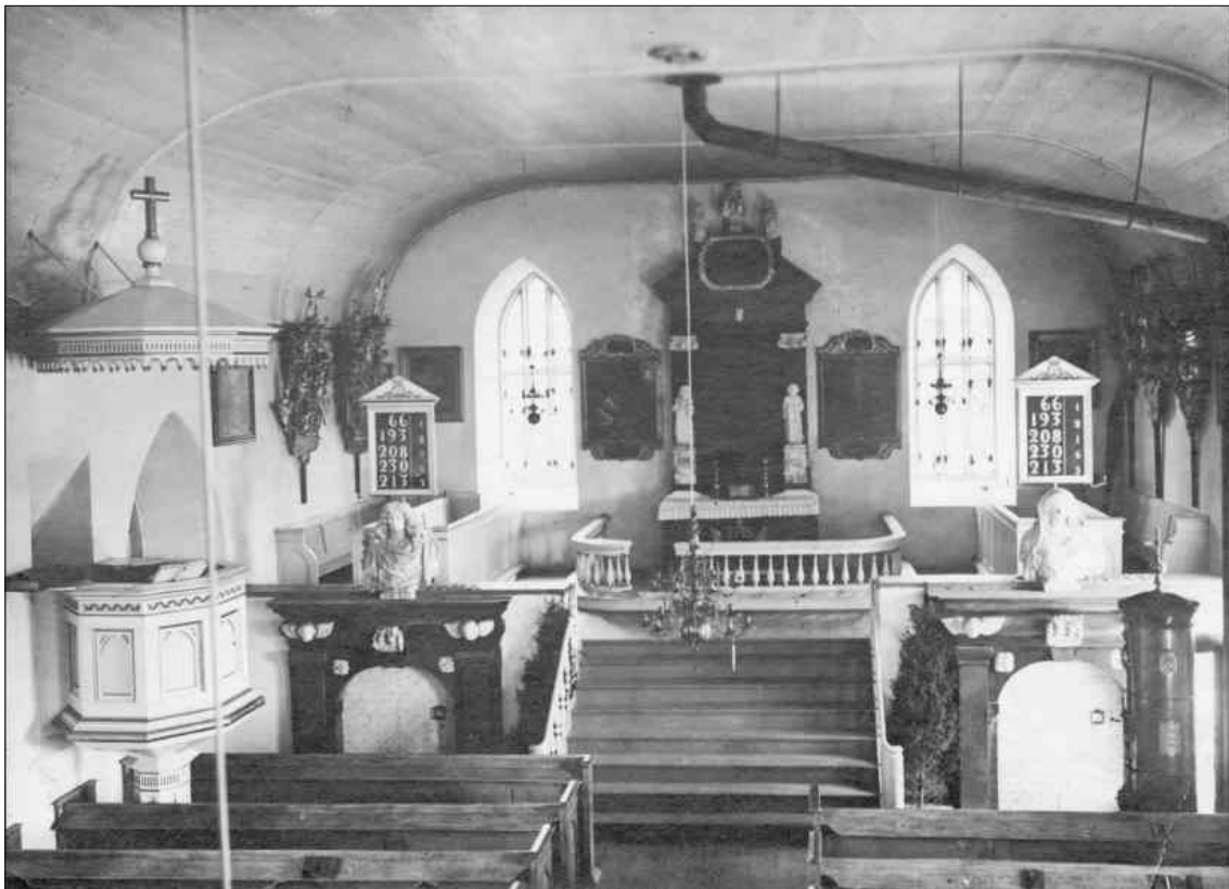
Interiör mot öster. Fotot är taget före branden 1904. Foto okänt. (ATA)
