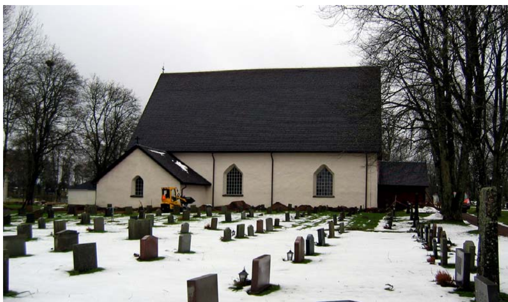
Kyrkobyggnadens norra fasad under pågående schaktning.
