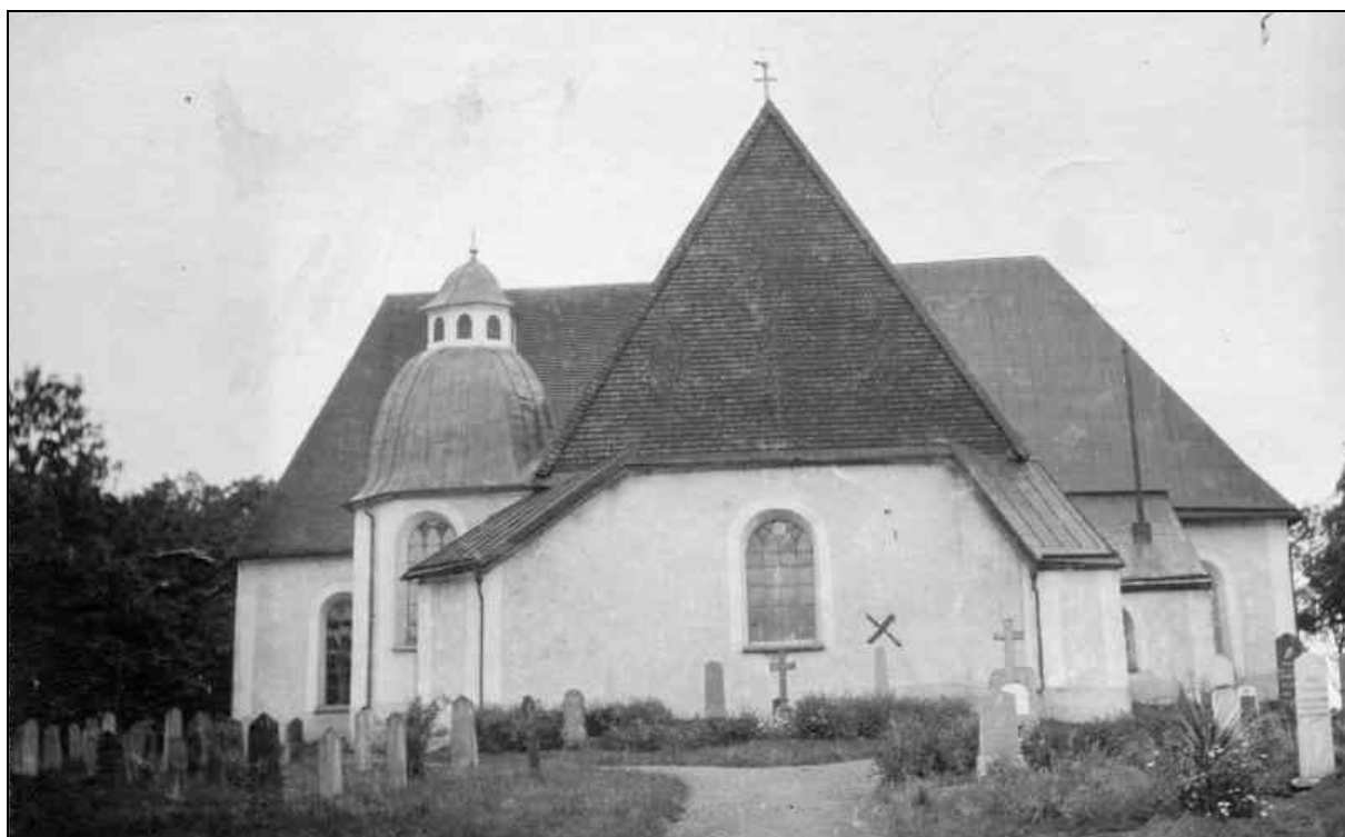
Kyrkan fotograferad från öster 1911 av A. Friberg. Taket är delvis klätt med plåt och fönstret i koret är det som togs upp 1887. Foto i ATA.
