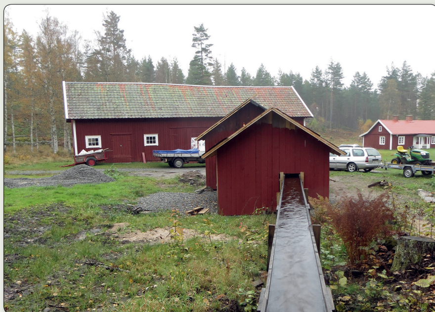
Vattnet leds från den lilla bäcken via en enkel träränna till hjulhuset. Foto Jönköpings läns museum.
