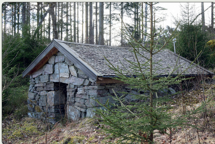
Den lilla stenkällaren fungerade som förvaring av sprängämnen. Taket är klätt med skiffer från platsen. Foto Jönköpings läns museum.
