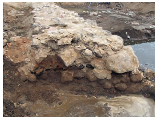
FIGUR 83. Kurtinmuren demoleras i Riksbyggens schakt den 13 mars 2013. Notera markytans nivåskillnad samt resterna efter den äldre ugnskonstruktionen till vänster i bild, på murens landsida. Foto från syd.
