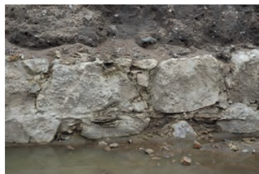
FIGUR 98. Detalj av den bakre väggen i den västra flankens norra kasematt. Murad med stora, grovt tillhuggna stenblock. Spår av vit kalkslamning synliga. Foto från syd.
