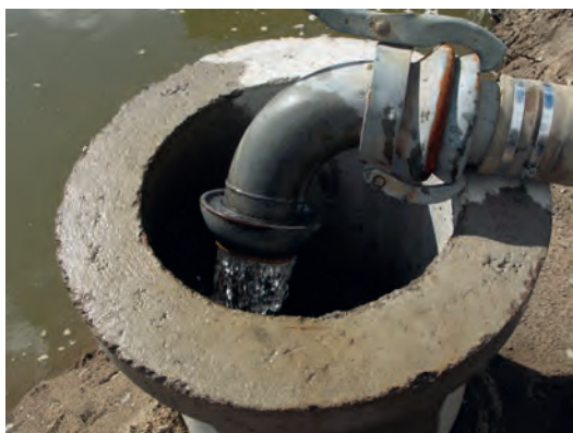
FIGUR 25. Hur man utnyttjar en störning efter bästa förmåga. Den stora dagvattenledning som delade av fältet på Munksjöstranden fungerade som avlopp för vattnet från wellpointsystemet.
