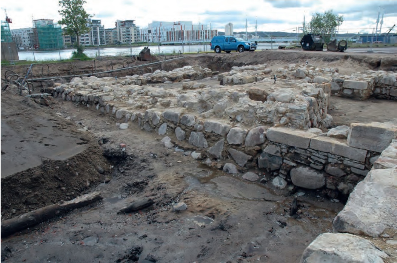
FIGUR 217. Bastion Carolus norra flank, den frilagda fasaden. Man kan ännu se spåren efter de sättningar som ledde till sprickbildningar och ras i byggnaden.
