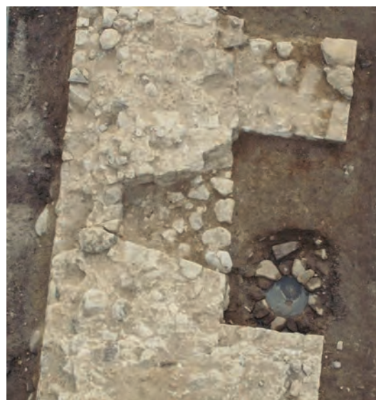
FIGUR 75. Den mittre kasematten med en sekundärt grävd länsbrunn. Notera hur brunnskaret genom sin placering förhindrat att en kanon placerades i embrassyrren.
