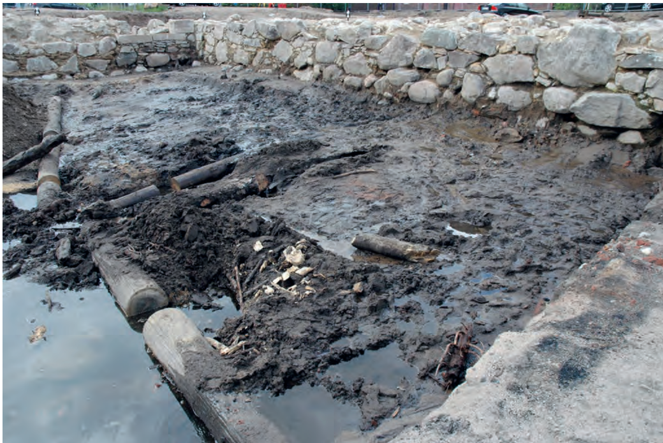
FIGUR 109. Slottets östra kurtin (sjömuren) med framför- liggande timmerkonstruktioner till stöd och som skydd mot vattenerosion. Notera murens enkla, men funktio- nella utförande med natursten eller kluvna block. Foto från nordöst.
