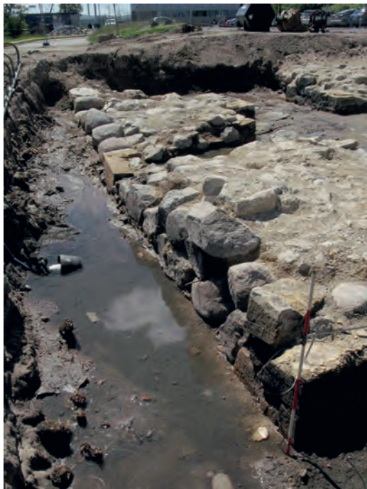
FIGUR 106. Östra fasens fasad, bastion Carolus. I hela sin längd - de 14 meter som avtäcktes - uppvisade murverket spår efter ett större ras. Beklädnadsstenen har rasat ut i Munksjön varefter murverket reparerats på ett osakkunnigt sätt med ett minimum av kalkbruk. Foto från norr.
