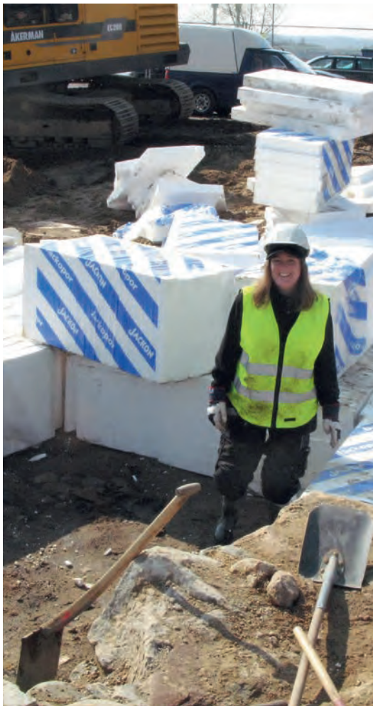
FIGUR 10. Karin har ett lätt arbete. Bortplockning av skyddande frigolitblock från bastion Carolus norra flank..
