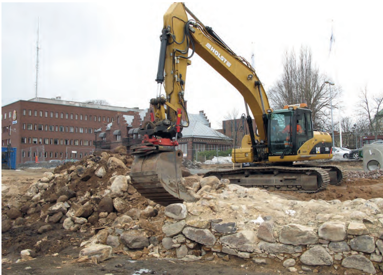
FIGUR 84. Rivning av slottets östra kurtinmur. Ett arbete som trots årstiden gick förhållandevis smidigt. En starkt bidragande orsak var den ringa mängd kalkbruk som använts i murens undre delar.
