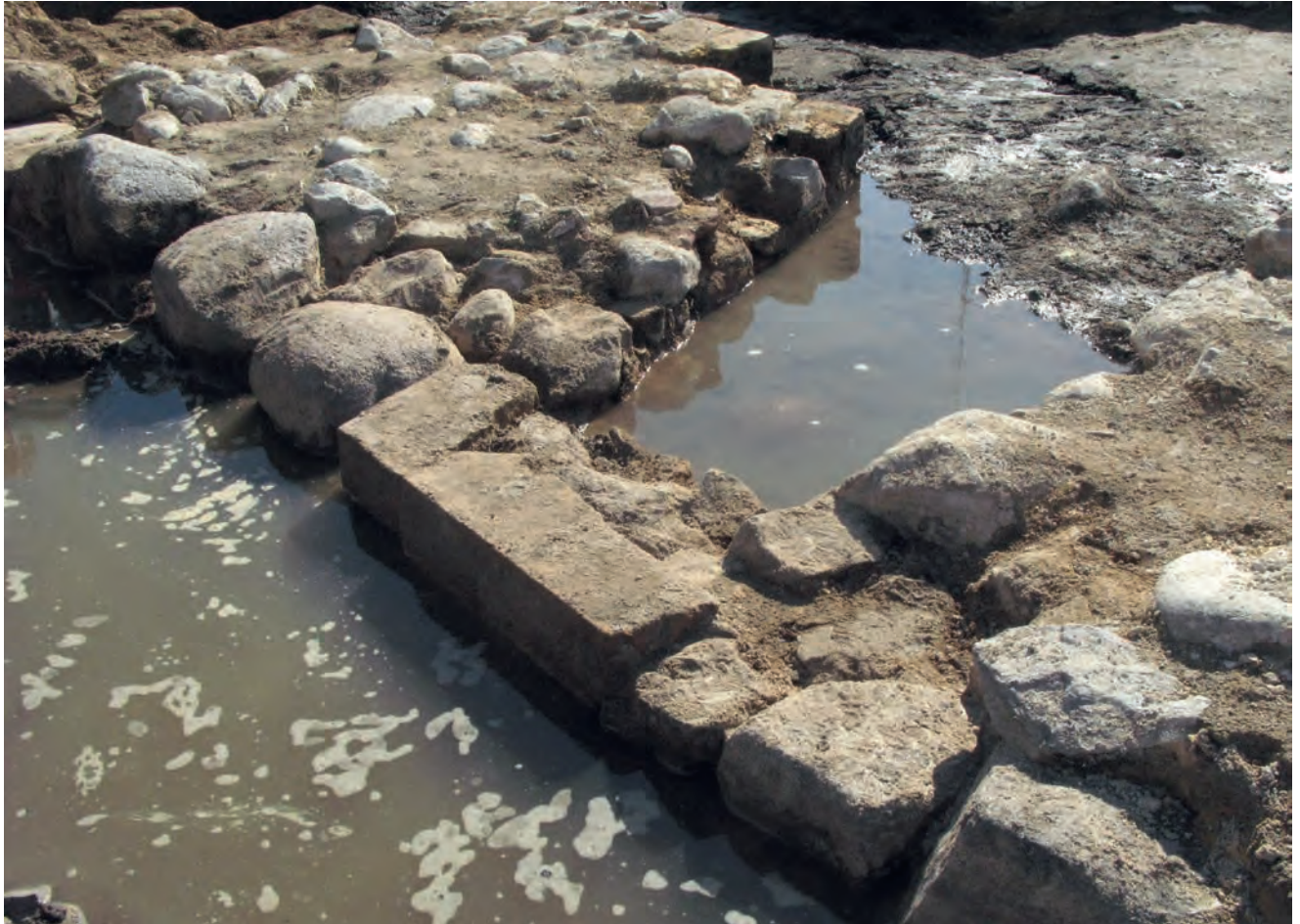
FIGUR 108. Östra fasens fasad såsom den återuppbyggts efter raset. Det friladga skiftet saknar i princip varje spår av kalkbruk och stenmaterialet innehåller helt obearbetade block. Notera också hur en fasad sandstenskvader som bör ha suttit i en hörnkedja nu lagts in som tröskelsten i embrassyrens kanonport! Foto från nordväst.
