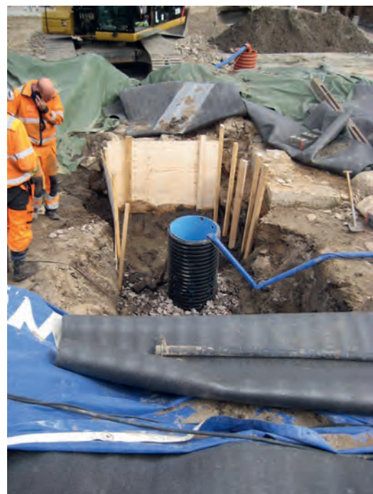
FIGUR 86. Ruinrummets viktiga länsbrunn placeras ut. En förutsättning för att kunna hålla undan grundvattnet.
