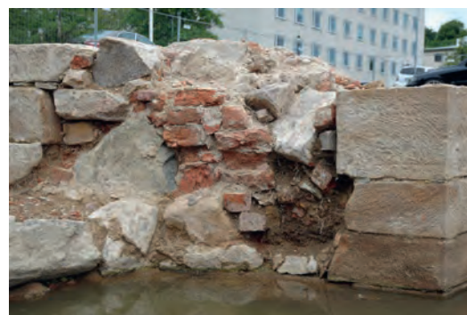
FIGUR 99. Innervägg i den västra flankens norra kasematt. Välhuggen sandsten i hörnkedjor och omfattningar. Återanvänt tegel och oregelbundet murat i själva väggen. Osakkunnigt arbete eller medvetet slarv? Foto från sydväst.
