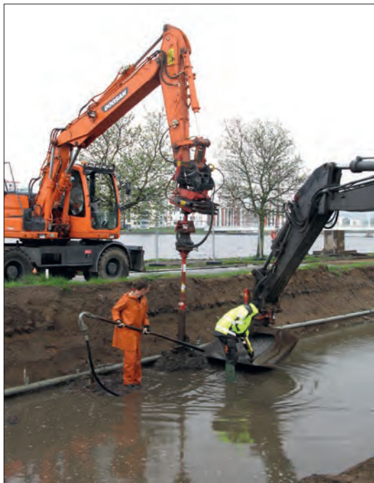
FIGUR 21. Teamet från CRAMO sätter ut det första wellpointsystemet vid Västra kajen, södra delfältet, den 9 maj 2012.
