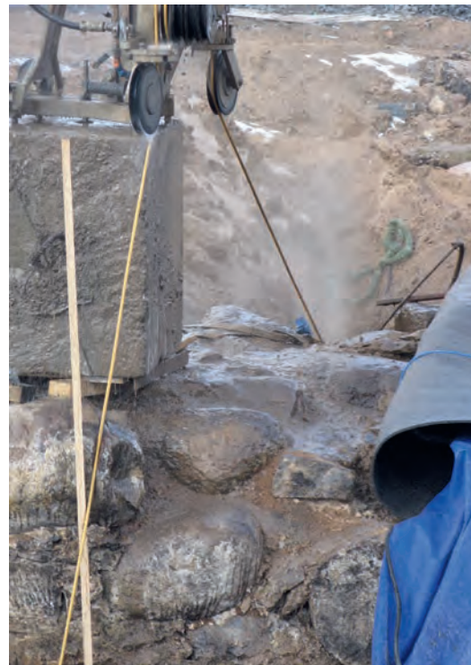
FIGUR 19. Sågning genom kurtinmuren i mars 2013.
