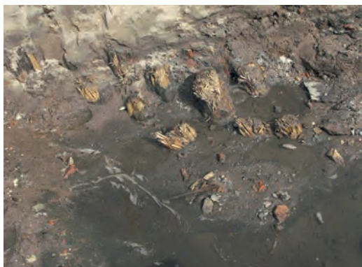
FIGUR 107. Skyddspålning placerad i Munksjön alldeles utanför bastion Carolus nordöstra hörn. Pålarnas fällningsår bestämdes till 1624, 1625 och 1631. På samma plats inträffade fasadrasen en bit in i 1700-talet.
