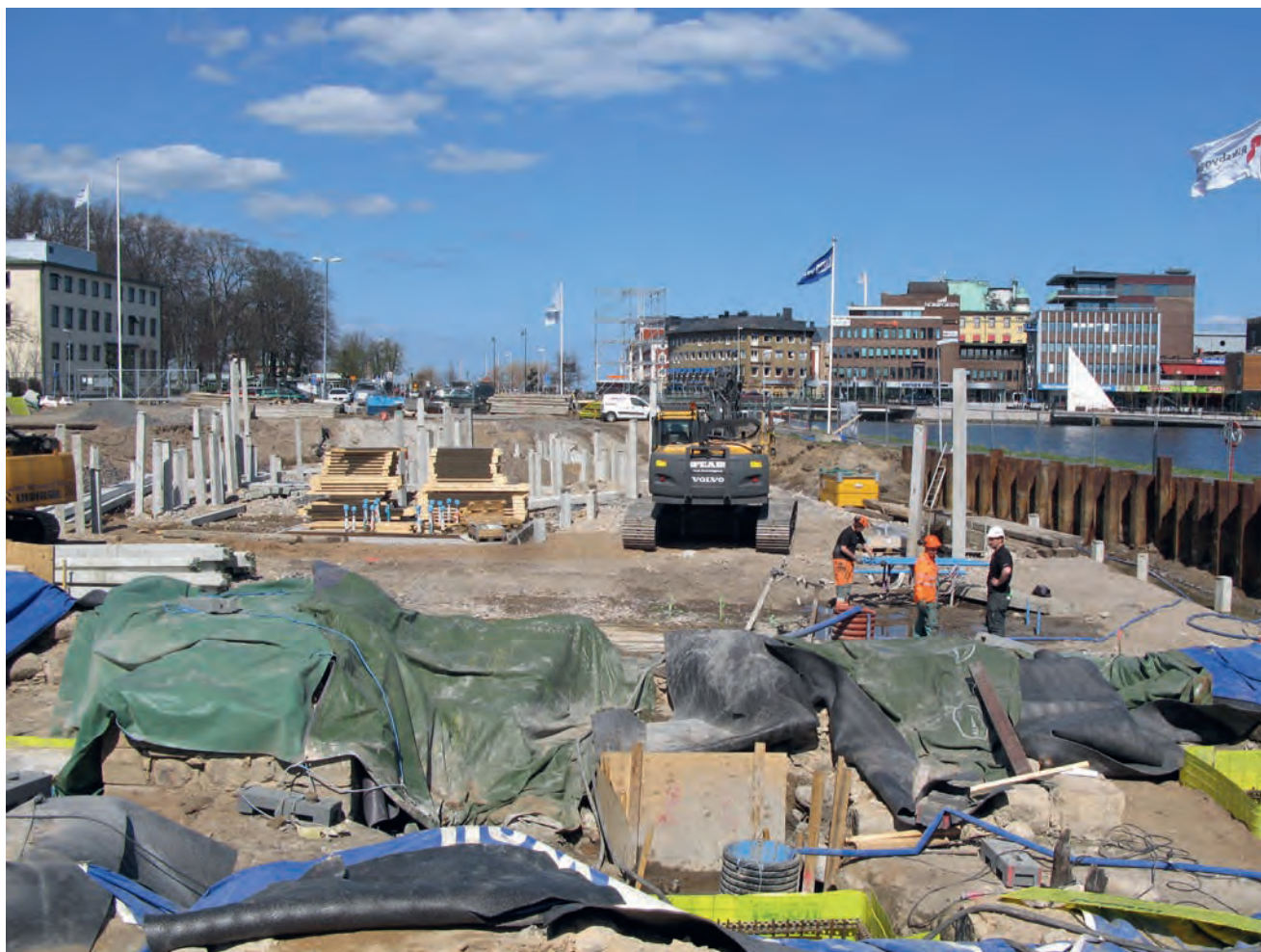
FIGUR 87. Bastion Carolus - byggarbetsplats igen, efter 400 år. I förgrunden de skyddsövertäckta murar som sparats i källaren under Riksbyggens hus.
