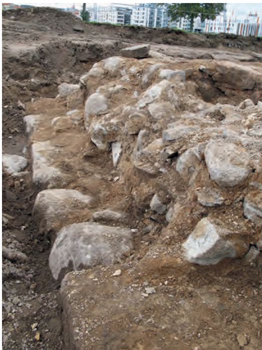
FIGUR 51. Den nedbrutna fasaden på bastion Carolus norra flank. Bara syllstenarna och murkärnans nedersta del har lämnats kvar vid demoleringen på 1830-talet. Foto från väst.
