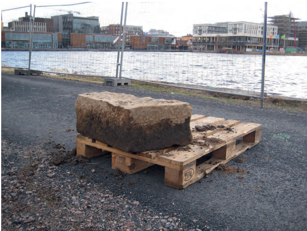
FIGUR 181. Finhugget sandstensblock försett med stenhuggarmärke i form av ett D eller möjligen G . Avsett till hörnkedja i bastion Carolus (F543)..
