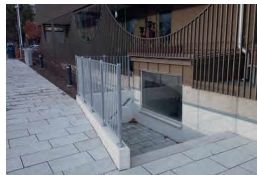
FIGUR 228. Fönster in mot ruinrummet från husets södra fasad.
