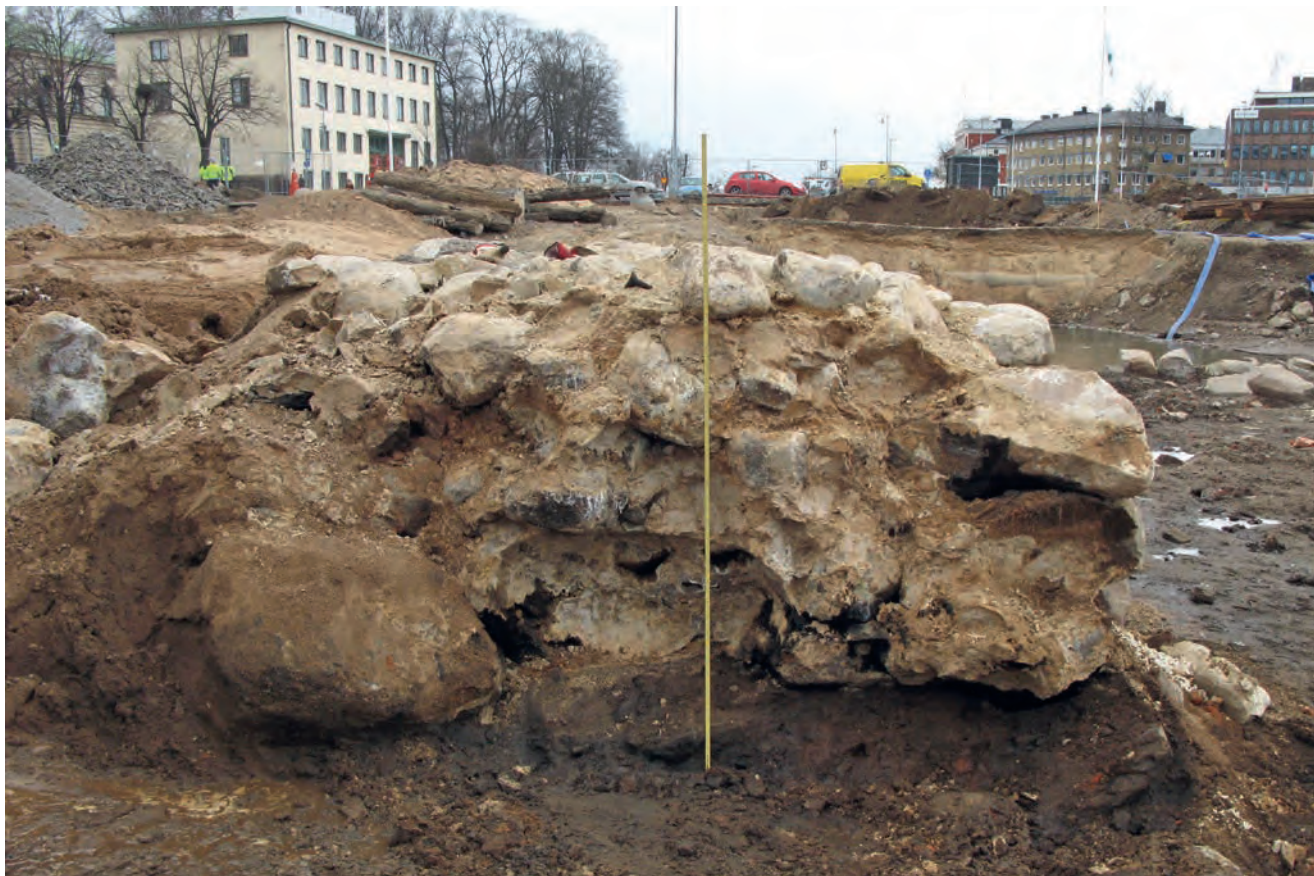
FIGUR 111. Snitt genom slottets östra kurtin/ sjömmuren. Skådesidans kluvna stenar och jämförelsevis släta yta kan jämföras med borggårdssidans dolda terrassmur. Foto från syd.
