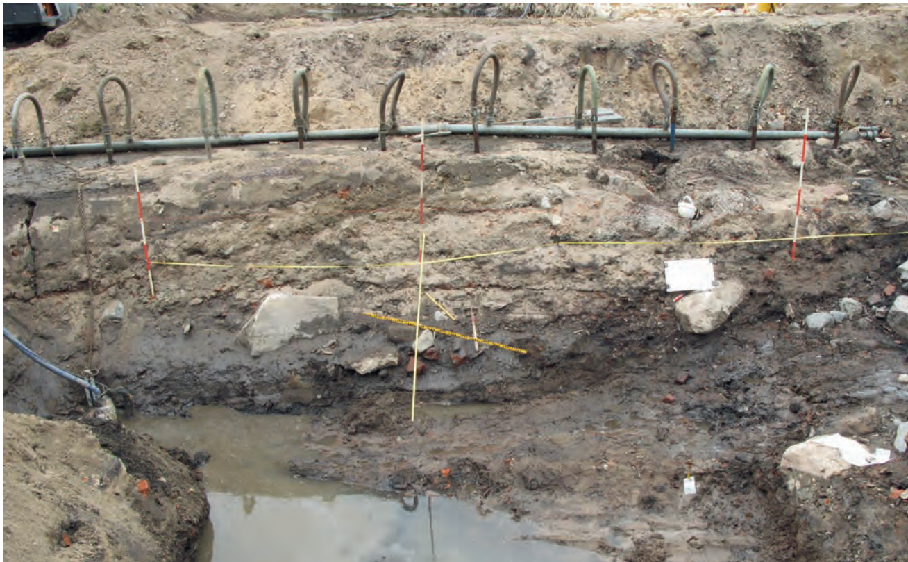
FIGUR 70. Mellan det norra och södra delfältet sparades en bank eftersom kommunens stora dagvattenledning dragits just här. I den rensade sektionen mot söder syns tydligt hur brant den ursprungliga sjöbotten har sluttat mot öster.
