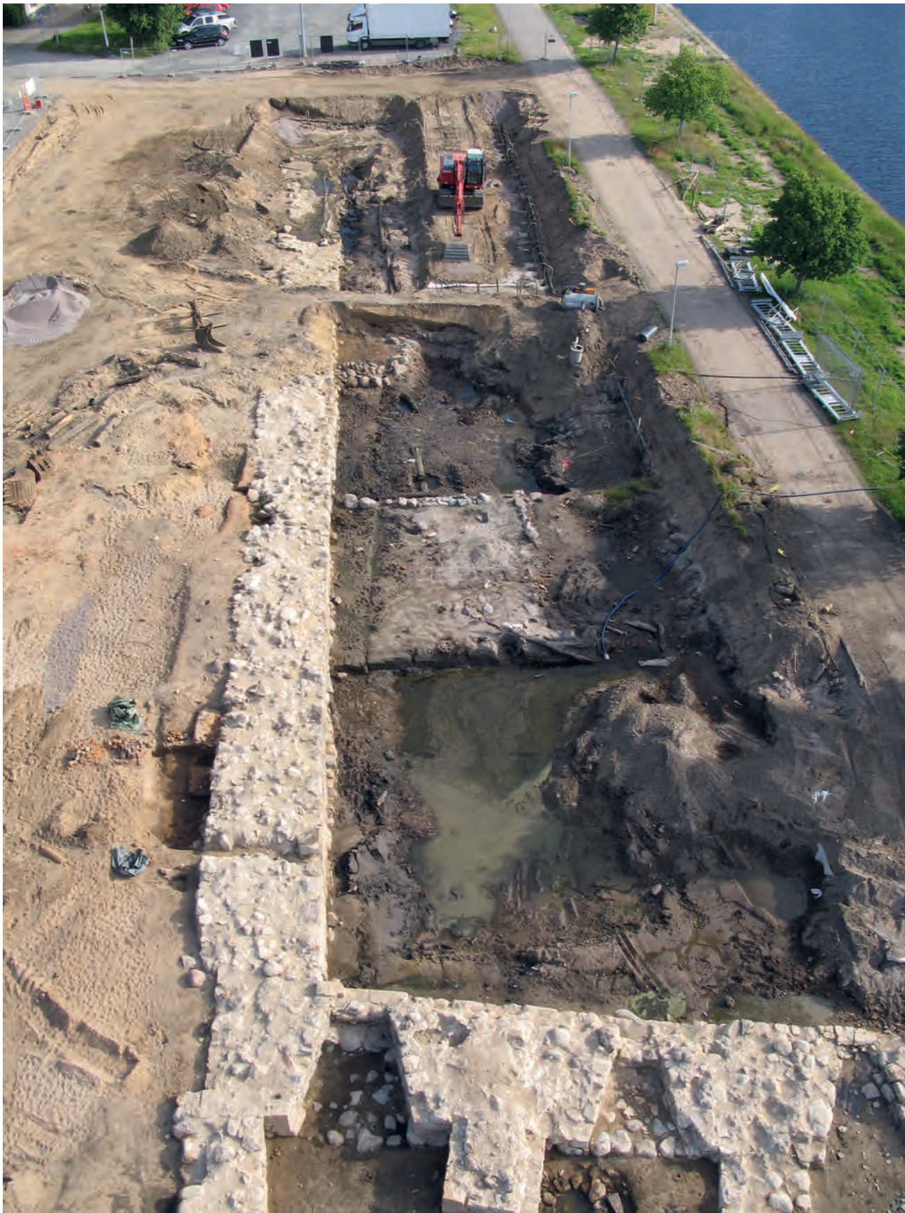
FIGUR 113. Den östra kurtinen (sjömuren) frilagd i hela sin i schakten bevarade utsträckning. Notera hur fullmuren slutar i höjd med grävmaskinen, en bit in i det norra delfältet (A44/12). Detta bör motsvara det skilje som Fleming markerade på sin avbildning 1617. I det hitre delfältet syns även grunden till Vattenkonsten (pumptornet) samt delar av verkstadsbyggnadens stensyll. Foto från syd.
