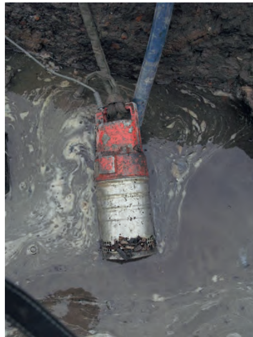
FIGUR 26. Dränkpumpen - en tillfällig, men nödvändig lösning vid arbete intill Munksjön, på nivåer som låg under dess nuvarande vattenyta.
