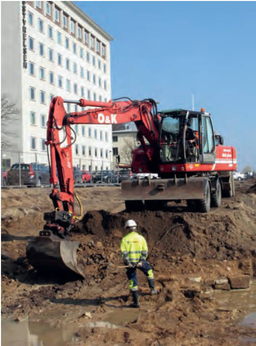
FIGUR 5. Varsam framschaktning av den västra flankens murar i bastion Carolus. Ann-Marie Nordman övervakar.
