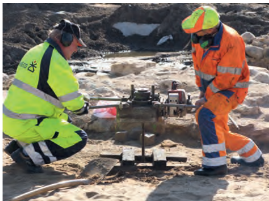
FIGUR 22. Provbörning i bastion Carolus den 3 juli 2012. Enda sättet att skaffa ett kunskapsunderlag inför pålning i ruinen.
