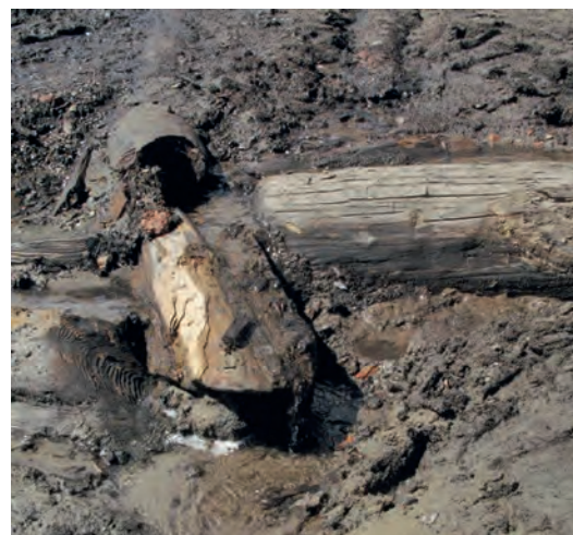
FIGUR 127. Väl utförd knutning på timmerterrassens sjöside.
