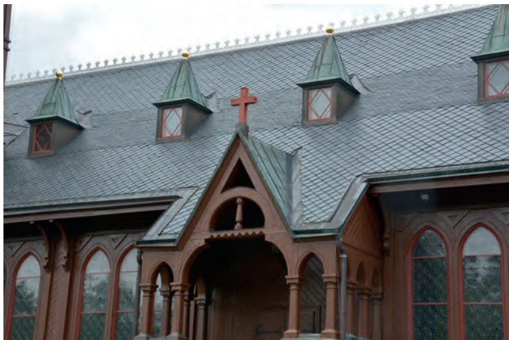
Den södra entrén, målad och färdig med det rödtjärade korset.
