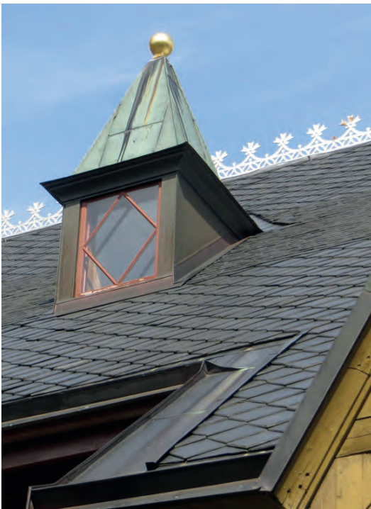
Ett av takfönstren före målning.
