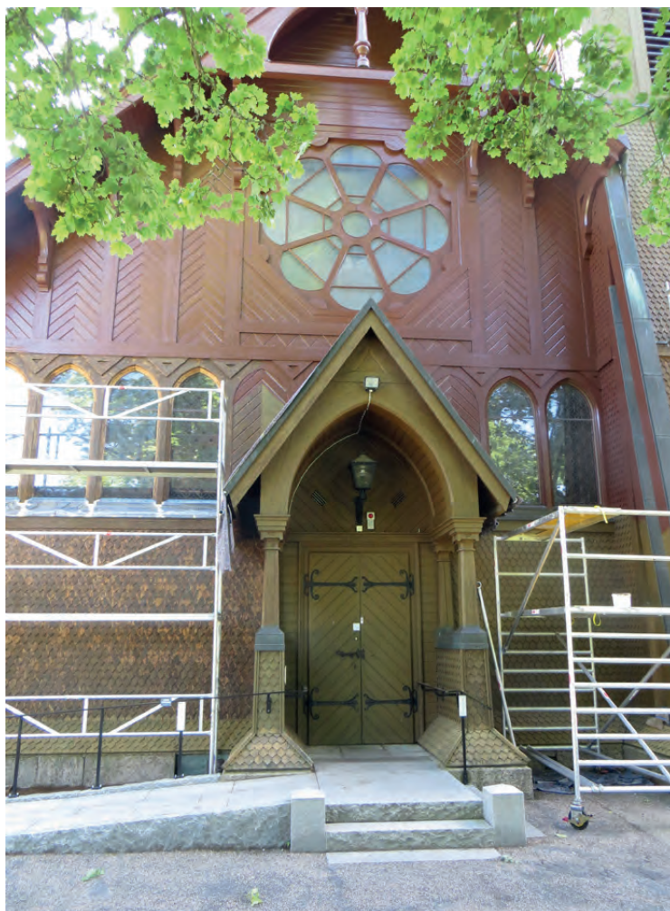
Pågående målning av den västra gaveln. Den nedre delen, till vänster i bild, är skrapad och där kan man ana den ursprungliga bruna kulören.
