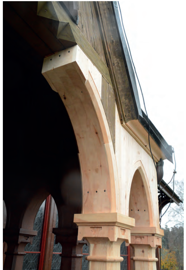
Den lagade valvbågen, södra entrén.
