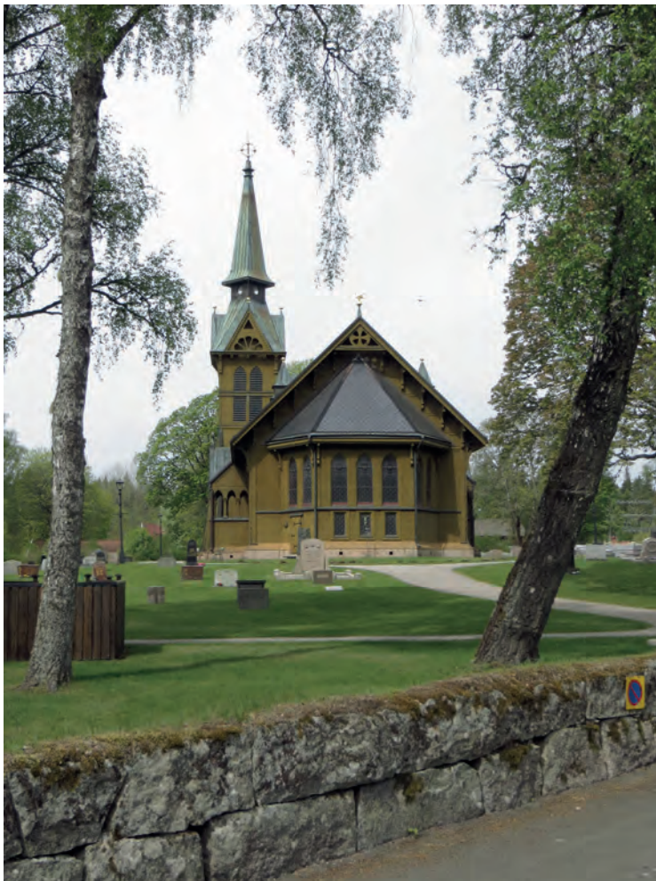
Nykyrka kyrka från öster före åtgärd.
