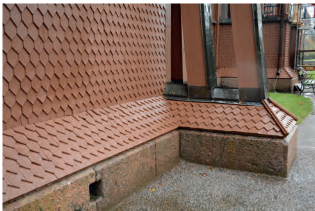
Detaljbild socken. På kopparplåten vid stödbenen noterades klisterrester efter maskeringstape.
