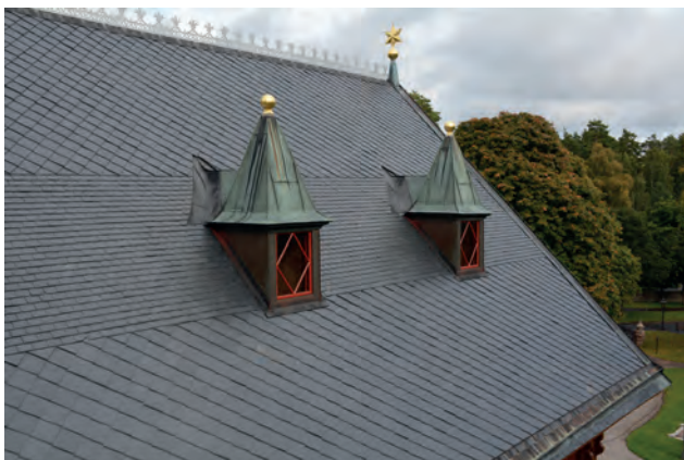
Ovan och till höger: takfönster besiktigade från lift.
