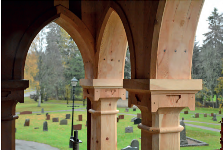
De lagade valvbågarna och kapitälerna, södra entrén från insidan.
