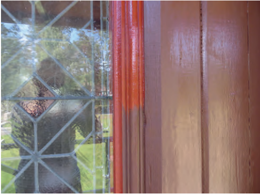
Provmålning av ett fönster för att bestämma hur långt ut på karmen vi skulle måla.
