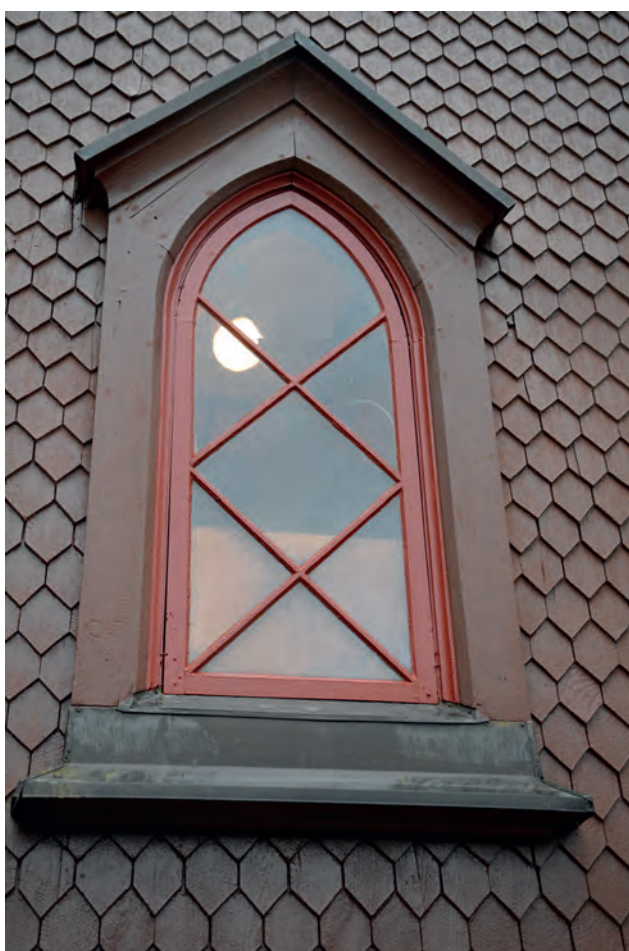
Ett av fönstren i tornet.
