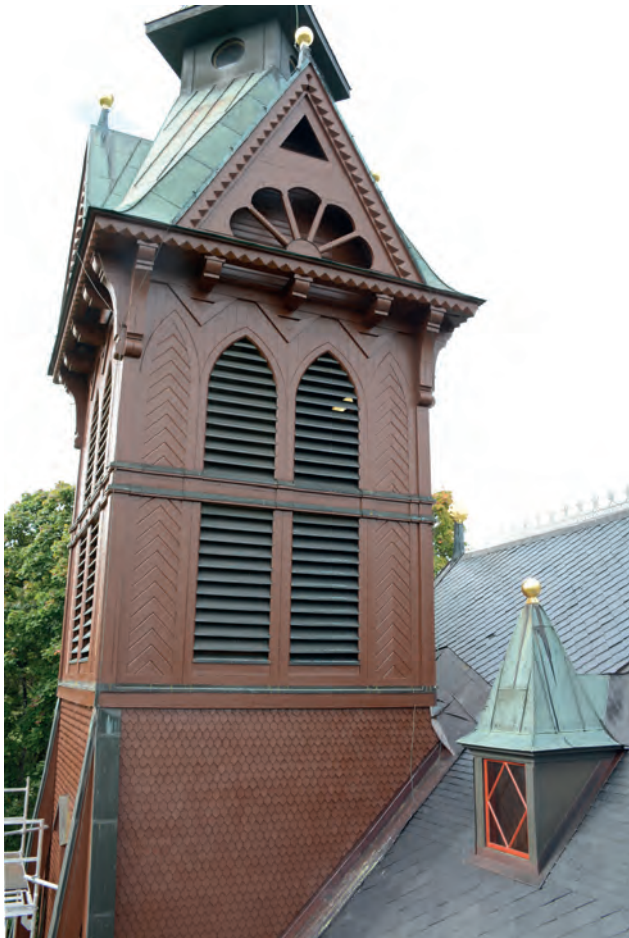
Ovan och till höger: tornet, besiktigat från lift.
