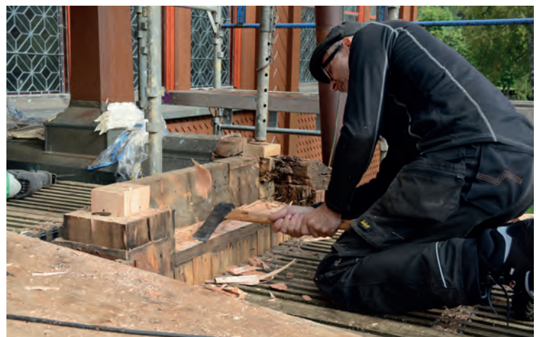
Pågående lagningar vid södra entrén, timmerman Mats Renström.
