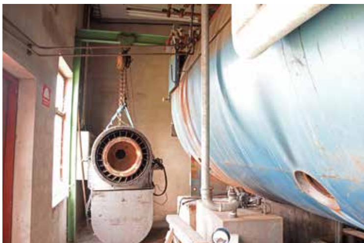
Värmecentralen öster om Linneån står i princip som den lämnades. Oljetankar är sanerade.
