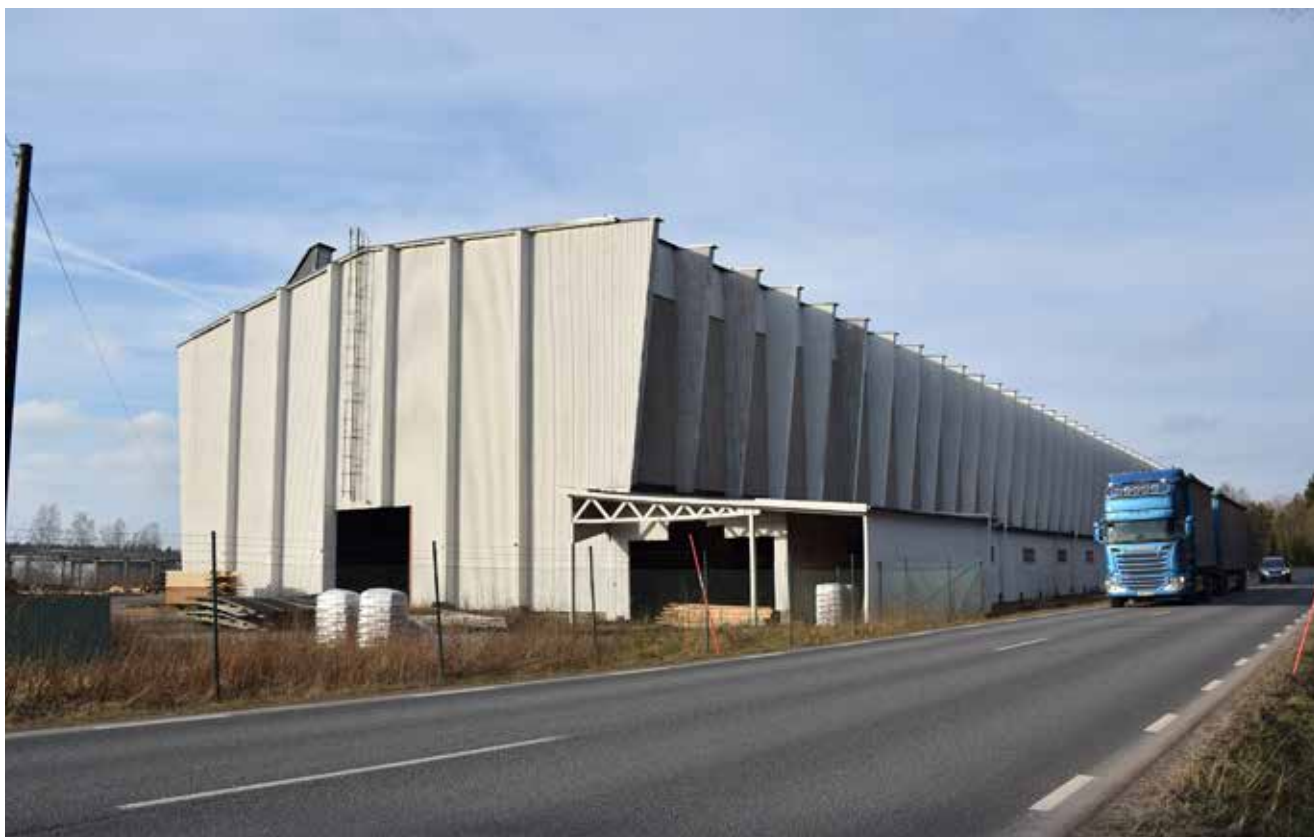
Virkesmagasinet från sydost, vid Fröderydsvägen.
