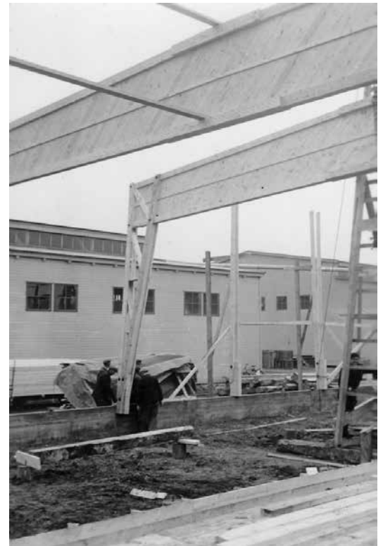
Monteringen av takstolarna, HB-balkarna.
