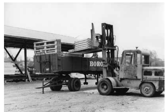
En av utlastningsbryggorna när verksamheten var i drift.
