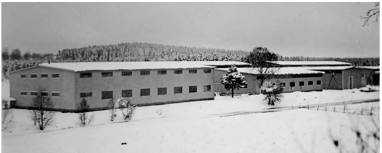
Snickerilagret, målarverkstaden och luckmålningsverkstaden från nordost.
