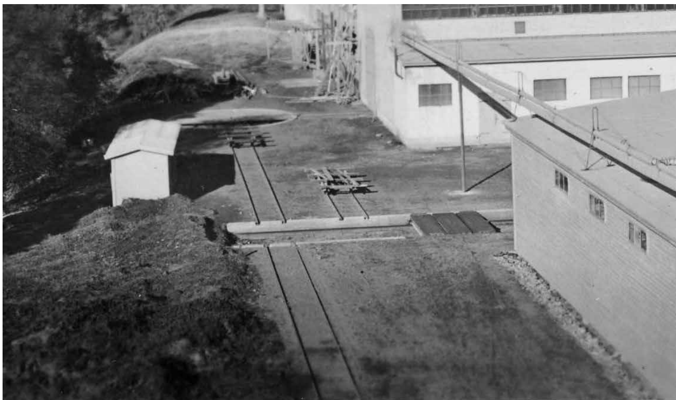
Marktraversen norr om takhallen. Vid sidan om byggnaden syns ett skjutbord som nyttjades för att växla vagnar och trallor. Vid sidan om måleriverkstaden syns en vändskiva.
