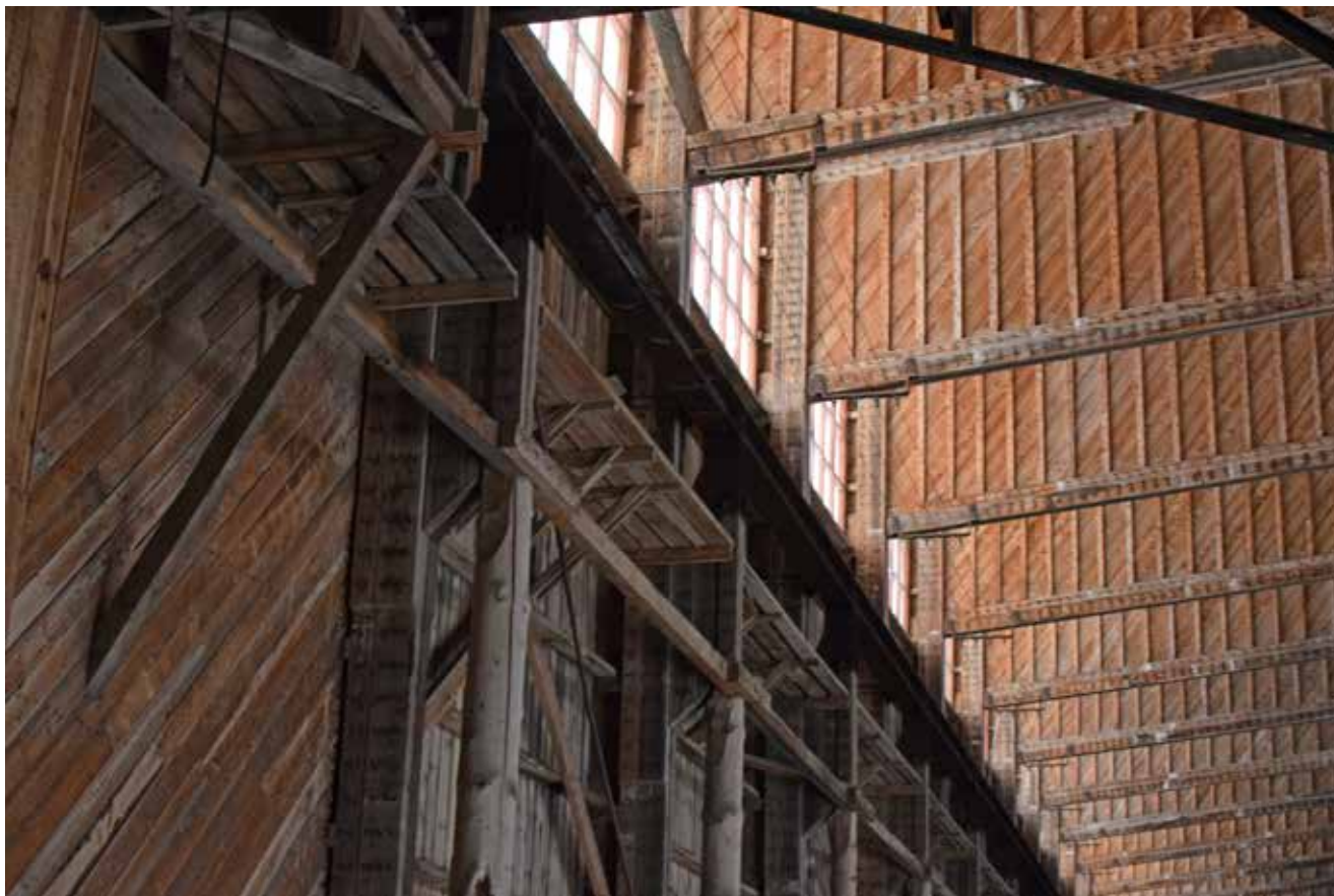
De bärande stolparna är dels spikade bjälkar dels helt rundtimmer som enbart är barkat.
