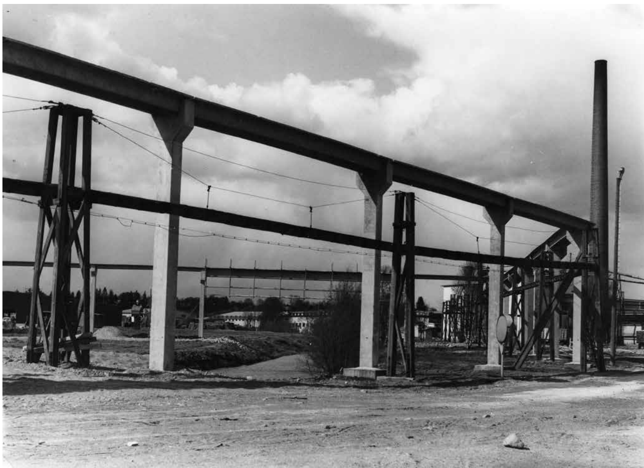
De nya ledningsstolparna av betong är uppförda, men de äldre trästolparna står fortfarande kvar. Fotografiet är troligen från 1964 då marken för den kommande fabriken är under beredning.
