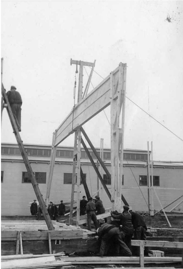
Resning av takbjälkar till kap- och målarverkstaden hösten 1939 (sedemera hyvleriet).
