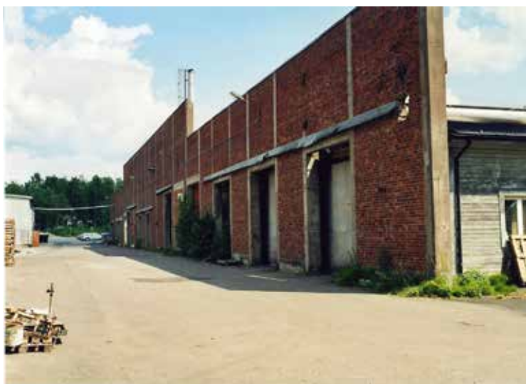
Brandmuren norr om takstolshallen 2010. Foto: Ola Korsfeldt.
