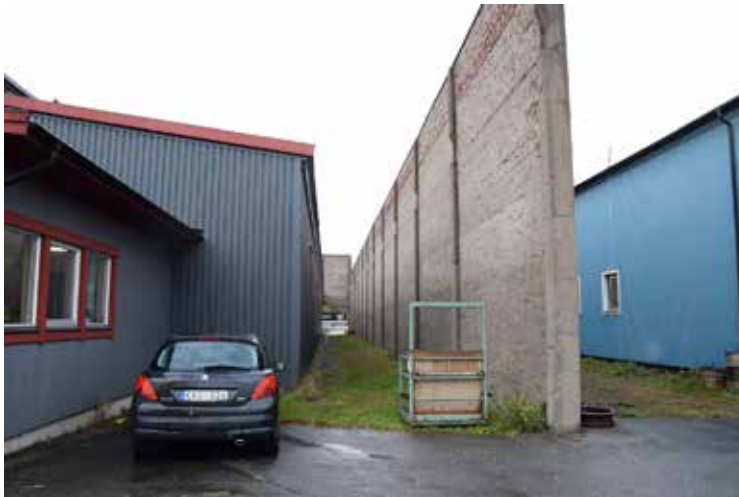
Brandmuren mellan takhallen och hyvleriet, numera DecorPanel och Landsbrostugan.
