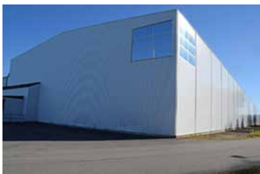
Ovan: Detalj av hallens nordöstra del.
