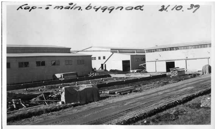
Bygget av kap- och målarbyggnaden, sedan hyvleri, hösten 1939.
