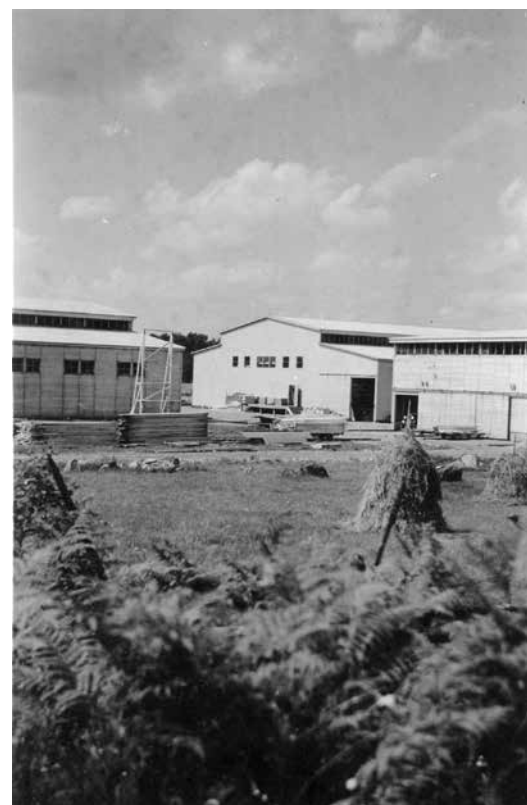
Takstolshallen till vänster i bild under uppförande. Till höger spikhallen och hyvleriet. Bilden är antagligen tagen sommaren 1938, direkt efter övertagandet av marken, då den tidigare arrendatorn skördar höet (notera krakarna i förgrunden).
