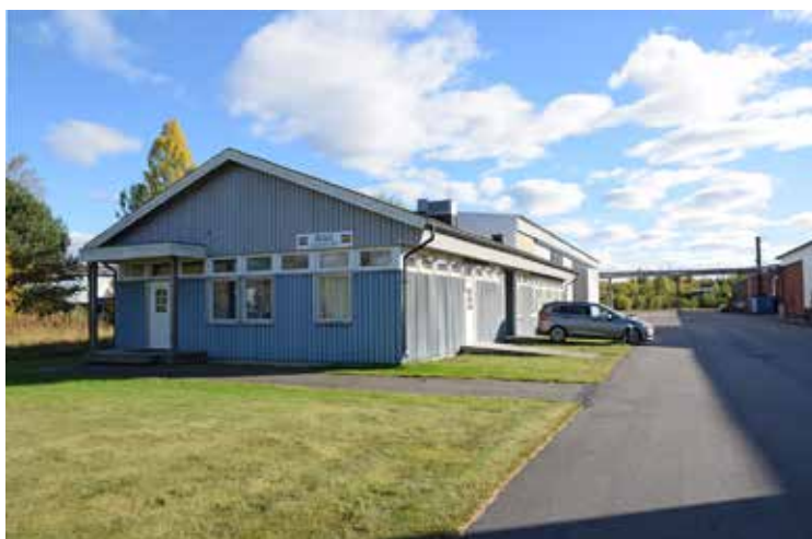
Den tidigare personalbyggnaden som nyttjas av Hegu.
