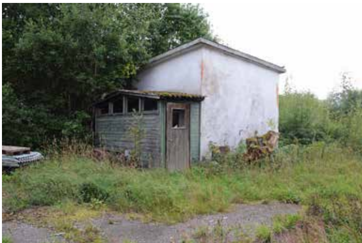
Söder om virkestorken ligger en tidigare transformatorstation samt ett litet anslutande personalutrymme som inrymde stämpelklocka för de som jobbade på denna del av området.
