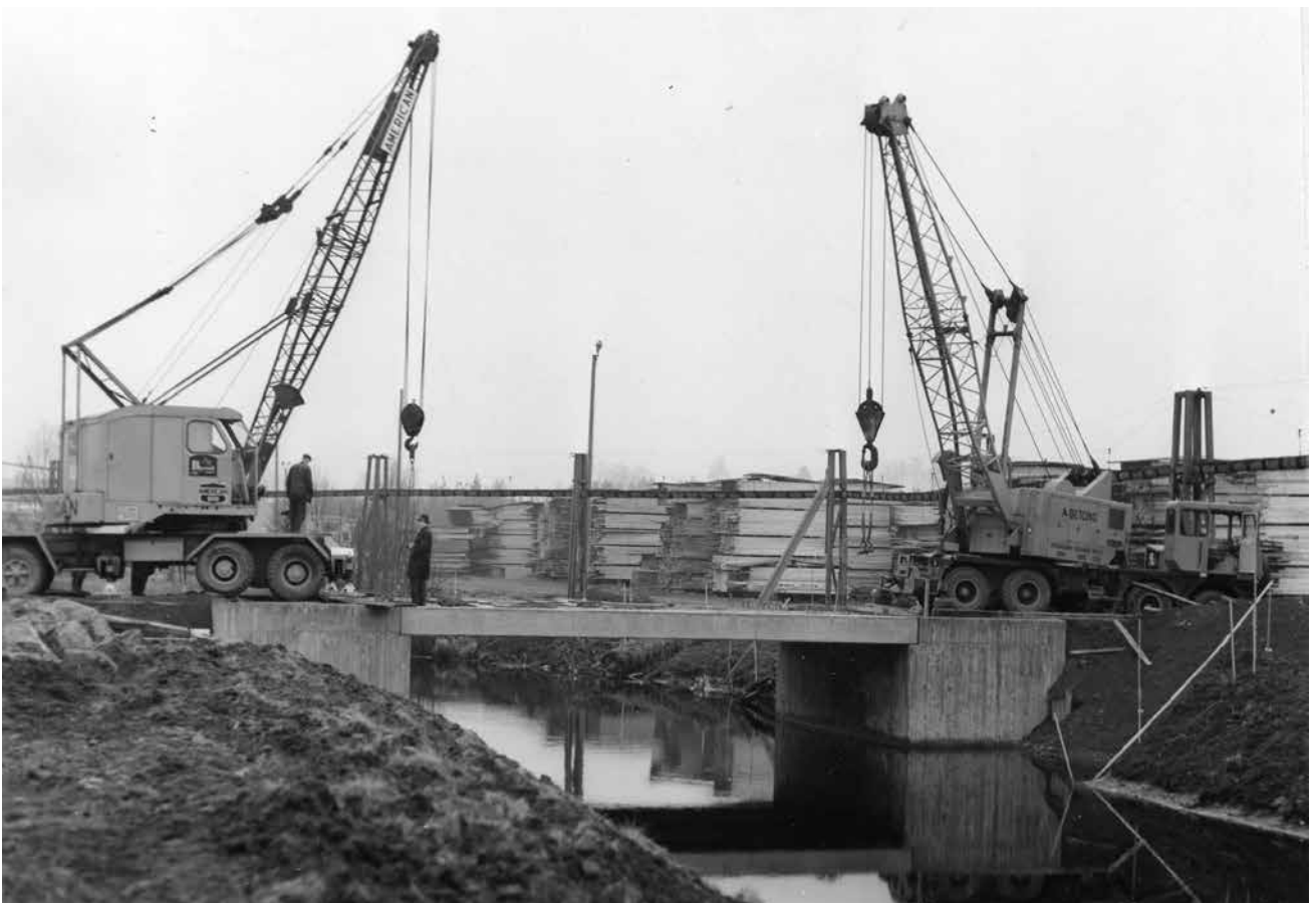
Den södra bron över Linneån under uppförande.
