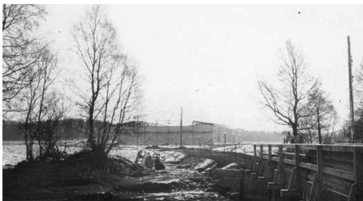
Spikhallen under uppförande. Järnvägsspåret är anlagt och träbron över ån uppförd, troligen gjordes den först för att kunna underlätta transporten av virket till spikhallen.
