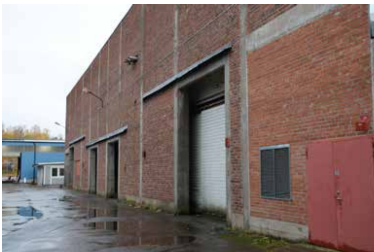
Brandmuren norr om takhallen.
