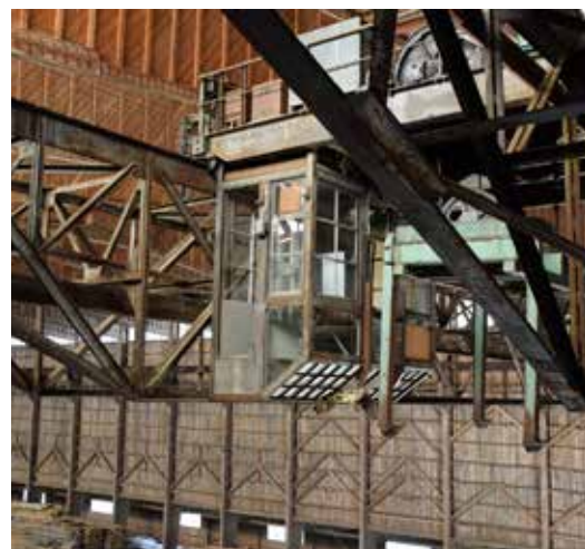
Traversens manöverhytt är bevarad.
