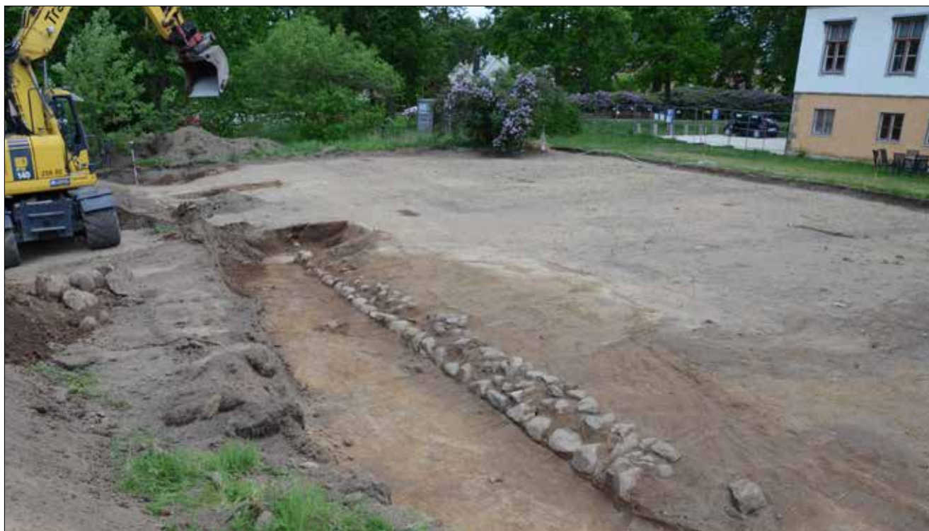
Figur 17 Den framschaktade stödmuren som löpte längs med herrgården och parterren i nord - sydlig riktning. Den raka kanten på muren, mot grävmaskinen, visar att detta var murens skådesida. Skådesidan var den sida av muren som skulle synas. Foto från sydväst.
