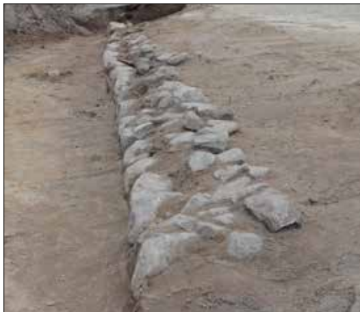
Figur 18. Detalj av den nord-sydligt liggande muren som varit en stödmur för terrassen. Här syns den raka skådesidan. Foto från söder.
