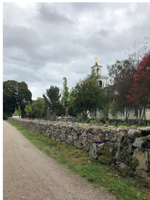
Den kallmurade kyrkogårdsmuren sedd från väster.
