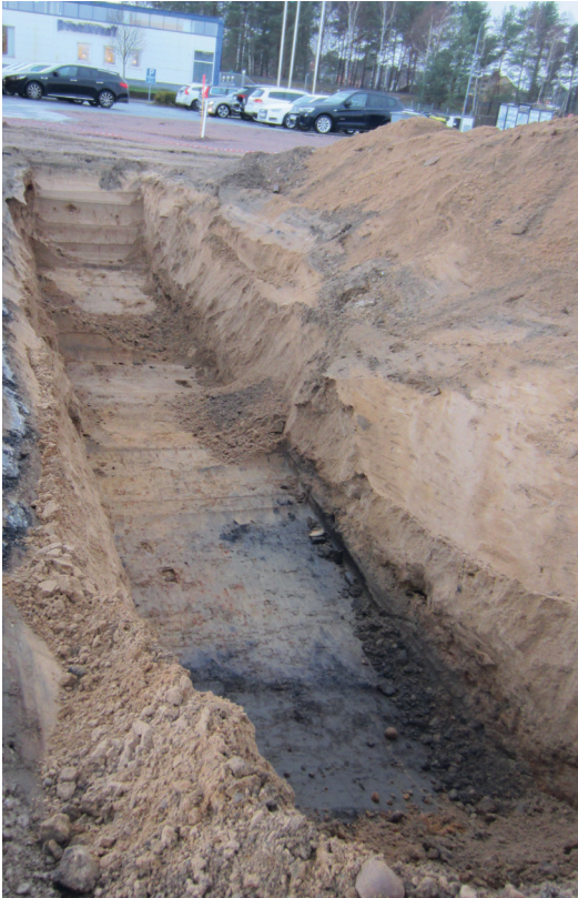
Figur 11. Schakt 28 med den svartfärgade nivån efter stillastående vatten i strandbrynet. Foto från N.
