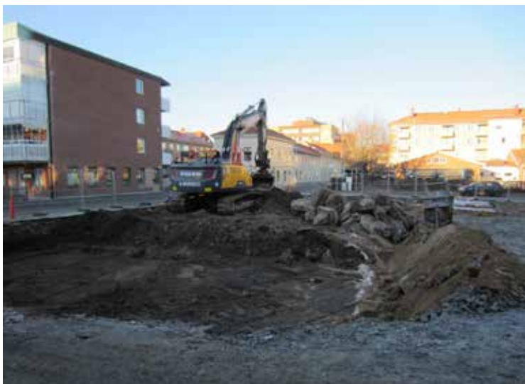
Figur 9. Schaktning för provrutor i det nordvästra hörnet av tomten. Provrutan ovan verkstaden har precis schaktats klart. Sol men flera grader minus. Foto från sydöst.
