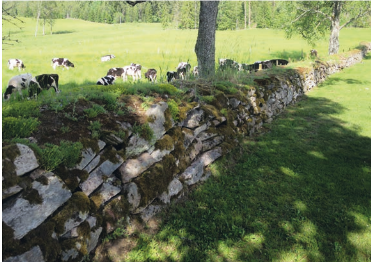
Utvidgade östra delen har en något lägre och smalare kyrkogårdsmur. Östra delen utgör en hög stödmur mot omgivningarna i norr och öster.
