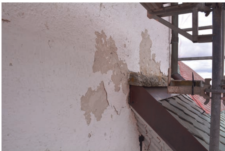
Detalj av putsskador i anslutning till långhusets tak.
