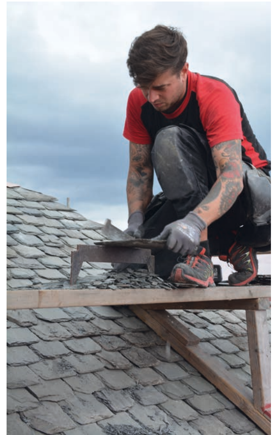
Ovan: Kanthuggning av skifferplattor för inpassning avnockarna.
