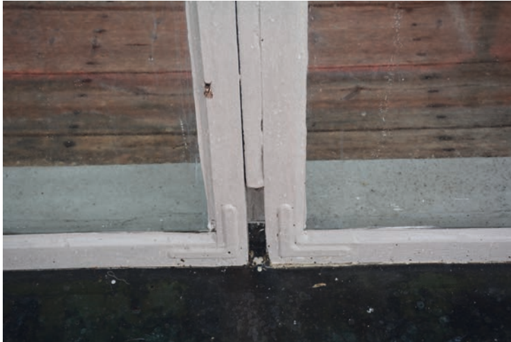
Ett av lanterninens fönster efter åtgärd.
