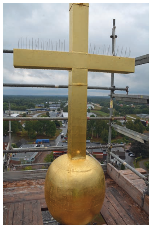
Ovan: Det omförgyllda korset med dess klot besiktigades innan ställningen revs.
