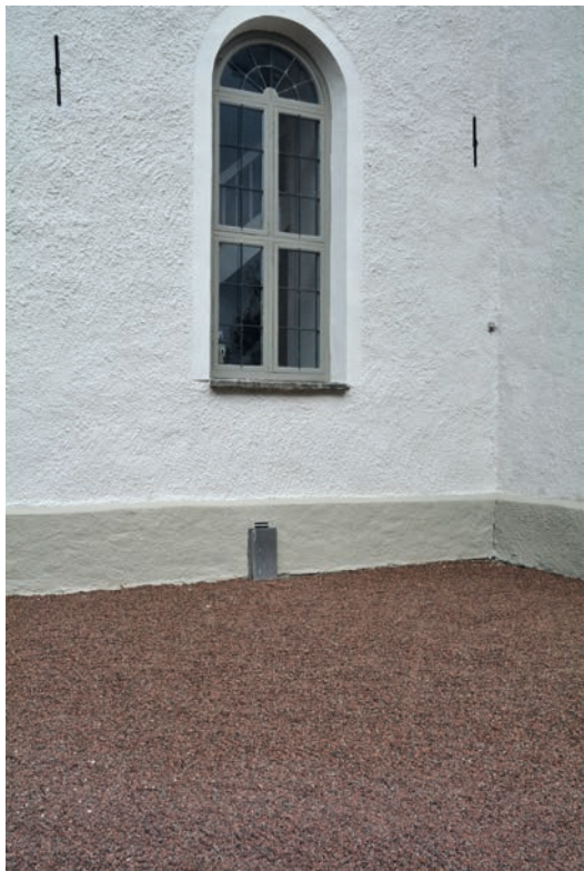
Tornets södra fasad vid slutbesiktning.
