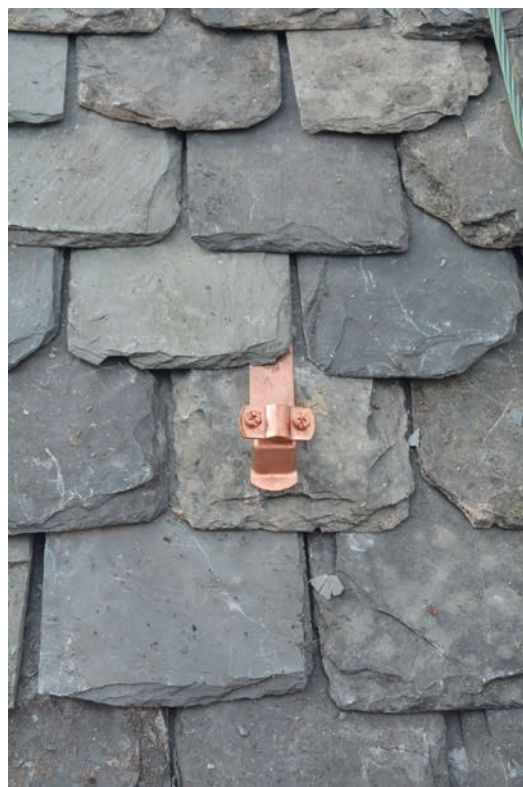
Beslagen till åskledaren byttes.
