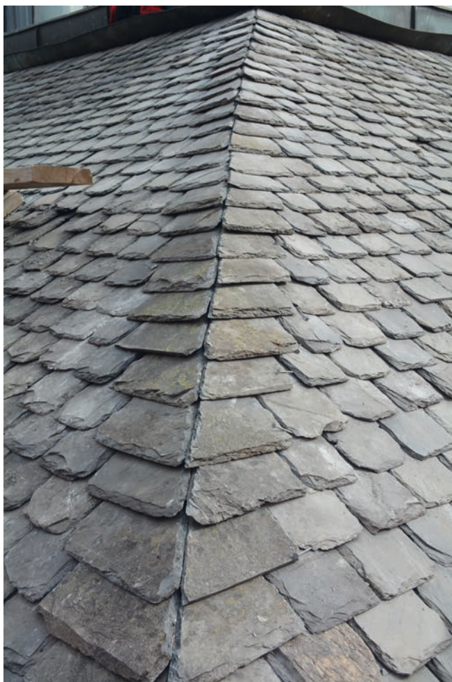
Detalj av den färdiga nocktäckningen.
