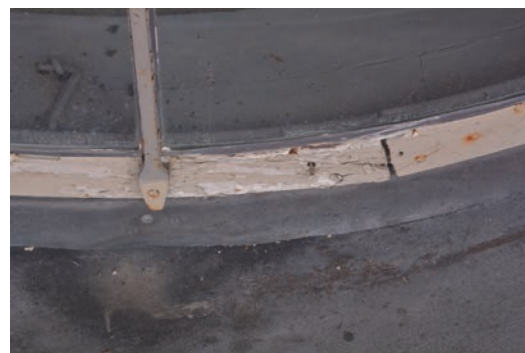
Detaljbild av det runda fönstret i tornets västfasad före åtgärd.
