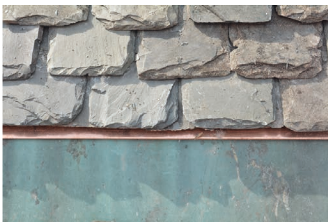
Underbeslag av koppar lades i skiffertakets nedkant.
