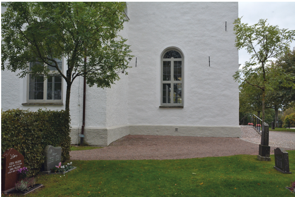
Tornets norra fasad vid slutbesiktning. Fasaden är avfärgad fram till mötet mellan torn och långhus. Sockeln är avfärgad fram till långhusets hörn mellan den västra och norra sidan.
