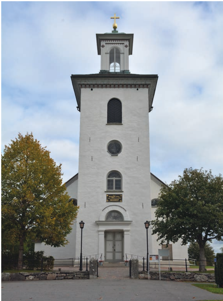
Bredaryds kyrka, översikt efter avslutad åtgärd.
