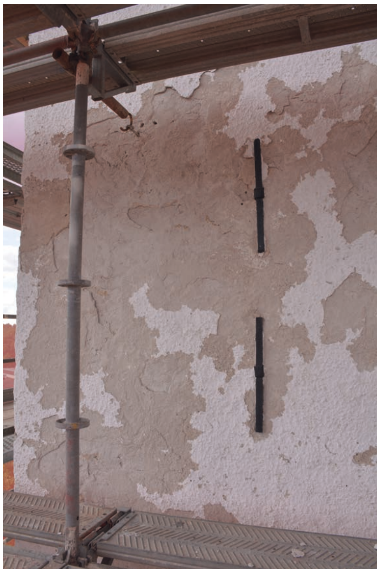
Detalj av putssläpp på tornets södra sida inför åtgärd.
