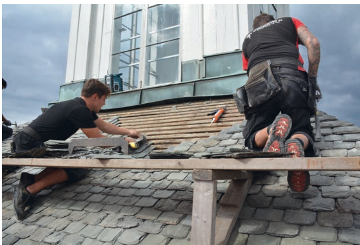
Ovan: Kanthuggning av skifferplattor för inpassning avnockarna.
