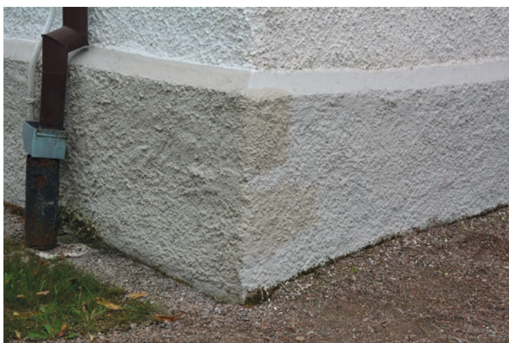
Färgprover på sockel inför avfärgning. Tornets sockel och långhusets västsidas sockel var struken i en ljusare kulör än sockeln i övrigt, vilket gjorde att kulören sattes mot långsidans sockelkulör.
