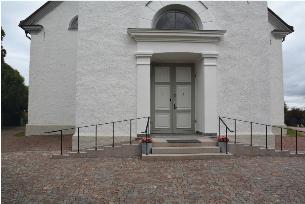
Översikt västfasaden vid slutbesiktning. Ytan till höger om porten är omputsad men inte den vänstra. Hela tornets fasad är dock avfärgad.
