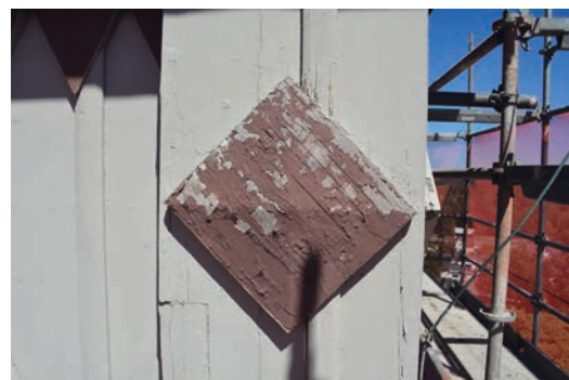
Detalj av lanterninen före åtgärd.
