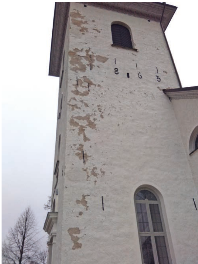
Tornets södra fasad före åtgärd. Foto: Kristin Balksten.
