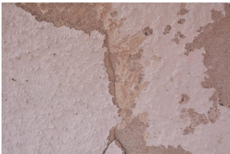
Det gula putslagret under befintlig puts.
