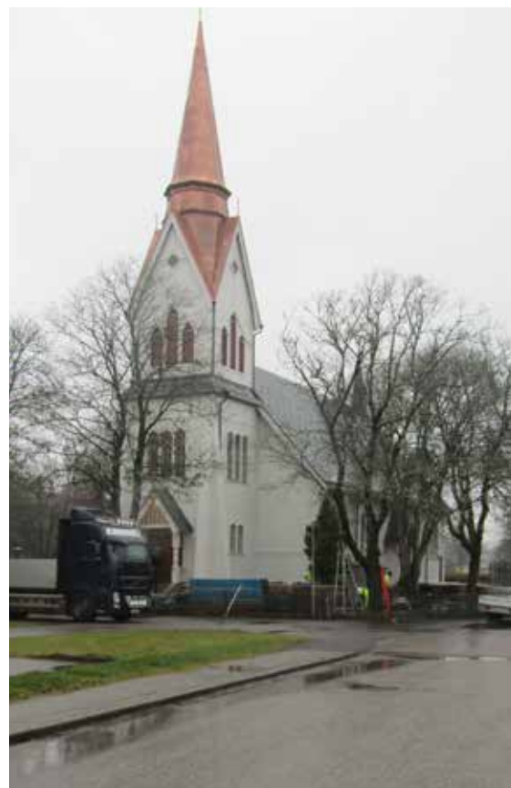
Ovan: Kyrkan vid slutbesiktningen sedd från söder. Till vänster: Kyrkans östra ingång efter avslutade arbeten. Här ser man dörrfodrens nya avslut nedtill.
