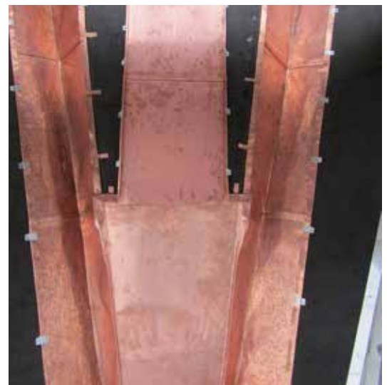
Ovan: För att undvika långsmala plåtskivor gjordes så kallade amerikanare, vilka innebär att de smala spetsarna ersätts med en lite bredare plåt. Till vänster: Det lagade korset högst upp i spiran inför målning och förgyllning.
