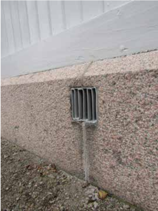
Parti av sockeln med ny åsfog och målat ventilgaller.
