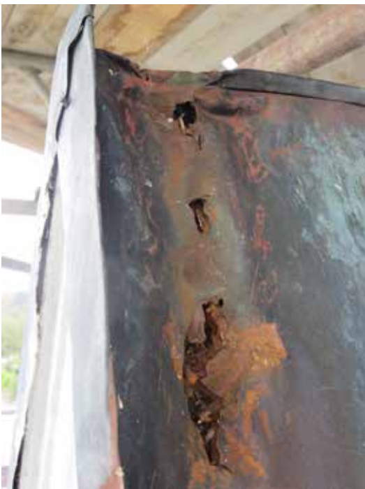
Ovan: Gavelmotiven längst ner på spiran kröntes av smidda dekorationer som var monterade genom plåten varvid vatten hade trängt in. Till höger: Vissa delar av spirans stomme hade omfattande rötskador och var i princip ihålig.
