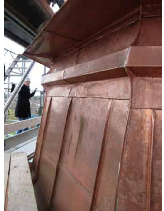
Ovan: Nylagd plåt på spirans nedre del. Till vänster: Innan den nedre delen kunde kläs med plåt fick omfattande rötslador lagas i.
