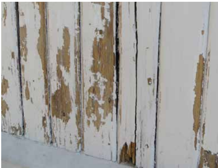
Ovan: Ett parti av den södra gaveln hade rötskador och svampangrepp. Till vänster: Den södra gaveln innan man bröt loss skadade delar av panelen.
