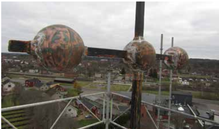
Ovan: För att undvika långsmala plåtskivor gjordes så kallade amerikanare, vilka innebär att de smala spetsarna ersätts med en lite bredare plåt. Till vänster: Det lagade korset högst upp i spiran inför målning och förgyllning.
