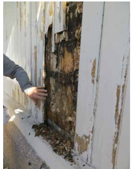
Ovan: Ett parti av den södra gaveln hade rötskador och svampangrepp. Till vänster: Den södra gaveln innan man bröt loss skadade delar av panelen.
