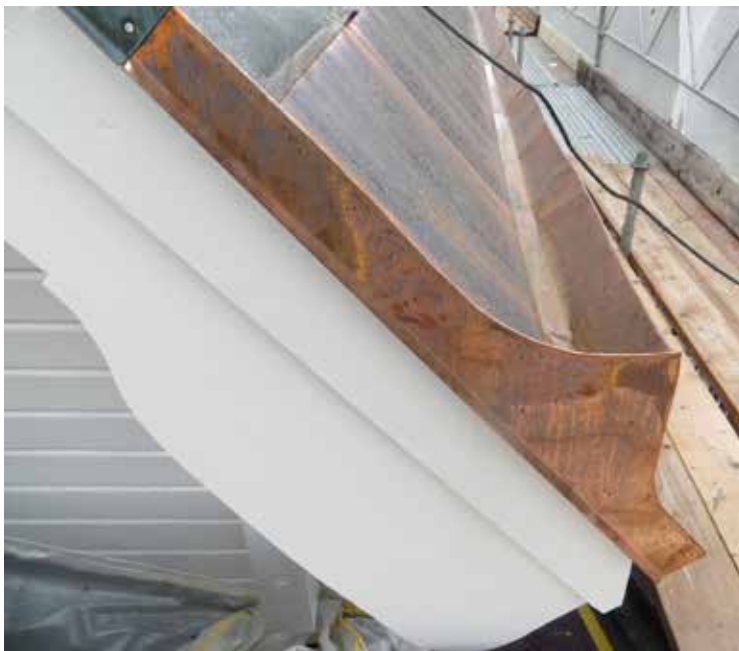
Ovan: Den nya fotrännans anslutning mot tornet. Till vänster: Den nya fotrännans avslutning mot vindskivan.
