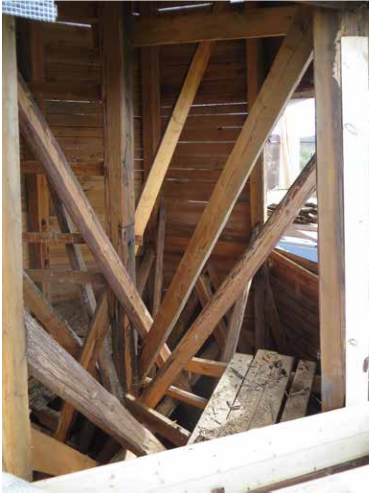
Ovan: Nylagd plåt på spirans nedre del. Till vänster: Innan den nedre delen kunde kläs med plåt fick omfattande rötslador lagas i.
