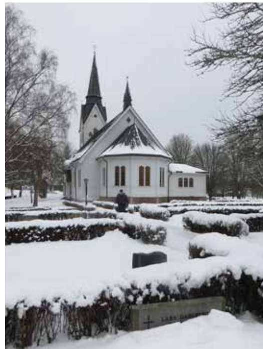
Stockaryds kyrka inför restaureringen.
