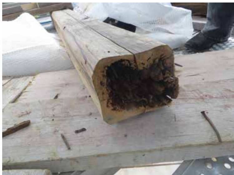
Ovan: Gavelmotiven längst ner på spiran kröntes av smidda dekorationer som var monterade genom plåten varvid vatten hade trängt in. Till höger: Vissa delar av spirans stomme hade omfattande rötskador och var i princip ihålig.
