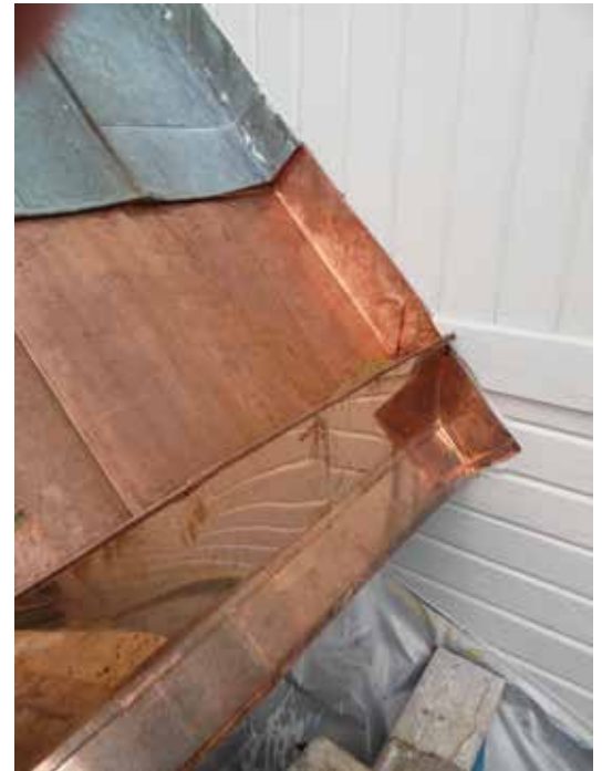
Ovan: Den nya fotrännans anslutning mot tornet. Till vänster: Den nya fotrännans avslutning mot vindskivan.
