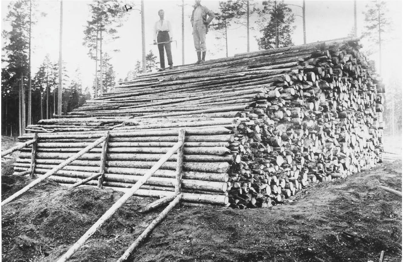
Figur 4. Liggmila under konstruktion. Från SLU, skogsbibliotekets bildarkiv, filnamn 13658.
