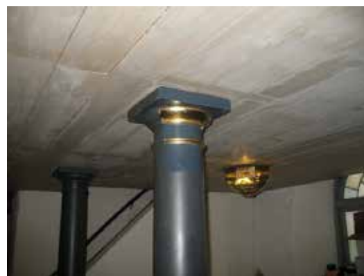
Pågående målning och omförgyllning av en kolonnerna under läktaren.
