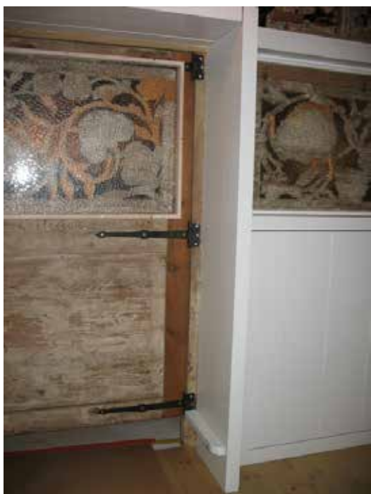
Det återmonterade skranket från "baksidan".
