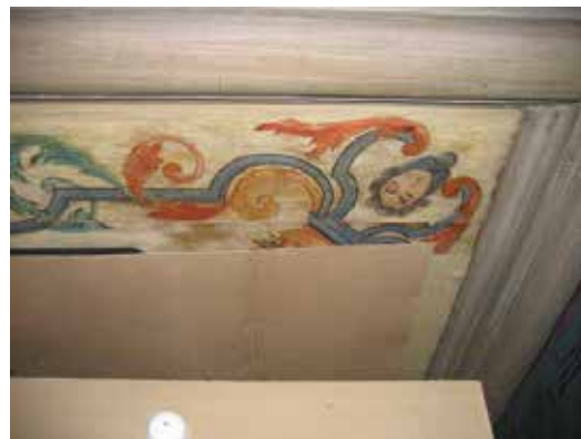
Masoniteskivan i taket över orgeln.
