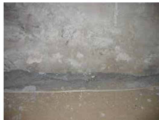
En fiberduk lades mellan betongplattan och muren.
