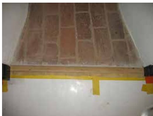
En tunn tröskellist lades för att dölja att kyrkorummets golv inte fullt ut ansluter mot sakristians tegelgolv.
