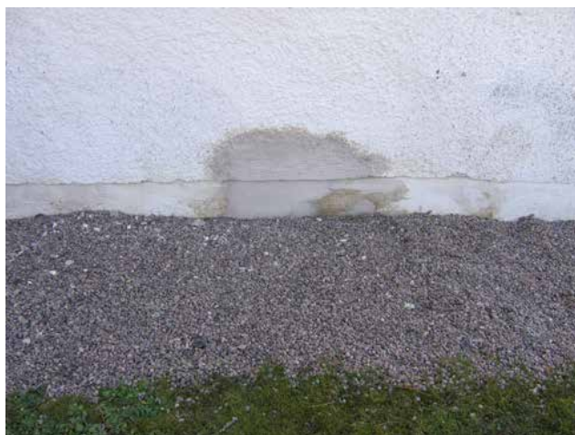
De tidigare ventilerna i sockeln sattes igen och putslagades.
