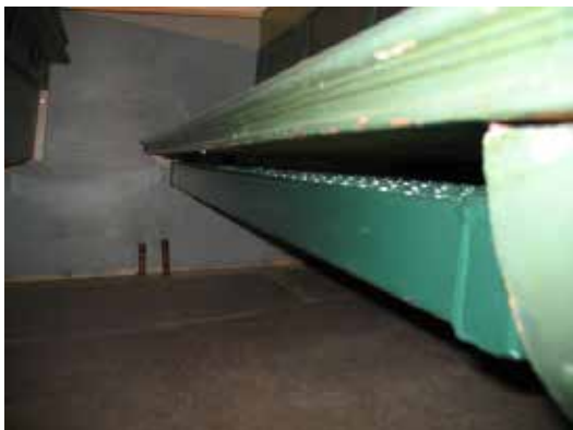
Radiatorerna levererades fabriksmålade i en grön kulör, för att passa mot den ursprungliga gröna bänkfärgen. Bild från pågående montering.
