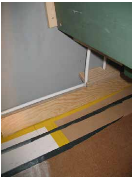
Rören byggdes in i uppbyggda sockellådor.
