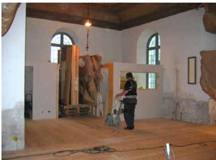
Det nya teknikrummet och toalettens plats i rummet framgår tydligt innan bänkinredningen är monterad. Golvet slipas.
