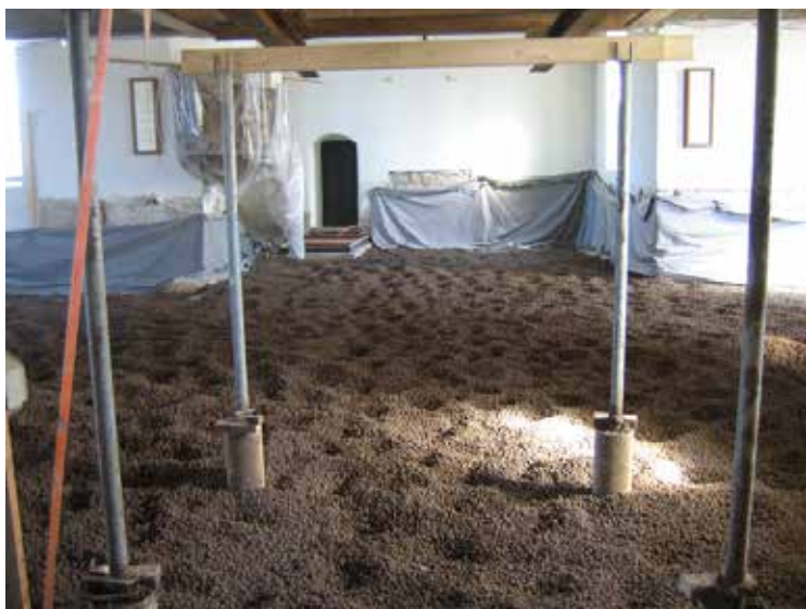
Golvet är uppfyllt med lecakulor inför kommande gjutning.
