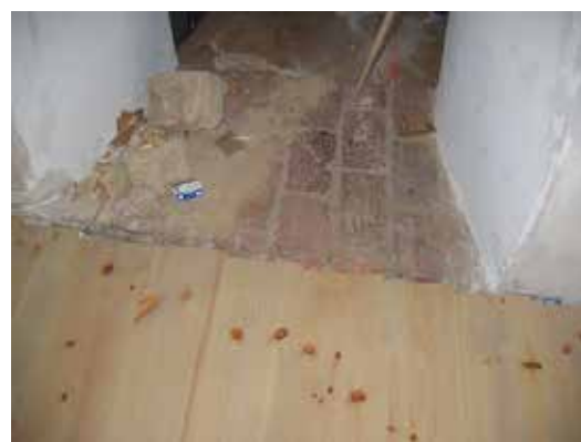
Delbesiktning av golvet, mötet mot sakristians tegelgolv. Passningen av respektive bräda var dålig, vilket gjorde att en list behövde sättas över skarven.
