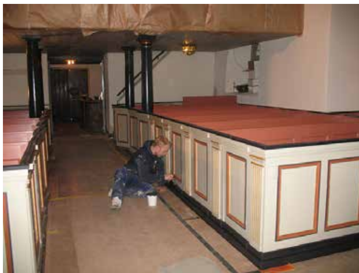
Pågående målningsarbeten av bänkdörrarna.
