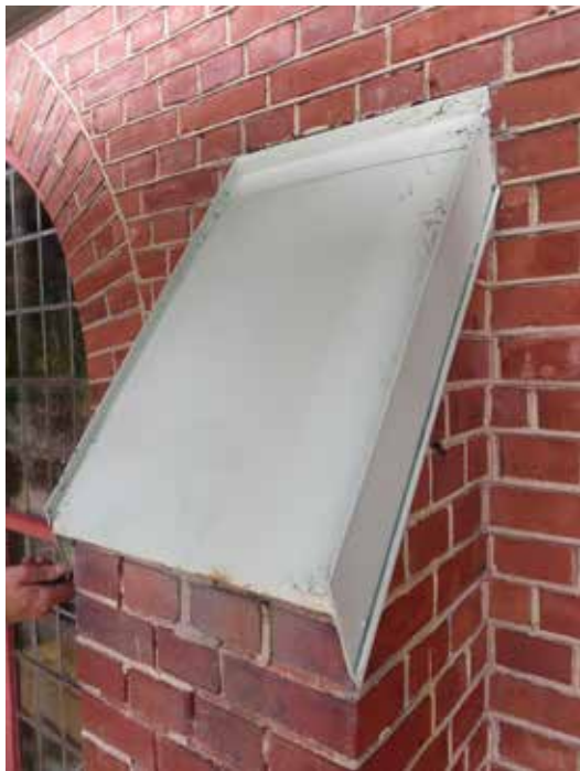
Ovan: Plåtavtäckning på strävpelare inför arbetena. Nedan: De nya plåtavtäckningarna gjordes snarlika, men med kompletterande plåt nedtill på undersidan för att förhindra vatteninträngning.
