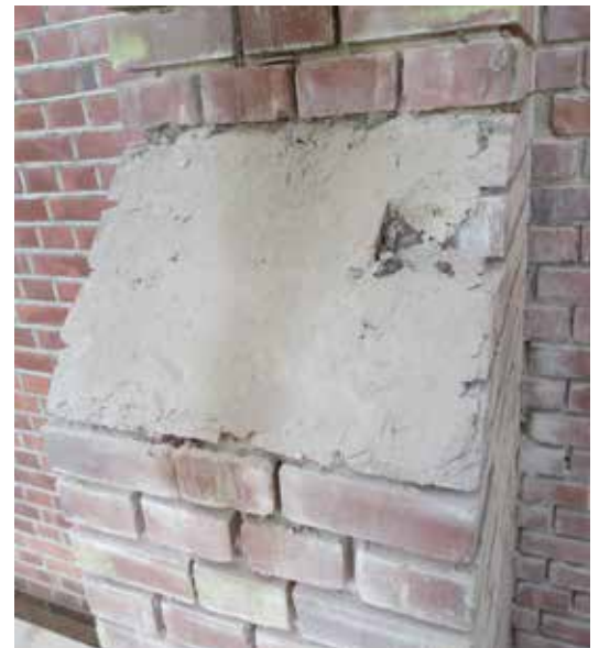
Ovan: Strävpelarnas plåttäckning togs bort och underlaget lagades upp med bruk och en plyfskiva innan den nya kopparplåten lades. Nedan: Detalj av ytterväggen där det upptäcktes spår efter vad som tycktes vara röd färg.
