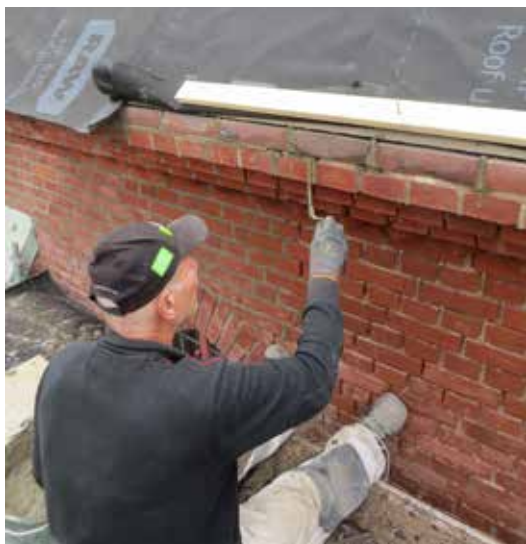
Ovan: Omfogning av fasaden. Till höger: Exempel på frostsprängning av fasaden, här på tornet.
