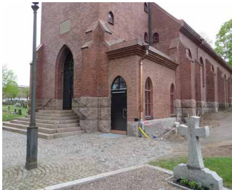
Ovan: Här uppförs stommen till tillbyggnaden. Denna kläddes sedan med rött tegel i förband. Till höger: Den nyuppförda tillbyggnaden. Nedan: De tidigare ytterväggarna av tegel som nu hamnade inne i tillbyggnaden bevarades.
