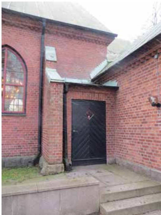
Ovan: Ingången till sakristian inför arbetena. Takavvattningen var inte tillfredsställande här. Ovan till höger: Sakristians ingång efter takomläggning och med nya stuprör.
