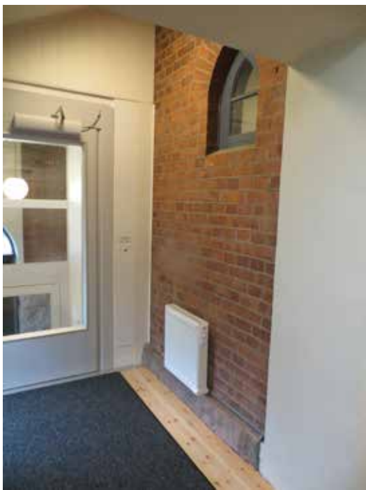
Ovan: Här uppförs stommen till tillbyggnaden. Denna kläddes sedan med rött tegel i förband. Till höger: Den nyuppförda tillbyggnaden. Nedan: De tidigare ytterväggarna av tegel som nu hamnade inne i tillbyggnaden bevarades.
