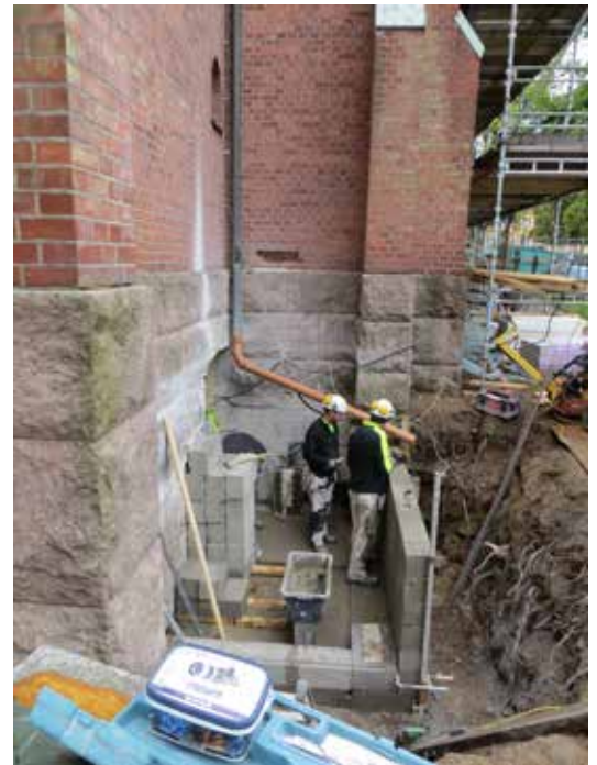
Ovan: Marken invid tornet har grävts ut och grundläggningen för tillbyggnaden har påbörjats. Till vänster: Tornets sidofasad innan tillbyggnaden påbörjades.
