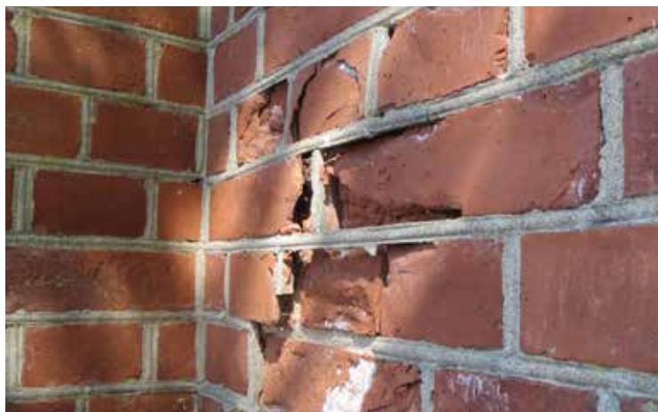
Ovan: Omfogning av fasaden. Till höger: Exempel på frostsprängning av fasaden, här på tornet.
