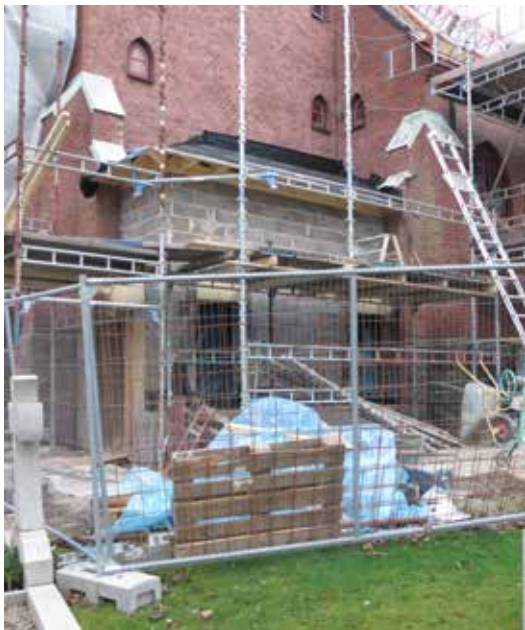
Ovan: Här uppförs stommen till tillbyggnaden. Denna kläddes sedan med rött tegel i förband. Till höger: Den nyuppförda tillbyggnaden. Nedan: De tidigare ytterväggarna av tegel som nu hamnade inne i tillbyggnaden bevarades.
