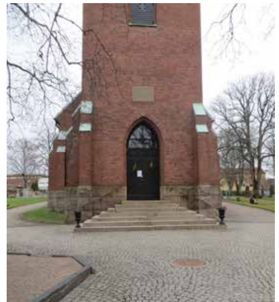
Kyrkans huvudingång med trappan som inte uppfyllde önskemålen om tillgänglighet.
