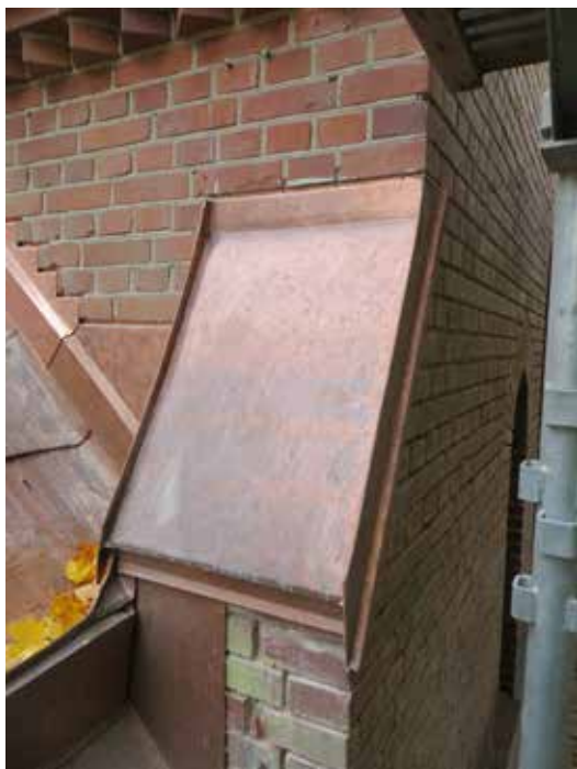
Ovan: Plåtavtäckning på strävpelare inför arbetena. Nedan: De nya plåtavtäckningarna gjordes snarlika, men med kompletterande plåt nedtill på undersidan för att förhindra vatteninträngning.
