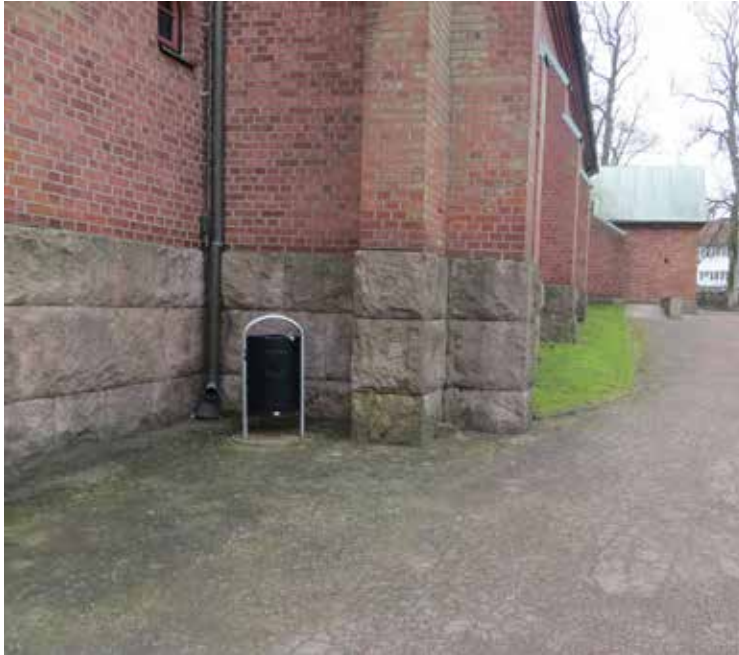
Parti av fasaden där tillbyggnaden skulle uppföras.
