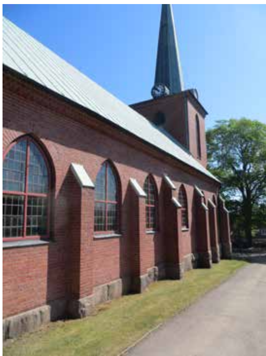
Långsidesfasaden inför omfogningen.
