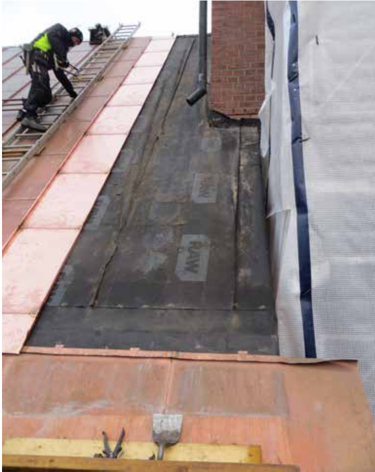
Ovan: Långhustakets fotränna med värmekabel samt anslutningen mot tornfasaden med trappstegsformade anslutningar. Till vänster: Läggning av långhustakets kopparplåt pågår.
