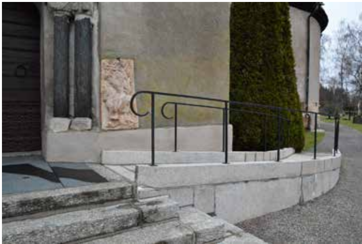
Rampen efter omfogning, foto från december 2019.
