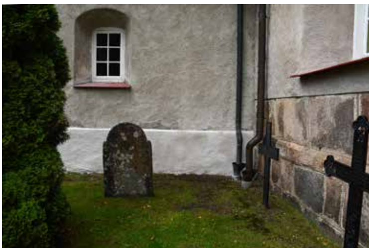
Sockeln efter avfärgning, från slutbesiktning i oktober 2017.
