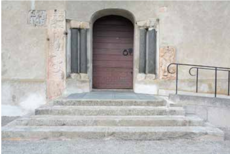
Den omlagda trappan vid södra entrén, foto från byggmöte den 7 september 2017.
