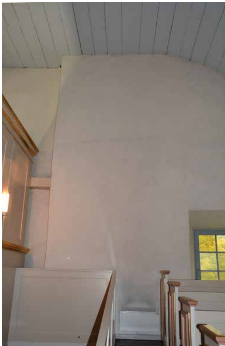
Norra delen av väggen efter åtgärd, foto från slutbesiktningen den 4 oktober 2017.
