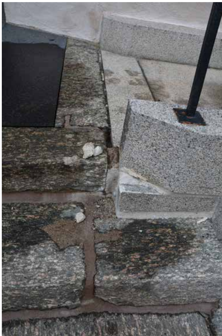
Detalj av rampen vid efterbesiktningen i september 2018.
