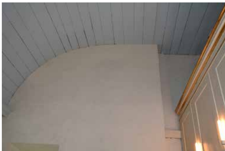
Södra delen av västväggen efter åtgärd, foto från slutbesiktningen i oktober 2017.
