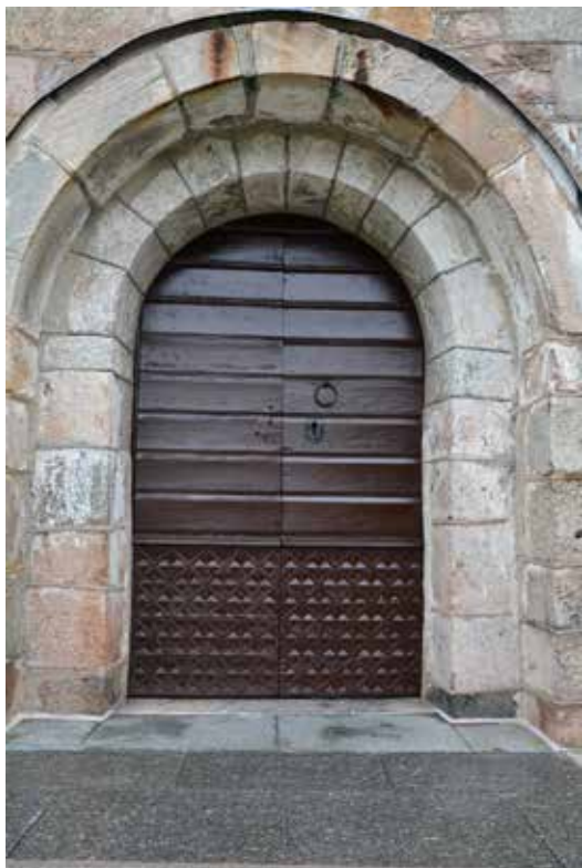
Den färdigmålade porten, vid efterbesiktningen i september 2018.
