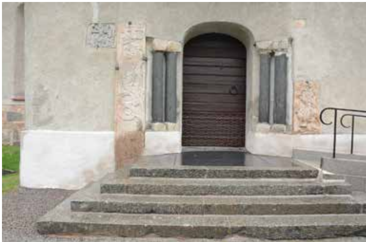
Sydportalen med den omlagda trappan, rampen och den målade entrédörren foto från slutbesiktningen den 4 oktober 2017.
