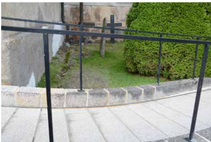
Den omlagda rampen, i bakgrunden syns två omputsade partier av sockeln, foto från byggmöte den 7 september 2017.
