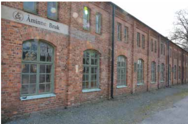
Den västra fasaden före åtgärd.
