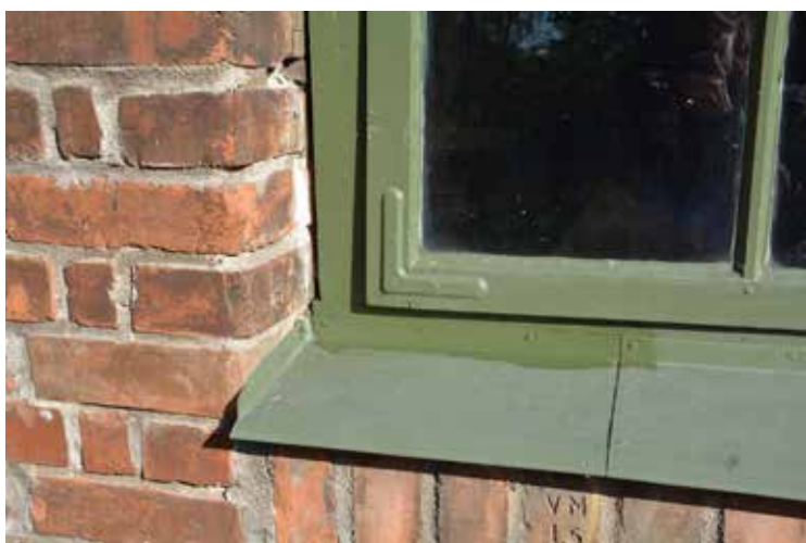
Detalj av ett av fönstren på den västra gaveln.
