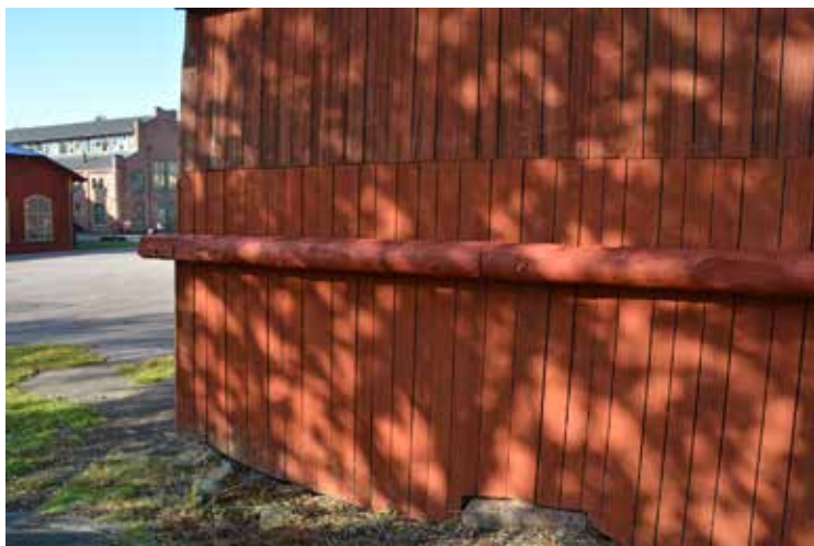
Den nya balken på kolladans östra gavel.
