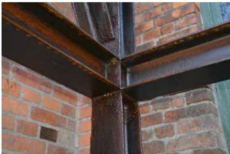
Detalj av de bytta balkarna.
