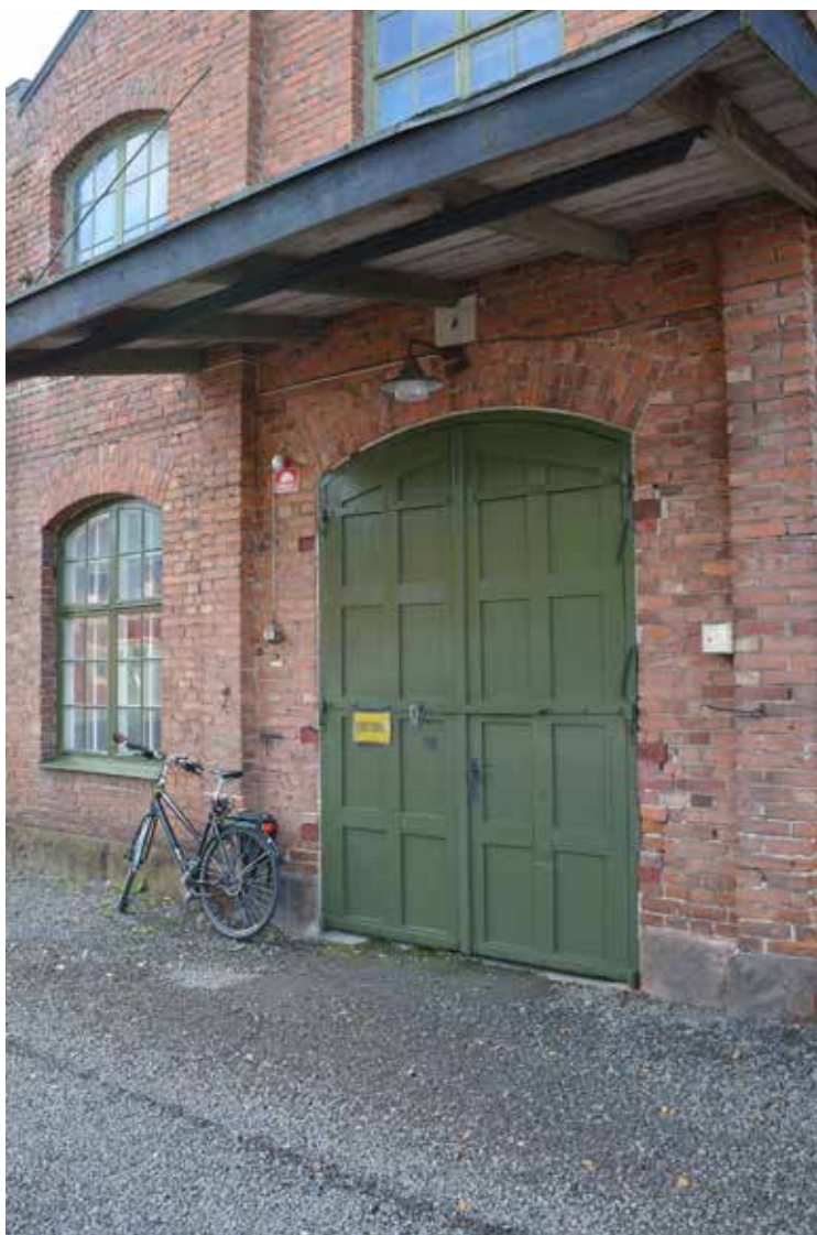
Detalj på en av de målade portarna, norra fasaden.
