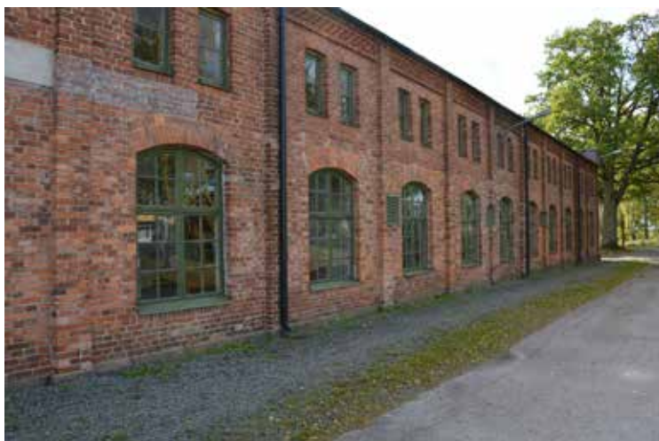
Den västra gaveln, från norr mot söder.
