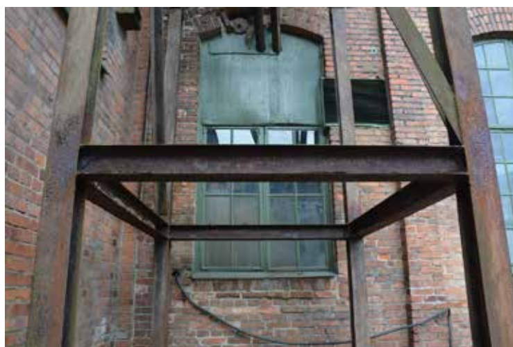
Ställningen till sandbehållaren var kraftigt rostangripen i de horisontella balkarna.
