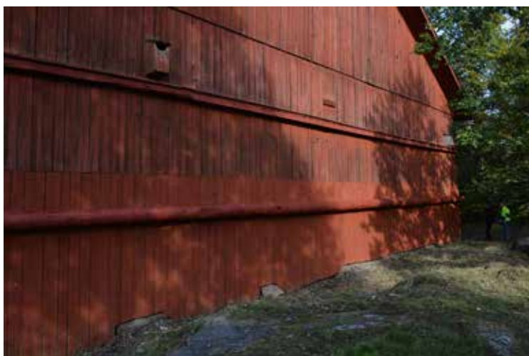
Den nya gördelbalken på kolladans östra gavel.
