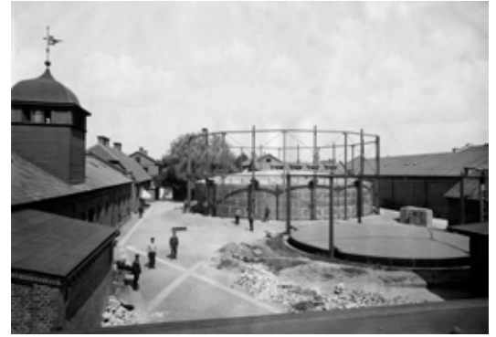
Gasverksanläggningen utökades i omgångar. Här ses en bild från 1903 med två av gasklockorna.
