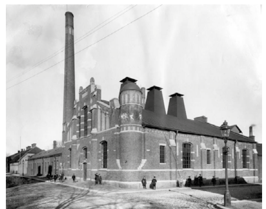
Gasverkets nya retorthus i korsningen Kyrkogatan – Gjuterigatan som stod klart att tas i bruk 1906. Ugnarna eldades med kol, vilket innebar att gasverket förutom gas, även kunde producera biprodukter i form av koks och tjära.
