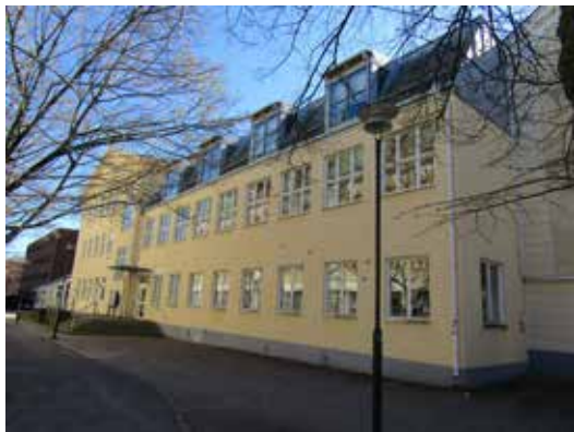
Ovan: Fasad mot norr.
