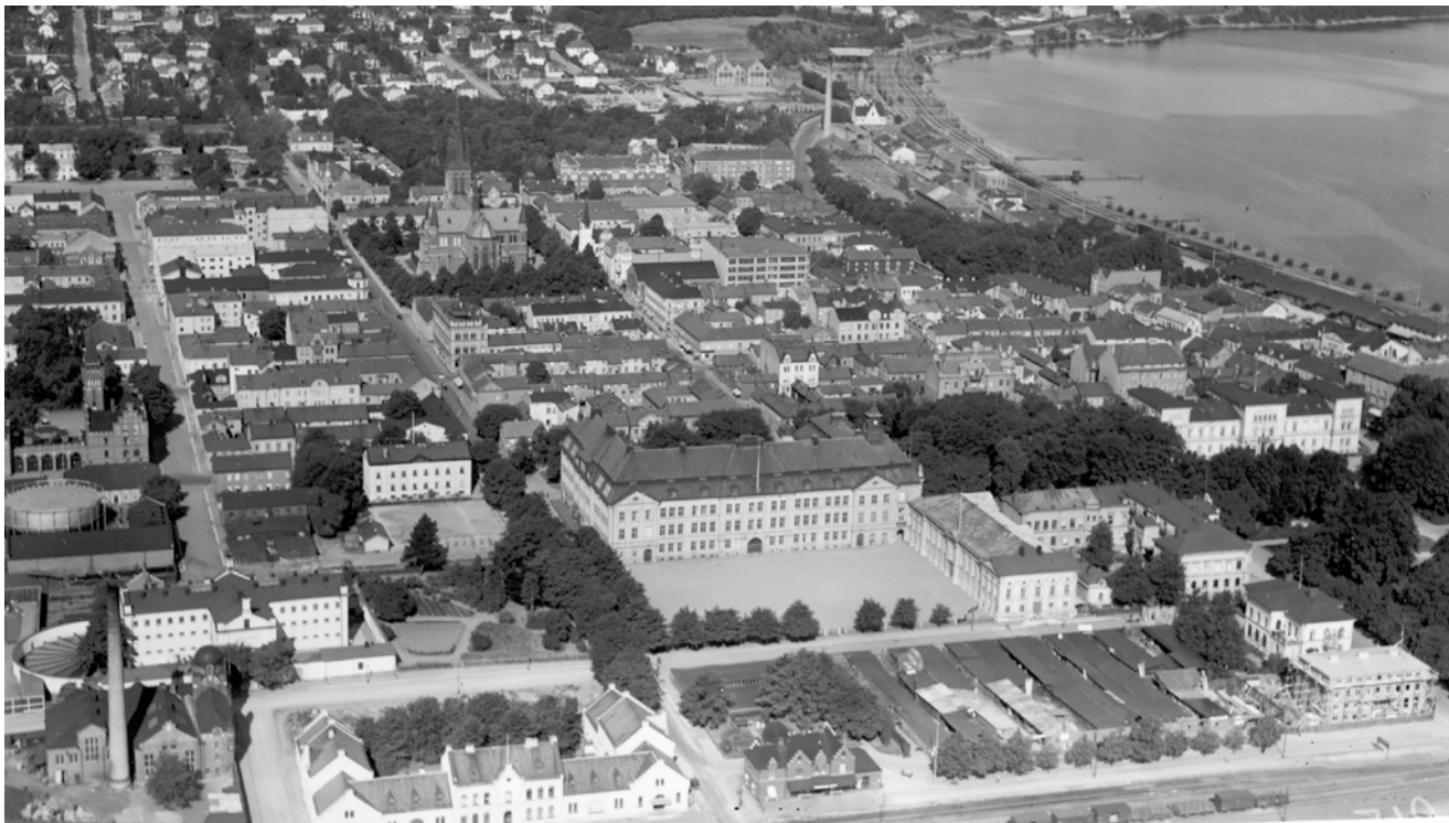
Flygfoto över Väster från 1942 där de aktuella kvarteren ses i nedre vänstra hörnet. På fotot ses fler mindre träbyggnader i kvarteret Globens södra del, vilka senare kom att rivas då skolan utvidgade sin verksamhet.
