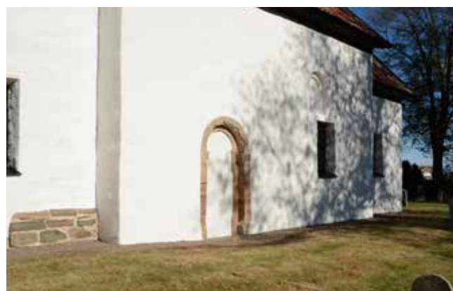
Långhusets södra fasad med den frilagda trappstenen framför portalen.
