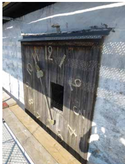
Urtavlorna i tornet bedöms vara sekundärt omgjorda. Dessa består av spåntad träpanel och är behandlade med trätjära. Siffrorna i förzinkad plåt är förgyllda.
