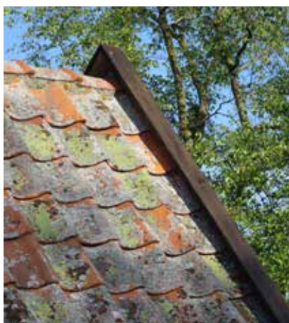
Vindskivorna kom att skjuta upp övernocken.
