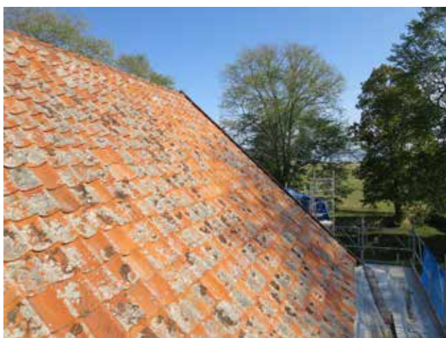
Långhustaket efter tvättning.
