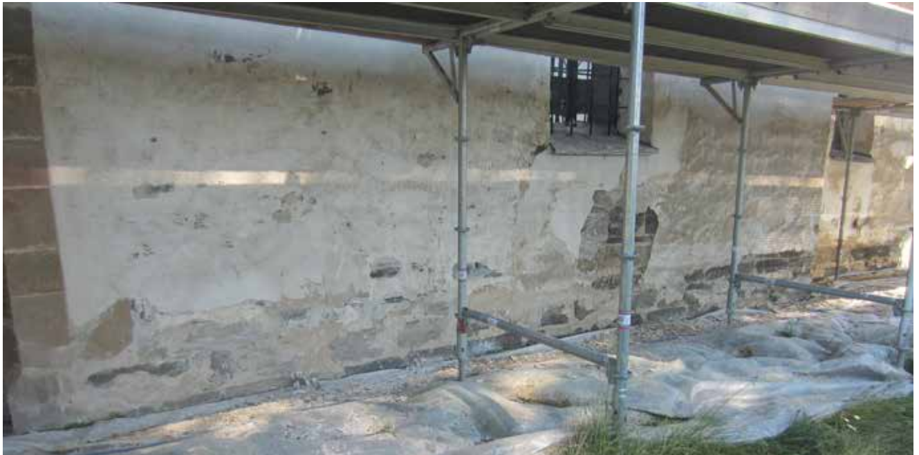
Frilagda delar av murverket i långhusets södra fasad, öster om sydportalen.
