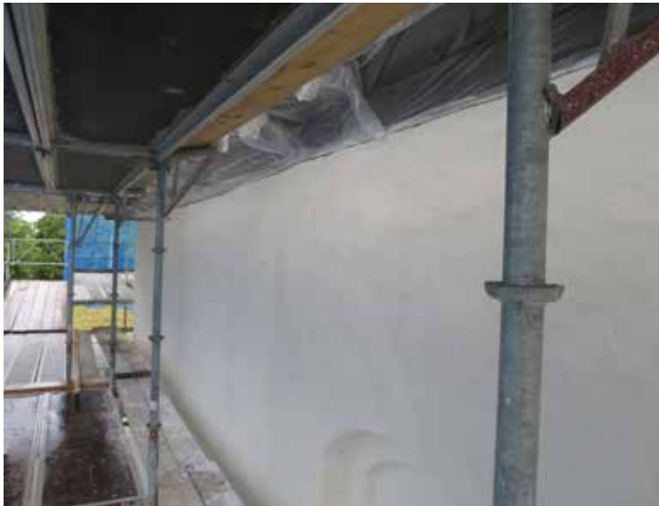
Kyrkans hammarband skyddstäcktes under avfärgningen.
