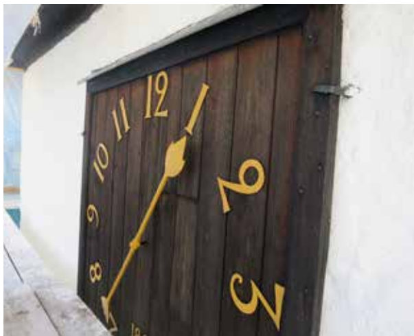
Tornets urtavlor behandlades med s k fintjära av hög kvalitet. Siffror och visare målades med ockragul linoljefärg i syfte att återfå en 1600-talskaraktär.
