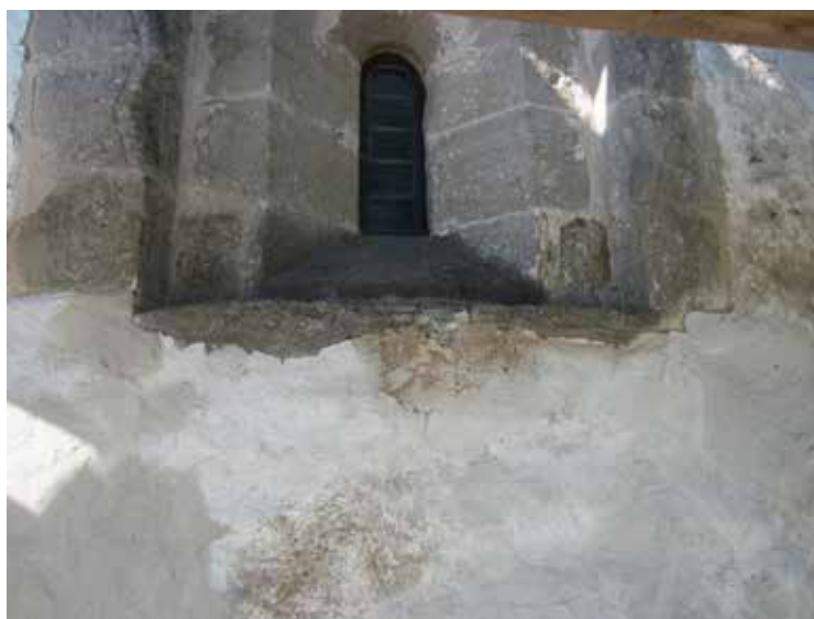
Putslagningar i anslutning till korets absidfönster. Tidigare puts avslutning följdes.
