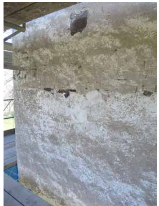
Ett parti av tornets fasad efter rengöring med högtryckstvätt. För att bli av med så mycket som möjligt av lavarna, fick mycket av den befintliga kalkfärgen avlägsnas. Pustsen lossnade även bitvis där underliggande stenar i murverket buktade ut.
