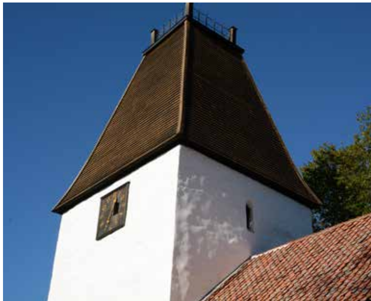
Tornets övre del efter lagning och avfärgning av puts samt tornurtavlornas tjärning och målning.
