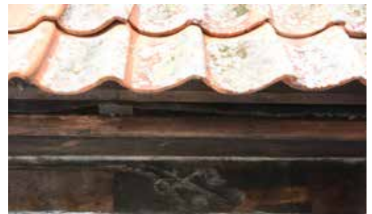
Samtliga hammarband, vindskivor och stormlister ströks med trätjära.
