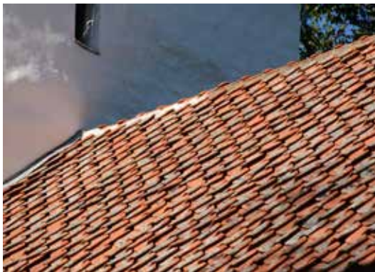
Södra takfallet efter tvättning. Nockteglet var lagts i bruk. Detta kompletterades med hydrauliskt kalkbruk.
