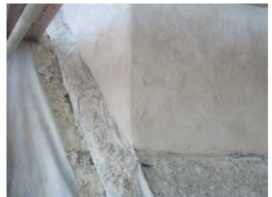
För att garantera en tät anslutningsplåt på tornet, kompletterades putsen här så att den kom att råda över plåtkanten.
