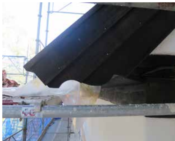
Nya vindskivor och vattbrädor spikades med smidd spik. Vindskivorna från 1987 var satta med syrafast spik vilka lysta blankt.
