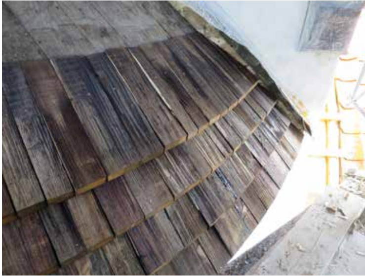
Spåntäckningen på korabsidens tak under omläggning.
