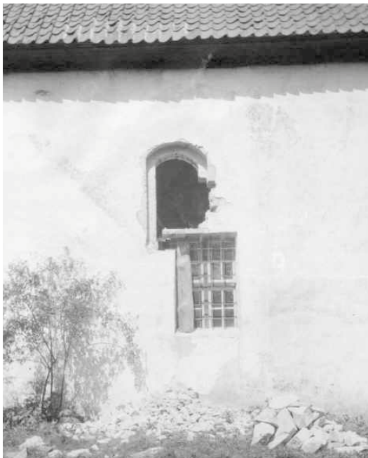
Friläggningen av det romanska fönstret i långhusets södra vägg år 1910. JLM.
