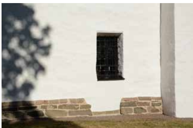
Tornportalen putsades åter över, dock utan ristning som markerar öppningen i putsen.
