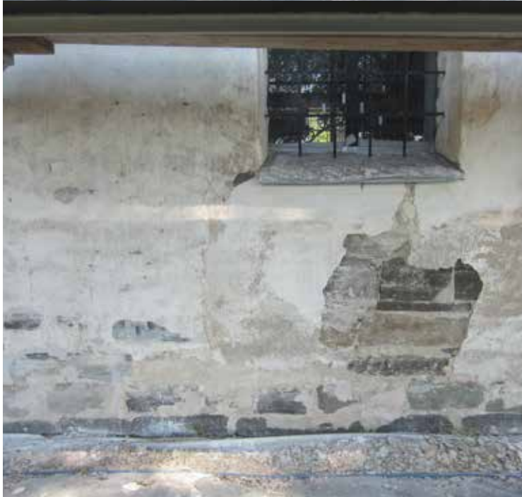
Frilagda delar av murverket i långhusets södra fasad, öster om sydportalen.
