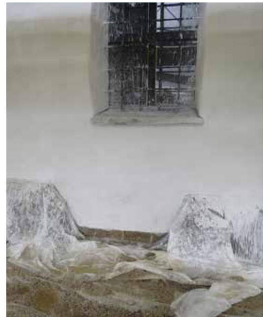
Tornportalen putsades åter över. Till skillnad mot tidigare gjordes ingen ristning efter nischen.
