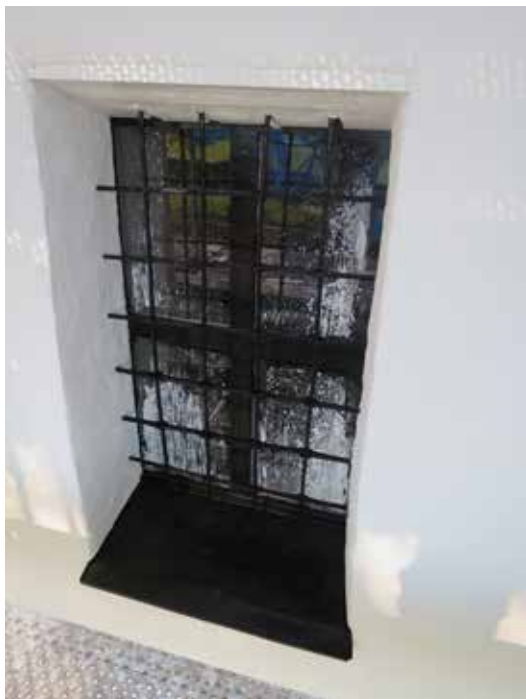
Ett av kyrkans fönster efter utvändig målning av snickerier, smidesgaller och fönsterbleck.
