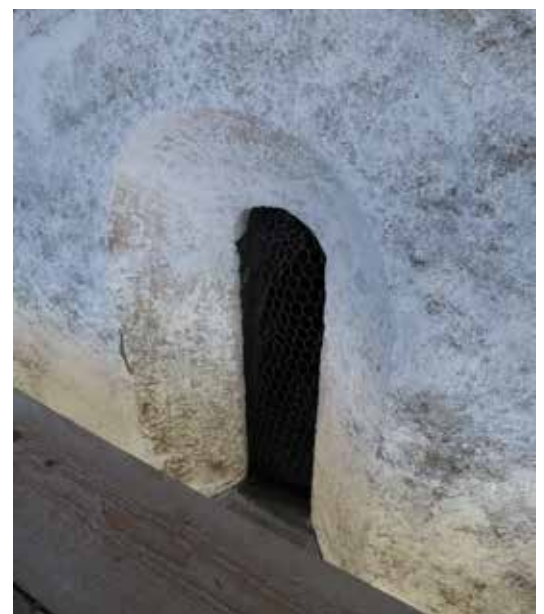
Tornets medeltida ljusglugg åt väster hade en sandstensomfattning som är överkalkad.
