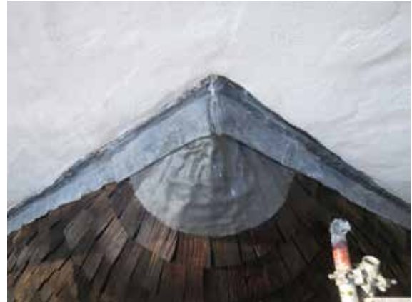
Anslutningplåtar och kröntäckning av blyplåt.
