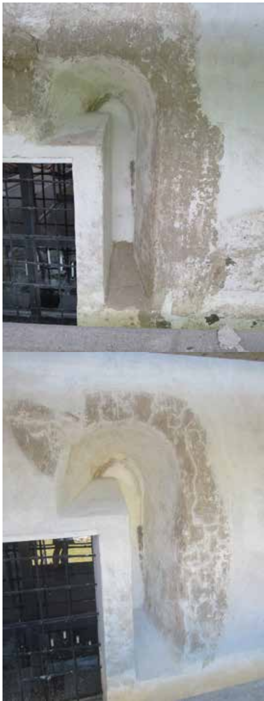
Det norra fönstrets nisch med bevarad, sannolikt senmedeltida puts, före och efter konservering.
