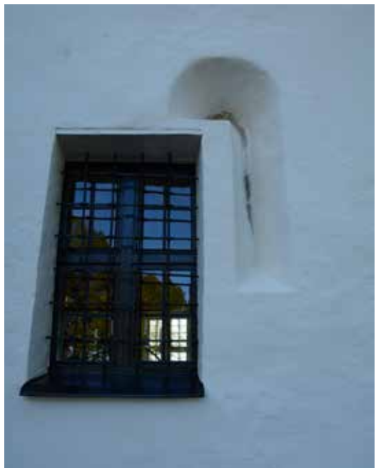
Sandstensomfattningen till det gotiska fönstret i nordfasaden frilades.
