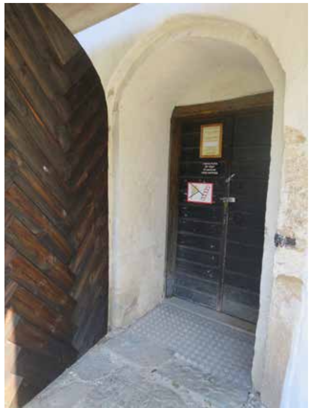
Den yttre tornporten från 1946 vars invändiga panel lagats varefter hela porten strukits med tjära.
