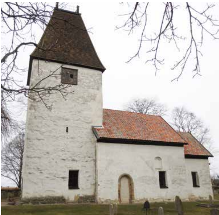
Tornets medeltida ljusglugg åt väster hade en sandstensomfattning som är överkalkad.
