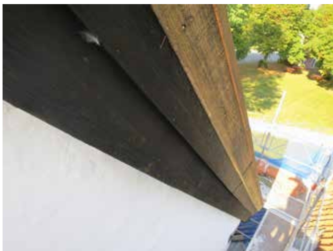
Efter tjärstrykning uppstog en differens i nyansen mellan nytt utbytt virke och befintligt.
