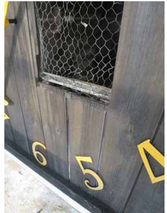
Nya fjädrar fälldes in vid spånten till tornets södra urtavla.
