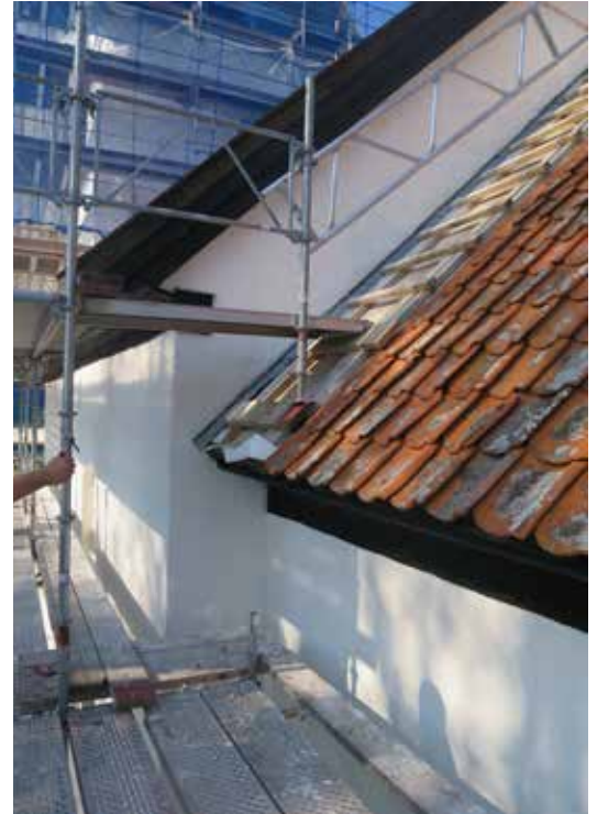
Samtliga hammarband, vindskivor och stormlister ströks med trätjära.
