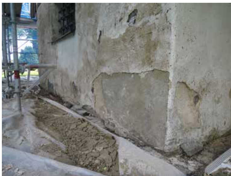
Sakristians murverk består av större och oregelbundna stenblock i grå och svart lerskiffer. Blocken har en slät yta vänd utåt.
