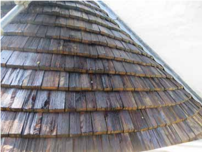
Korabsidens spåntak efter omläggning och tjärning.
