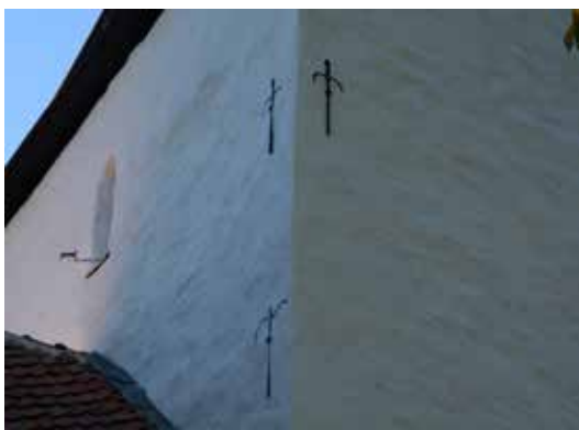
Tornets ankarjärn målades med järnmönja och svart linoljefärg.
