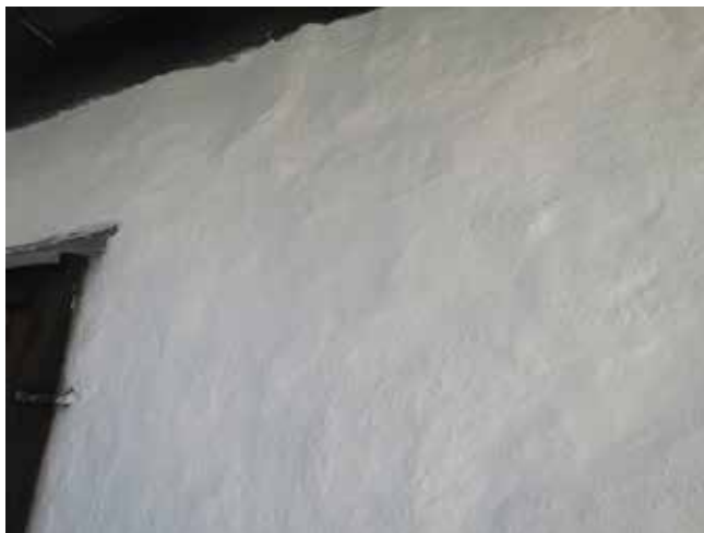
Tornets fasad med putsens följsamhet till murverket och grova kvastade ytstruktur.
