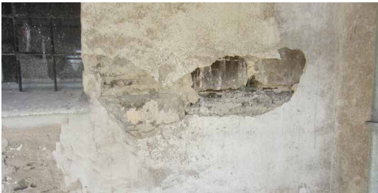
Frilagt parti av tornets murverk längst ned åt söder.
