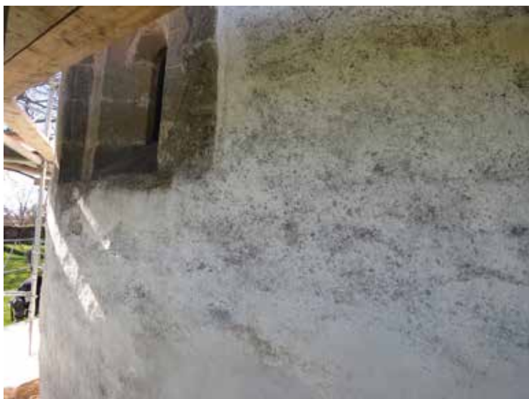
Den äldre putsen på kyrkan har ett likartat utseende, en tunnputs med grov ytstruktur. Notera att lagningarna längst ned på korabsiden är slätare.
