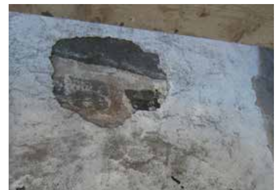
I korabsidens murverk förekommer bitvis mindre stenar och där fogen fyllts ut i större utsträckning för att bilda en slät yta hos murverket. För att skapa absidväggens rundade form har sannolikt ett mindre stenformat krävts.
