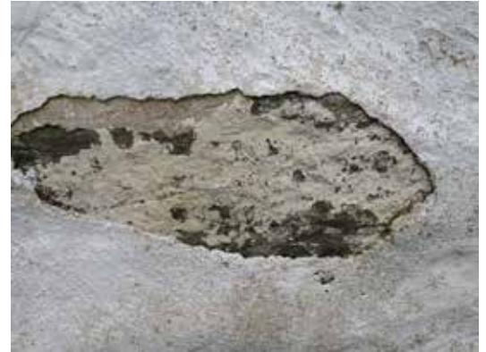
Ett litet parti på korabsiden där den tunna enskiktspust lossnat och den medeltida slamningen framträdde.
