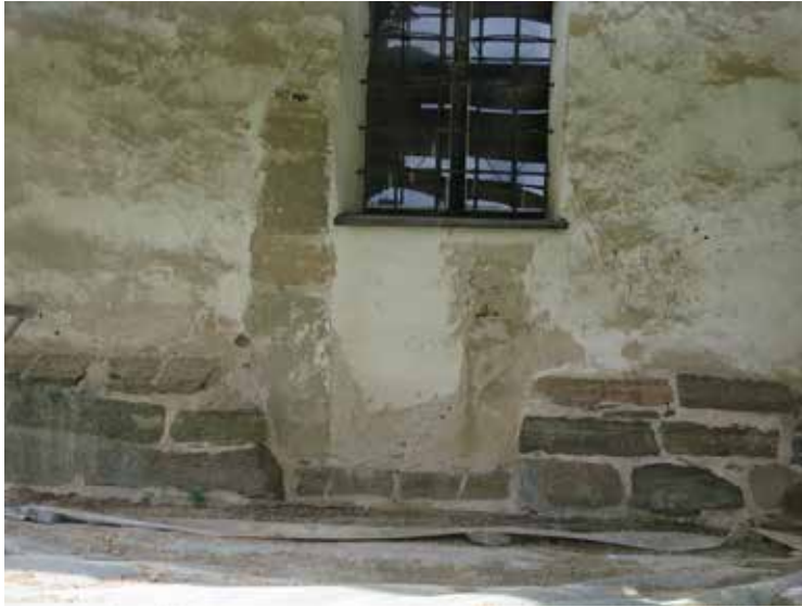
Den medeltida tornportalen frilades på försök med hjälp av högtryckstvätt. Stenen i det östra sidostycket var alltför fragmenterisk för att ge ett helhetsintryck.
