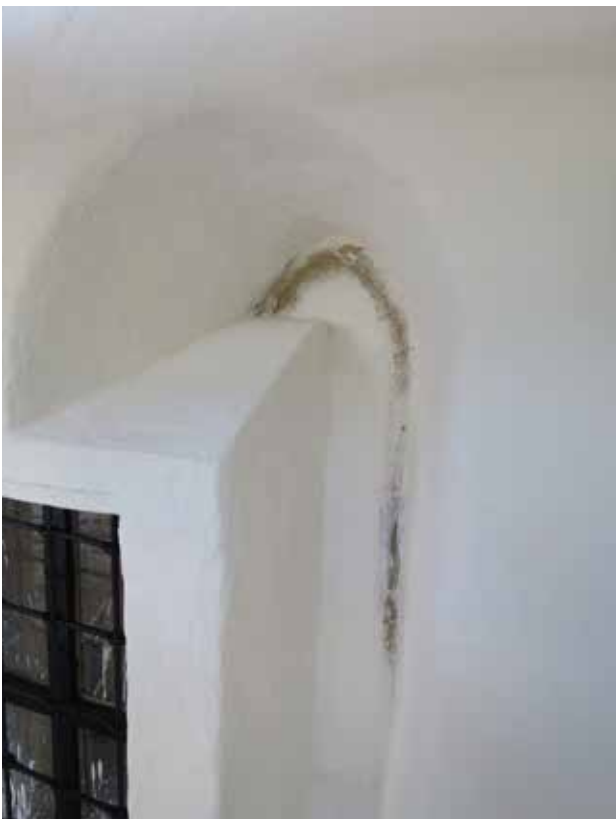
Stenomfattningen kring det gotiska fönstret åt norr frilades och behölls omålat.
