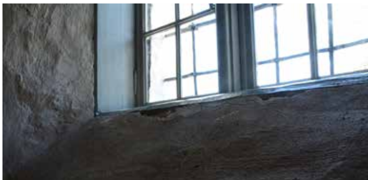
Fönstrens insida efter om- och bättringsmålning
