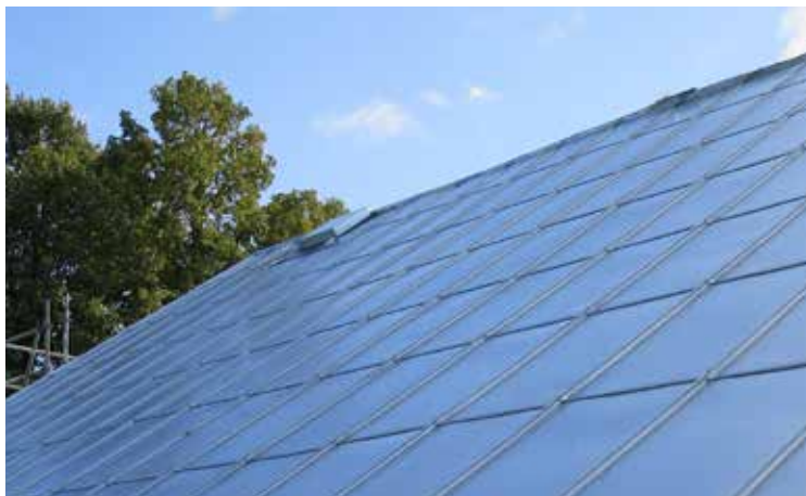
Ett av de sex nya luftdon som tillkom på långskeppets tak.
