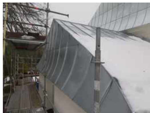
Sakristans svängda valmade takfall lämnades i likhet med övriga dito utan ståldränna.
