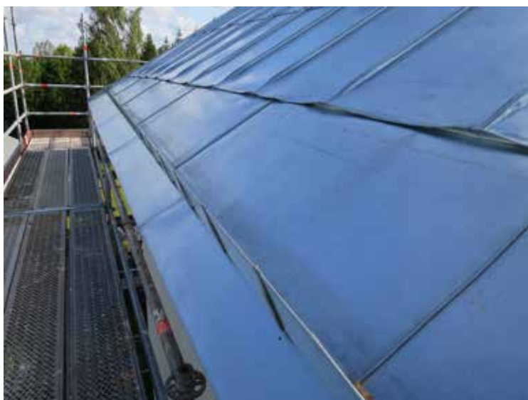
Ståldrännan gavs ett typiskt tidigt 1900-talsutseende. Rännan förstärktes med rännkrokarna i specialstål vilka sattes något tätare än vad som är brukligt. Dessutom monterades en invändig plåt i rännan.
