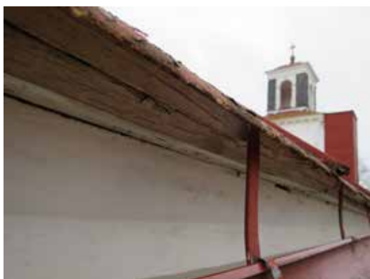
Råsponten på södra takfallet under läggning.
