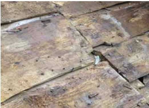
Återanvända brädor i taksvallen åt norr.
