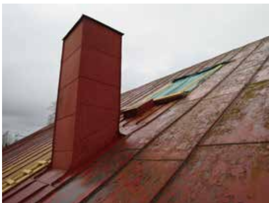
En större öppning fick tillfällig tas upp i långskeppets norra takfall för att möjliggöra in- och utförsel av material i samband med isoleringsarbetena. Öppningen förlades strax ovanför skorstenen.
