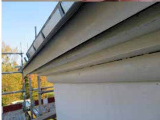
Takfotens utseende före och efter luftningsspaltens tillkomst. Hängrännorna ersattes även med ståndrännor i plåttäckningen, varpå taklisten åter blev helt synlig.
