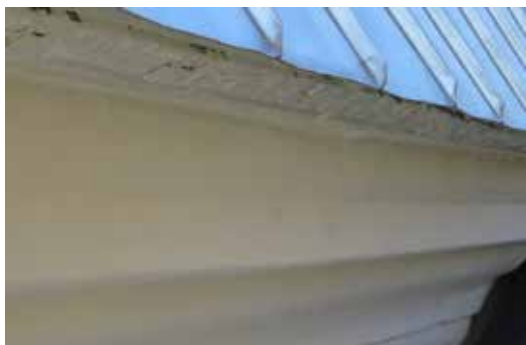
Synliga spån från kyrkans äldre spåntak på östra sidan. Dessa målades i likhet med tidigare i fasadens brutet vita kulör.
