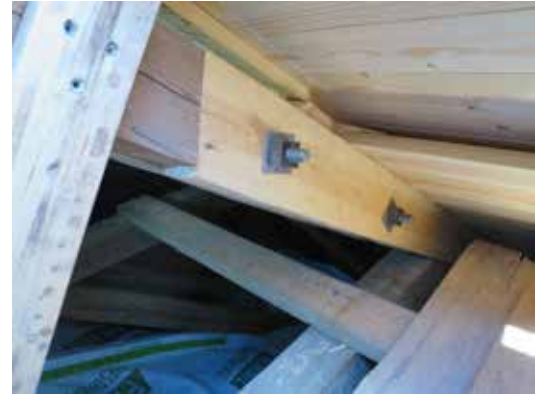
Samtliga skarvar utfördes med raka bladskarvar som bultades med gängbult och fyrkantsmutter.
