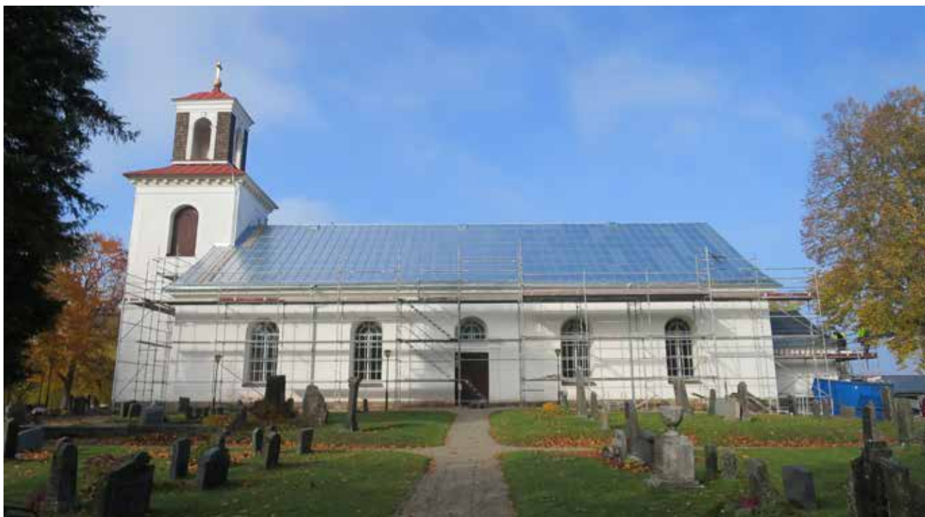
Kyrkan från söder efter att långskeppets tak färdigställts. Det nya plåttaket lades med ett mindre plåtformat än tidigare. Notera de tre luftdonen i anslutning till taknocken.
