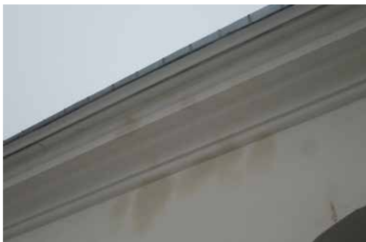
Den nya takfotslisten till luftningen av underlagstaket blev förhållandevis diskret. Fläckarna på gesimsen är efter bättringsmålningen av putslagningarna.
