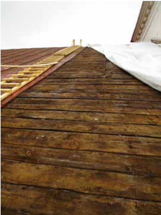
I anslutning till tornet fanns en generalskarv i takfallet riktning. Möjligen kan läggningen av detta större parti av taksvallen initialt hindrats av en byggställning till tornet.
