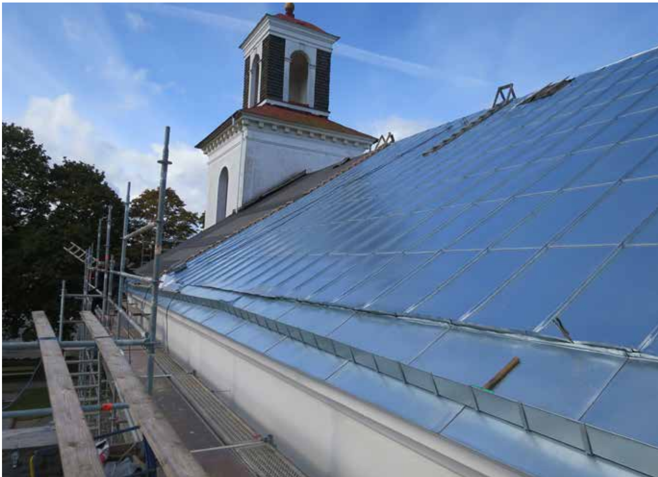
Södra takfallet underläggning.
