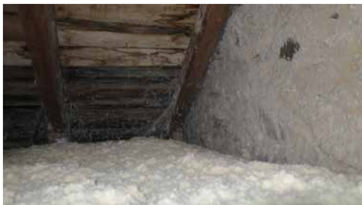
Sakristians vind efter färdigställd isolering.
