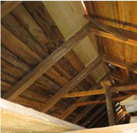
En spalt skapades genom att brädor togs bort strax under taknocken. Här har detta ännu enbart utförts i ena takfallet.
