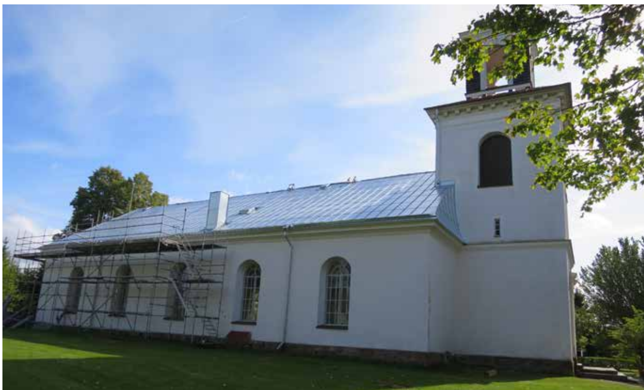
Kyrkan från norr. Vid omtäckningen lades stor vikt vid att bibehålla takformen med utsvängda valmade gavlar. Takavvattningen gjordes nu om till ståndrännor istället för hängdrännor och med nya stuprör i en modell som var vanlig under tidigt 1900-tal.
