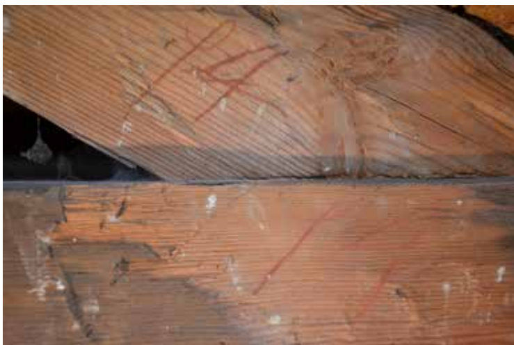
Uppmärkning av sakristians takstol, vilket antingen gjorts när de förtillverkades på marken eller om de återanvänts och flyttats från en äldre byggnad.
