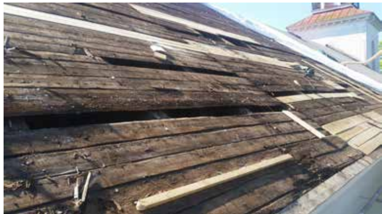
En spalt skapades genom att brädor togs bort strax under taknocken. Här har detta ännu enbart utförts i ena takfallet.
