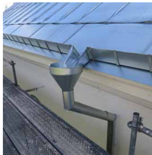
De nya stuprören med tidstypiska skarprörsvinklar och trattar, tillverkade på plåtslageri.
