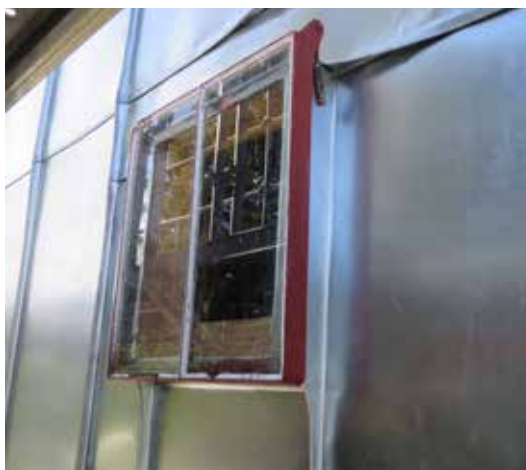
Takfönstret från 1950-talet i östra takfallet kittades. Målningen får avvaktas med tills taket som helhet ska målas.
