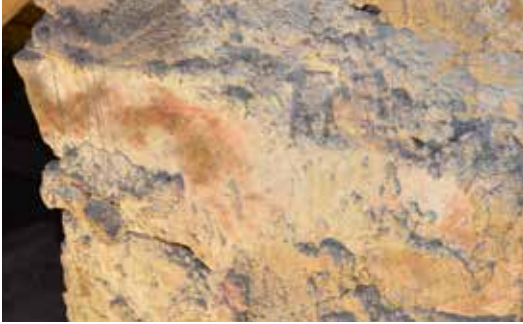
Sten i tornets murverk mot kyrkvinden, troligen återanvänd från Kråkshults gamla kyrka. På flera stenar förekom bevarade fragment av tunn kalkputs med rödrosa kalkfärg.
