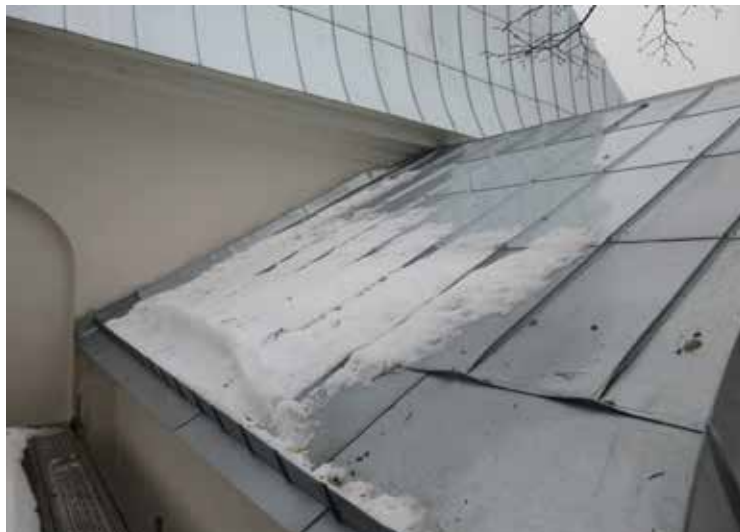
På sakristians södra takfall slopades den tidigare skorstenen, vilken tagits ur bruk. Anslutningplåten mot fasaden gjordes något lägre än tidigare. Avfärgningen av putslagningarna kunde här inte utföras på grund av den kalla väderleken. Denna fick anstå till den fasadrestaurering som planeras inom några år.
