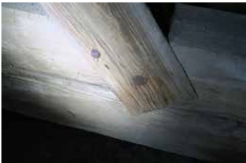
Husad knut mellan stödben och bindbjälke i långhus-takstol, fäst med spik och dymling. Foto: Robin Gullbrandsson.
