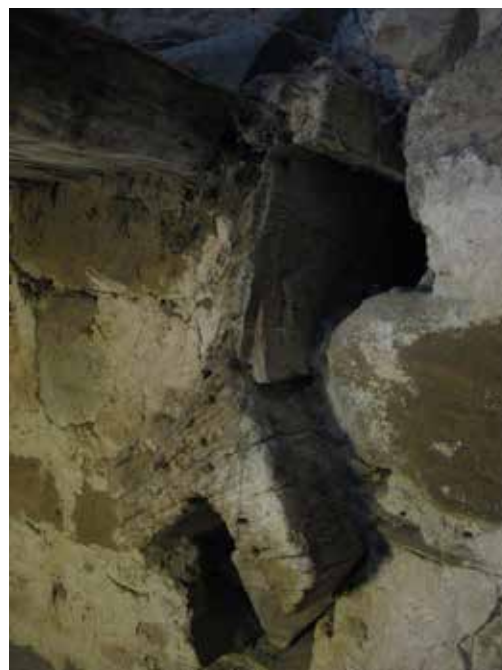
Änden på långhusets romanska noekkam i ek från 1100-talets mitt är bevarad, inmurad i tornets östmur när denna restes ovanpå långhusgaveln. Foto: Robin Gullbrandsson.
