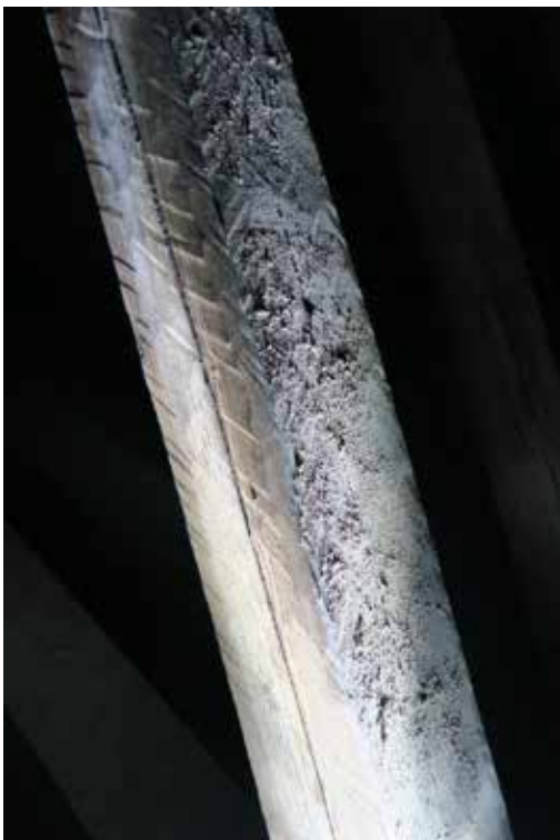
Sprätthuggning på stödben i långhusets taklag. Foto: Robin Gullbrandsson.
