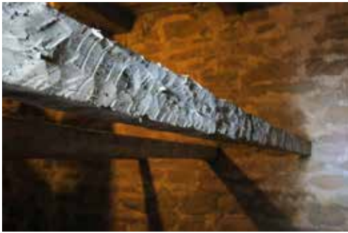
Golvbjälke i tornet, prov nr. 2. 1247-1277 (1260 +/-10). Foto: Robin Gullbrandsson.
