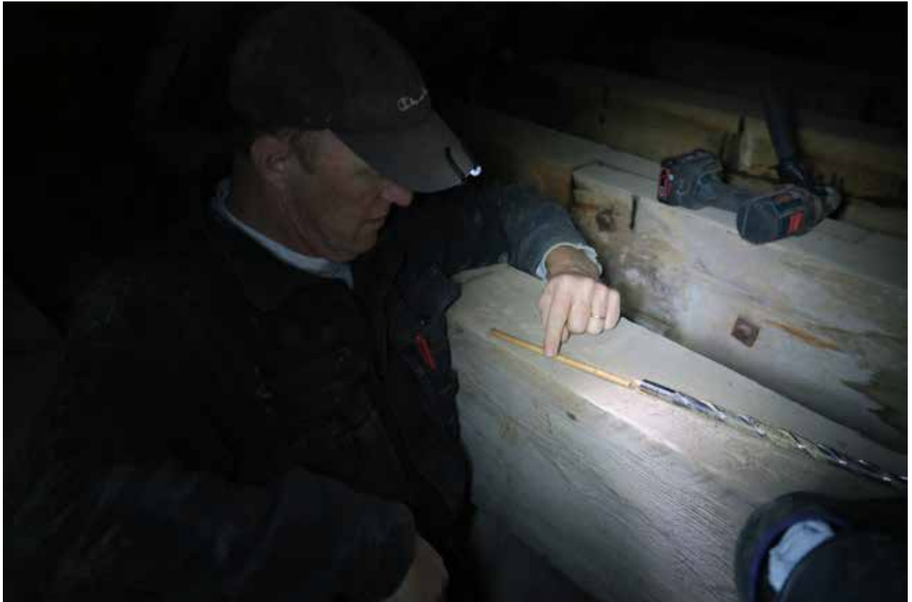
Prov nr. 6 från en av bindbjälkarna i långhuset. Proverna från bindbjälkarna i kor och långhuset visar på ett fällningsår mellan 1145 och 1172, sannolikt 1150 +/- 5 år. Foto: Robin Gullbrandsson.
