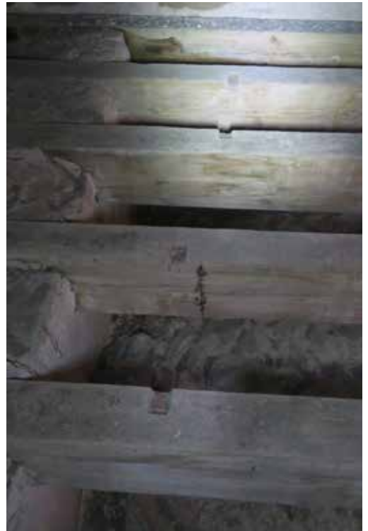
Bindbjälkar i koret med urtag för upphängning av två liturgiska klockor. Foto: Robin Gullbrandsson.
