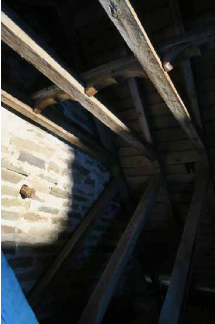
Korets taklag och östra korgaveln med rest av inmurat ställningsvirke. Notera den dekorativa styrplankan. Foto: Robin Gullbrandsson.
