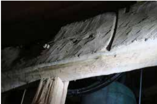
Klockbjälke med urtag för klockaxel och märken efter klocka. Prov nr. 3. Vinterhalvåret 1274/75. Foto: Robin Gullbrandsson.
