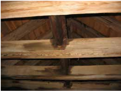
Styrplanka med kälad profil rider på hanbjälkarna i långhuset. Foto: Robin Gullbrandsson.
