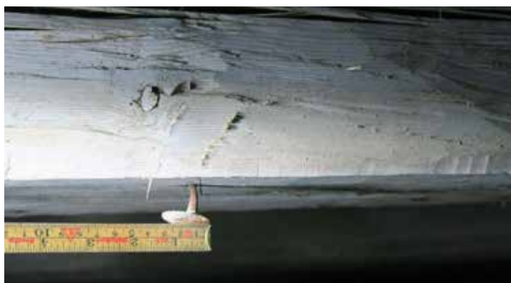
Kvarsittande medeltida spik på undersidan av en bindbjälke i långhuset minner om ett försvunnet innertak av brädor som föregick den senmedeltida valvslagningen, en vanlig utvecklingsgång i Götalands medeltidskyrkor. Foto: Robin Gullbrandsson.
