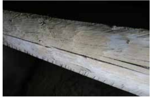
Bindbjälke med bortbilad sprätthuggning. Foto: Robin Gullbrandsson.
