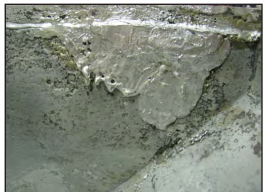
Invändig uppbyggnad av tunn men ej ännu genomkorraderad plåtyta. Foto: Cai Zetterström.
