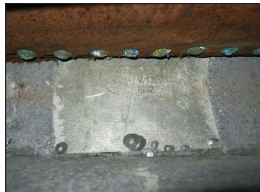
Utbytt tennplåt vid bottenstycket. Foto: Cai Zetterström.
