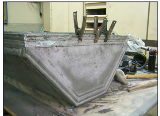
Den avbrutna listdelen rengjord och fixerad inför lödning. Foto: Cai Zetterström.
