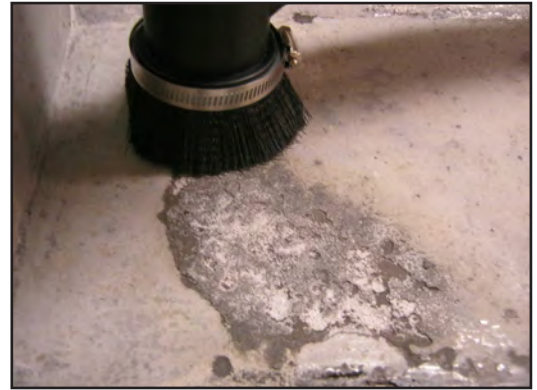
Punktblästring med olevinsand. Foto: Cai Zetterström.
