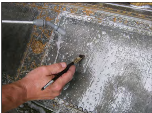
Rengöring med quillayabark och avjoniserat vatten. Foto: Leif Larsson.
