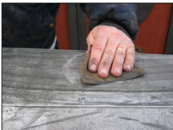
Borttagning av täckande oxidskikt, steg 1. Foto: Ann-Sofie Zetterström.
