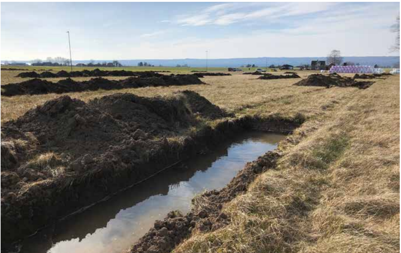
Figur 6-7. Övre bilden visar kokgropen A2 i profil. Foto från öster. Den nedre bilden visar hur vissa av schakten vattenfylldes efter några timmar.
