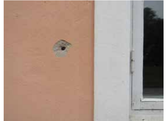
Fasaden är putsad och mot timret finns så kallat spikteglet. På enstaka ställen har spikteglet spikar rostat och sprängs loss bitar av av putsen.
