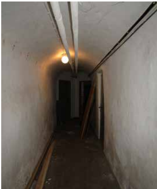
Ovan: Mittkorridoren i källaren.
