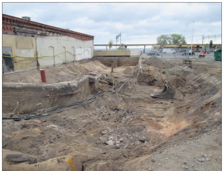
Figur 6. Norra delen av förundersökningsområdet. I förgrunden skymtar en nedgrävd tank och störningar runt denna. Tanken låg söder om det nu rivna garaget vilket låg intill kvarvarande industribyggnad, det så kallade G-huset.
