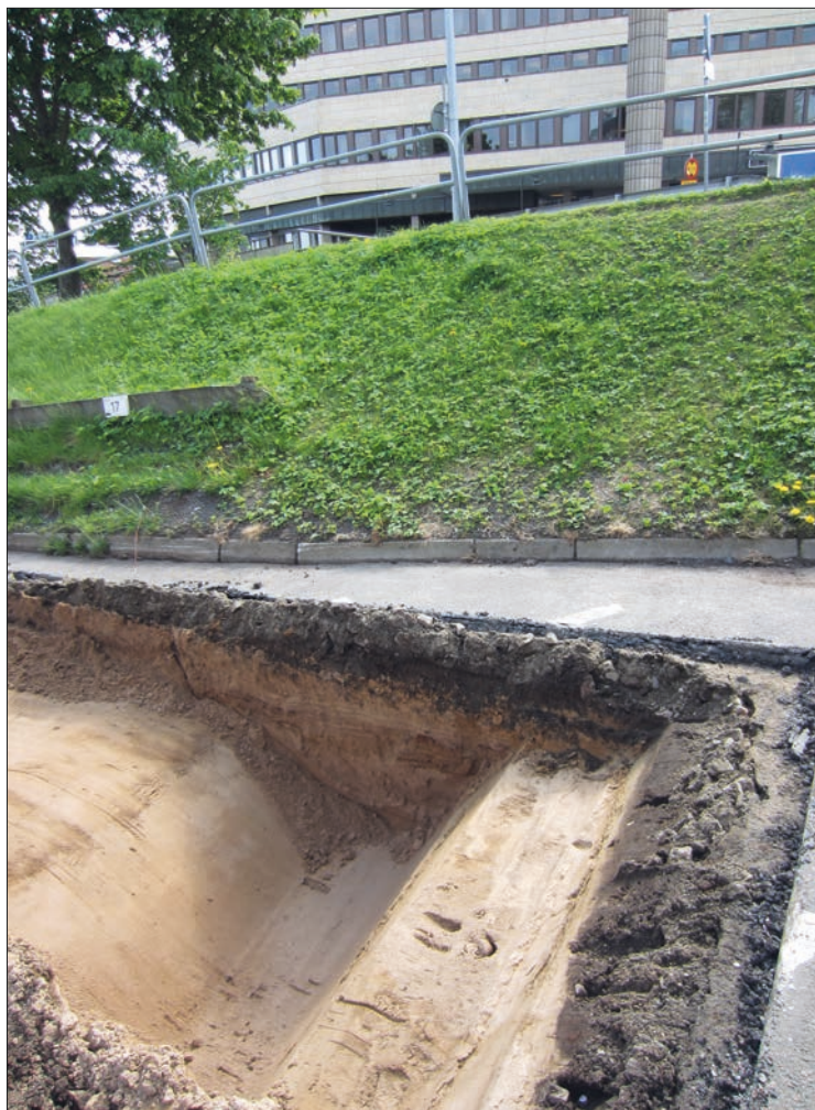
Figur 17. Södra delen av schakt 1, det sydöstligaste schaktet i 2016 års förundersökningsområde. Under det påförda bärlagret ses naturlig sandig undergrund. I bakgrunden ses den påförda gång- och cykelramp som schaktades fort i samband med förundersökningen 2018.
