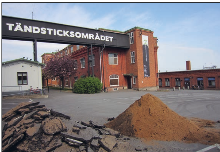
Figur 2: Tändsticksområdet använt som parkeringsplats innan förundersökningen 2016. På bilden har asfalten brutits upp i samband med den inledande provschaktgrävningen.
