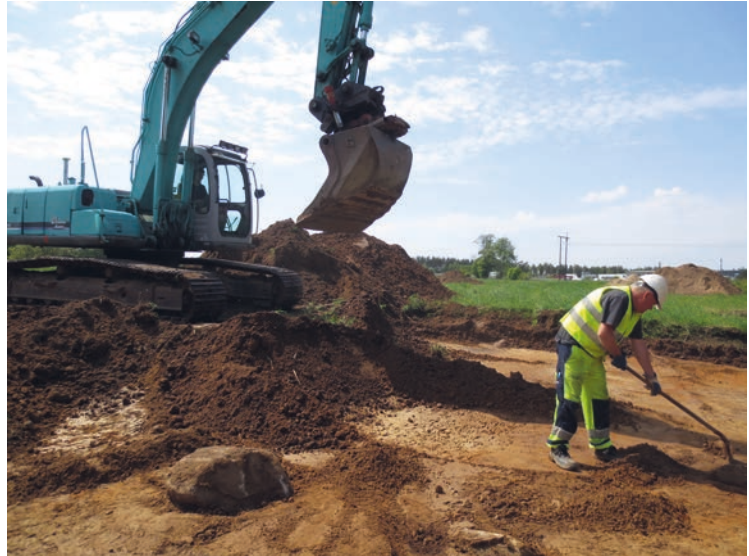
Figur 2. Arbetsbild. Janne schaktar inom RAÄ 445.
