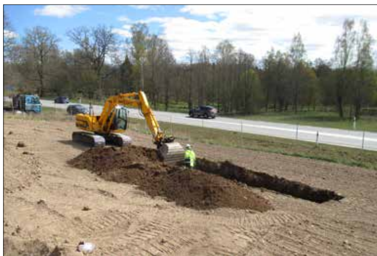
FIGUR 23. Sökschaktgrävning söder om den avbanade ytan.
