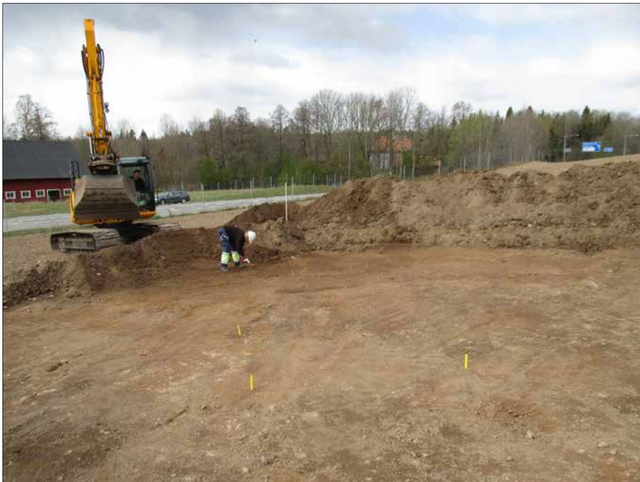
FIGUR 6. Ytavbaning inom område 3. I förgrunden ses avlånga, rännliknande mörkfärgningar markerade med gula pinnar. I bakgrunden skymtar den blåfärgade husgaveln på Broarps gamla gästgiveribyggnad från 1800-talet.
