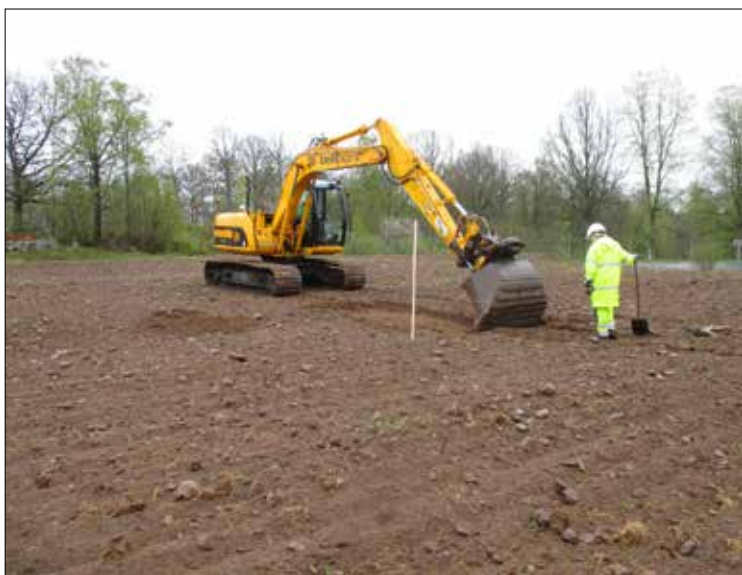
FIGUR 2. Avbaning pågår inom område 2
