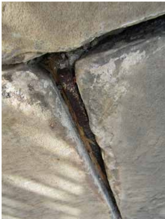
Ovan: I vissa valv över fönstren påträffades kilar av järn som sannolikt använts för att skapa en viss distans mellan stenarna. Några av dessa kilar demonterades och tillvaratogs av läns museet. Ovan till höger: Ny fog över välvat fönster.
