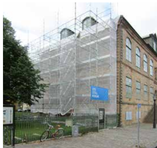
Byggnadsställningarna har rests på den östra fasaden. För att inte göra ingrepp i fasaden förankrades inte byggnadsställningen i denna. I stället ordnades säker förankring på annat sätt.
