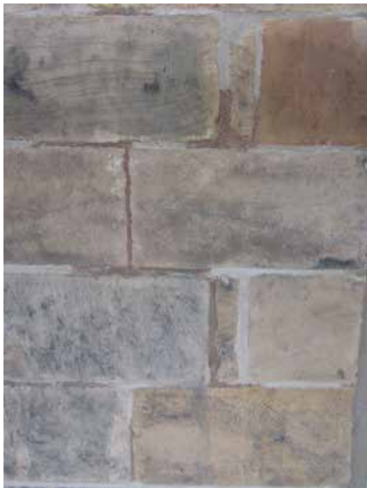
Ovan: Ett exempel på den omfogade fasaden där en del hårda fogar behållits.
