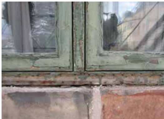
Ovan: När fönsterblecken demonterats upptäcktes att det fanns två horisontella spikrader i karmbottenstyckena. Den övre spikraden härrörde från de befintliga blecken. Den nedre spikraden visar att fönsterblecken haft en lägre placering tidigare. Ovan till höger: Fönsterbleck inför demontering.
