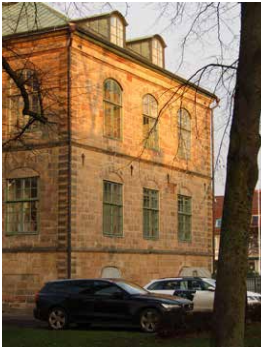
Den färdigrestaurerade fasaden.
