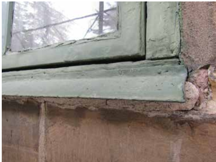
Ovan: När fönsterblecken demonterats upptäcktes att det fanns två horisontella spikrader i karmbottenstyckena. Den övre spikraden härrörde från de befintliga blecken. Den nedre spikraden visar att fönsterblecken haft en lägre placering tidigare. Ovan till höger: Fönsterbleck inför demontering.
