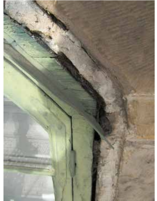
Detalj av fönster vars överdel är försedd med en plåt.
