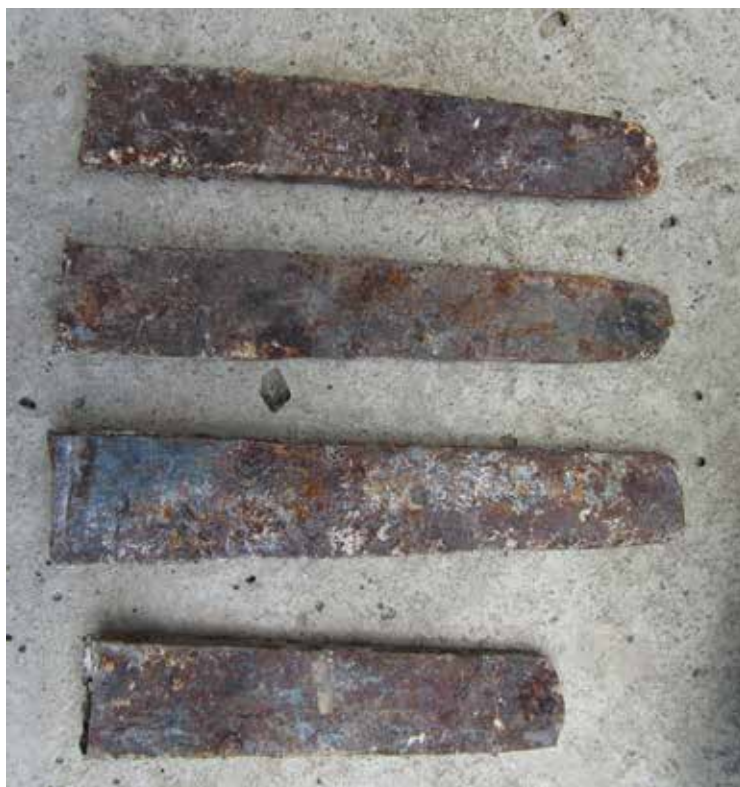
Ovan: Bitar av trä mellan stenblock. Till höger: Några tillvaratagna järnkilar från ett av övervåningens fönstervalv.
