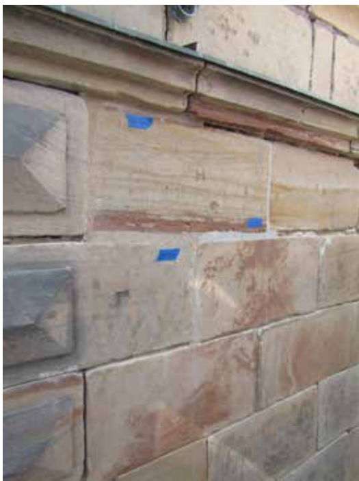
Ovan: För att välja fogningsbruk gjordes tre olika prov på fasaden.
