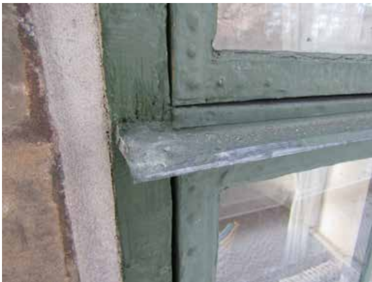
Ovan: Överdel av fönster efter omfogning och målning av karm.
