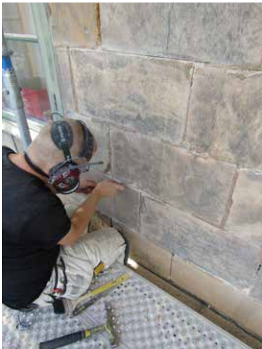
Här pågår borttagning av befintliga fogar.
