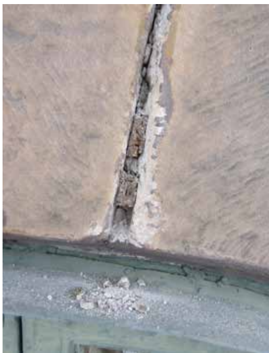
Ovan: Bitar av trä mellan stenblock. Till höger: Några tillvaratagna järnkilar från ett av övervåningens fönstervalv.
