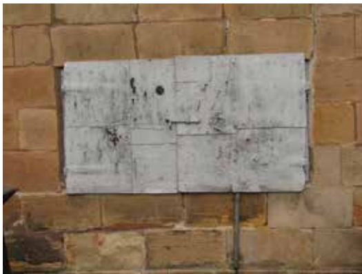
Ovan: Lucka på den södra fasaden.
