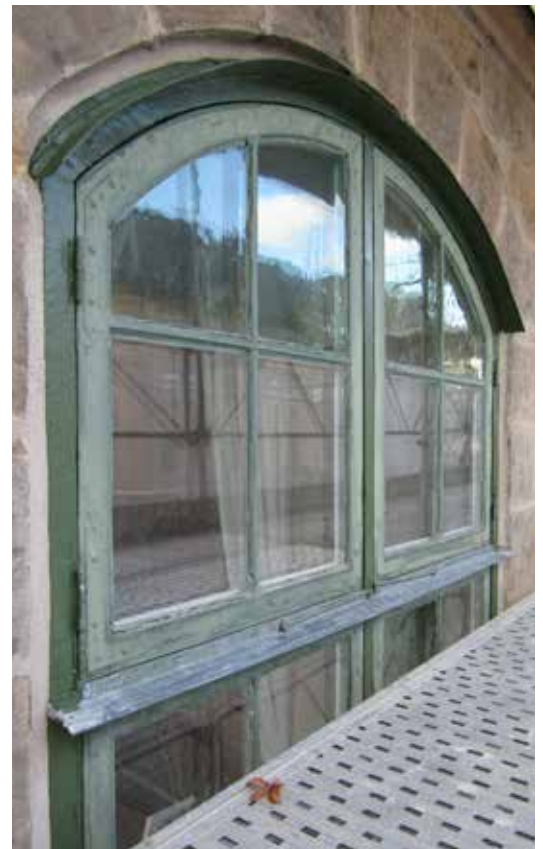
Ovan: Överdel av fönster efter omfogning och målning av karm.
