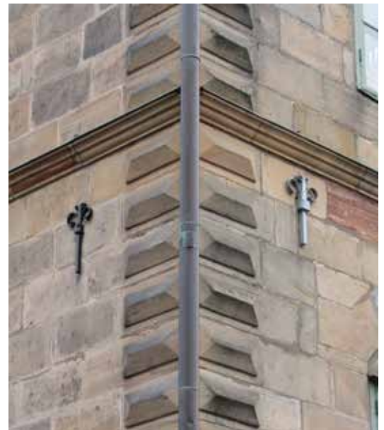
Ovan: Hörn som visar ommålade respektive ej ommålade ankarslutar. Till vänster: Konservatorns färgtrappa.
