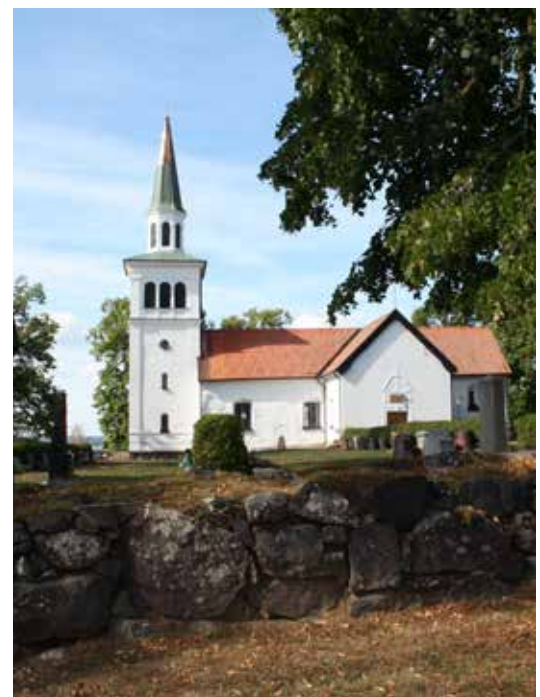
Kyrkogården omges av en kallmurad stenmur, i väster och norr är den kompletterad med ett stålörnsstaket.
