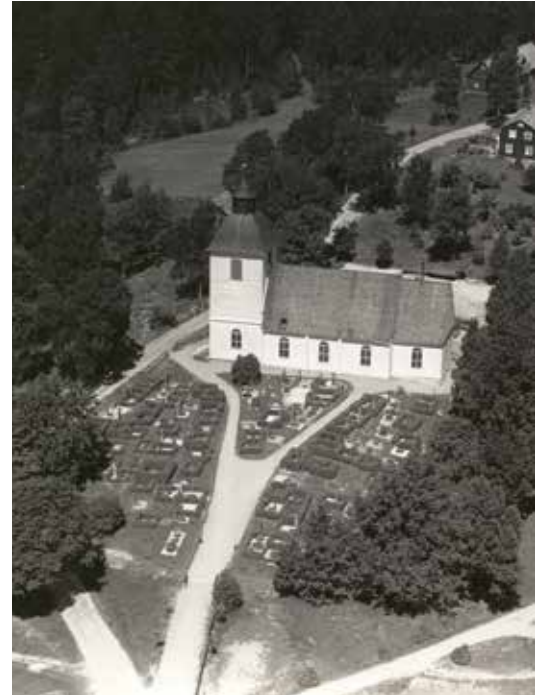
Kyrkogårdens äldre del präglades vid mitten av 1900-talet av häckomgärdade grusgravar utan separerade grusgångar. Flygfotografi, 1941. (JLM)
