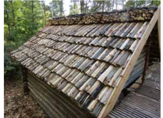
Ovan: Det nylagda taket. Lägg särskilt märke till vedträna och de flata stenarna pånocken. Till vänster: Takets vindskiva och underslag efter takomläggningen.
