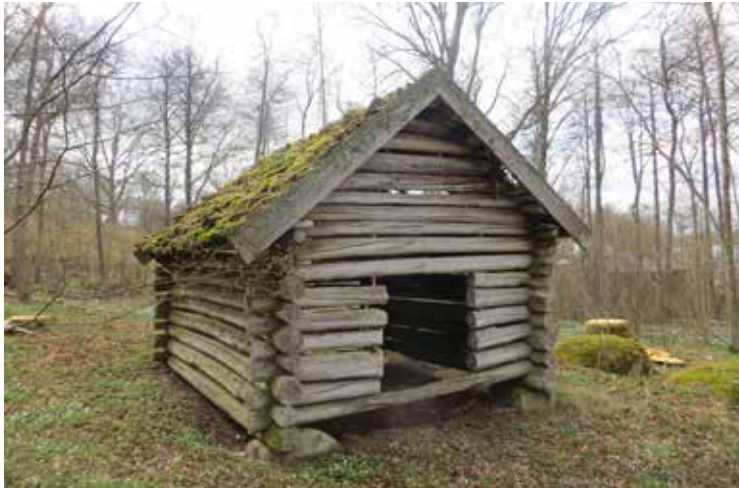
Lövladan i Tärenäs inför restaureringen.
