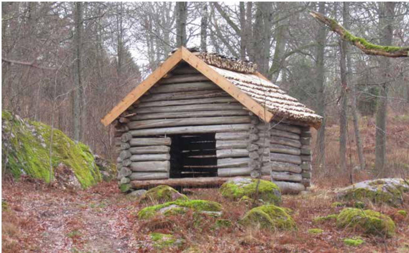
Lövladan i Tärenäs efter restaureringen.
