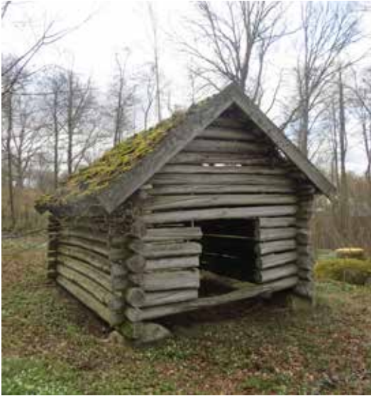
Lövladan i Tärenäs inför restaureringen.
