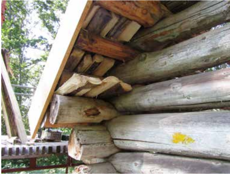
Ovan: Det nylagda taket. Lägg särskilt märke till vedträna och de flata stenarna pånocken. Till vänster: Takets vindskiva och underslag efter takomläggningen.
