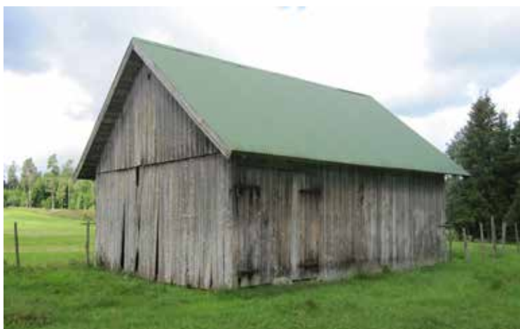
Ovan: Interiören i en ängslada av regelverk. Till vänster: Ängslada i regelverk med sekundärt plåttak. Båda lador är belägna i Rommen i Malmbäcks socken, Nässjö kommun.
