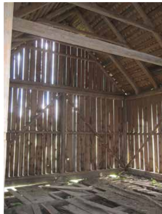
Ovan: Interiören i en ängslada av regelverk. Till vänster: Ängslada i regelverk med sekundärt plåttak. Båda lador är belägna i Rommen i Malmbäcks socken, Nässjö kommun.
