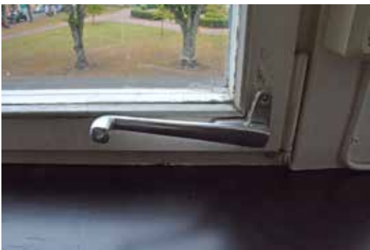
Originalfönstren är mycket sinnrikt konstruerade och öppningsbara åt två håll.
