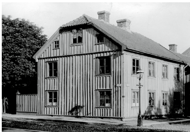
Figur 13. Kvarteret Galeasen. Kyrkogatan 30. Gatufasad hörnet Kyrkogatan till höger, korsande Brunnsgatan till vänster. Tidigt 1900-tal. Foto mot norr. Jönköpings läns museums arkiv: Bild nr 94/1:3088.
