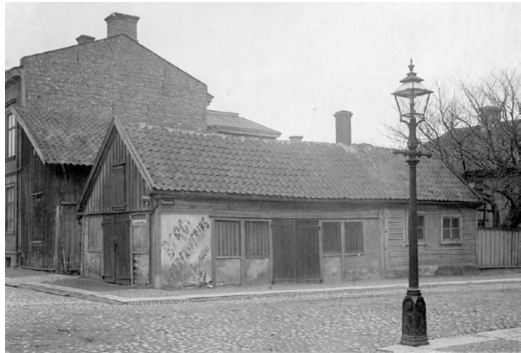
Figur 9. Sydvästra delen av kvarteret Galeasen, tidigt 1900-tal. I förgrunden gatufasaden mot Brunnsgatan och korsande Smålandsgatan till vänster i bild. Foto mot nordöst. Jönköpings läns museums arkiv: Bild nr 94/1:3090.
