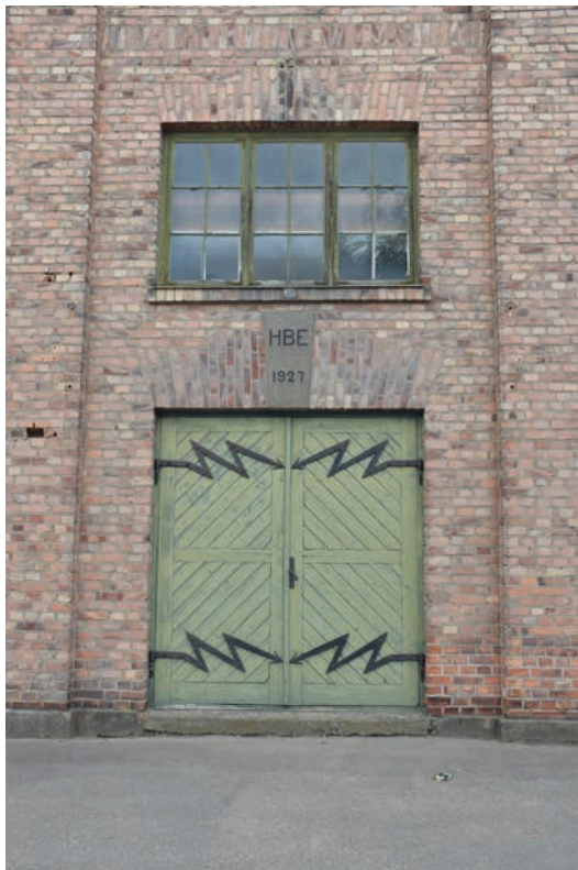
Stadens reservkraftverk uppfördes av Hörle Bruks Elverk, vars initialer syns i slutstenen över de originellt utformade portarna.
