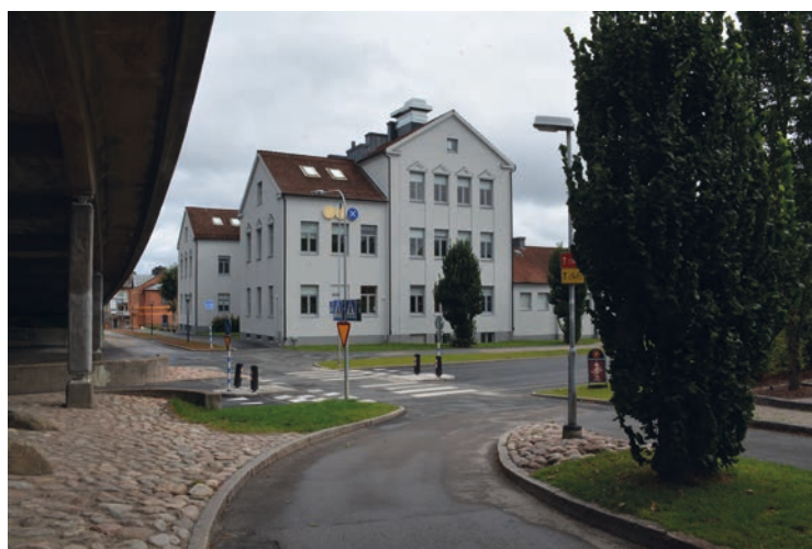
Västra folkskolan ritades av Harald Berglin. I förgrunden viadukten som på ett funktionalistiskt sätt löste den delvis besvärliga sluttningen vid Klevaliden.
