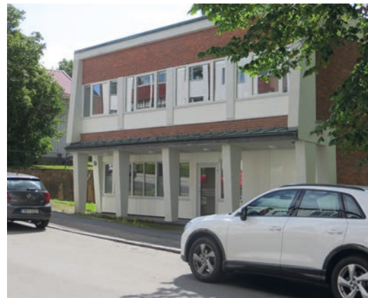
Denna byggnad tillhörde tidigare det tryckeri som låg vid Lagmansgatan. Byggnaden är från mitten av 1900-talet.
