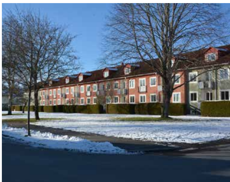
Kv Korpen 9 uppfördes i mitten av 1950-talet efter ritning av arkitekt Kaj Christensen, Varberg.
