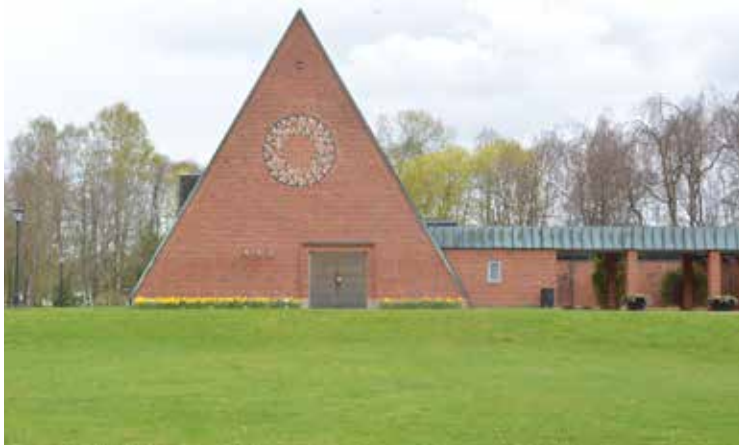
Uppståndelsekapellet uppfördes 1958 efter ritning av stadsarkitekt Hugo Bolker.
