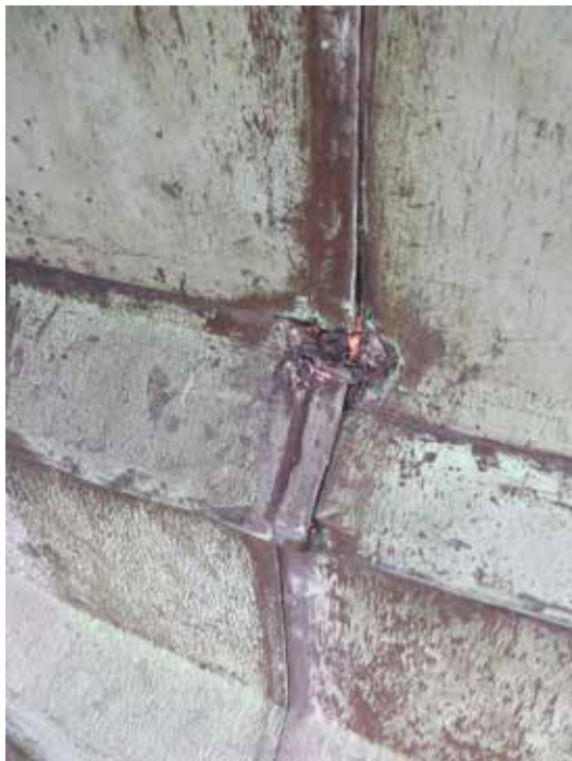
Omkullslagna falsar kan riskera plåtens hållbarhet.
