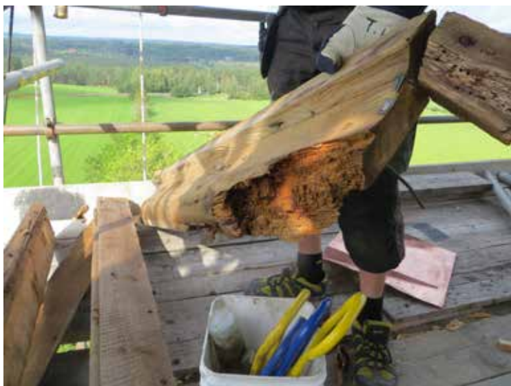
Ovan: Takbottnens nedre del med demonterad plåt. Till vänster: Kraftigt rötskadad profil vid den nedre kanten av spirans övre del.
