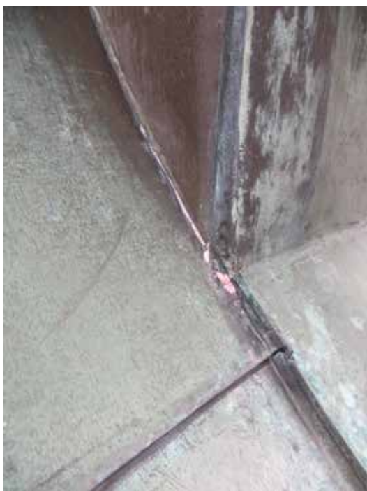
Ovan: Falsar som löper över vinklade partier bör inte som här göras vinklade, utan som en rundning. Till höger: En urtavla efter omtäckning. Nedtill kan man ana hur de rundade falsarna vid frontens sidor utfördes.
