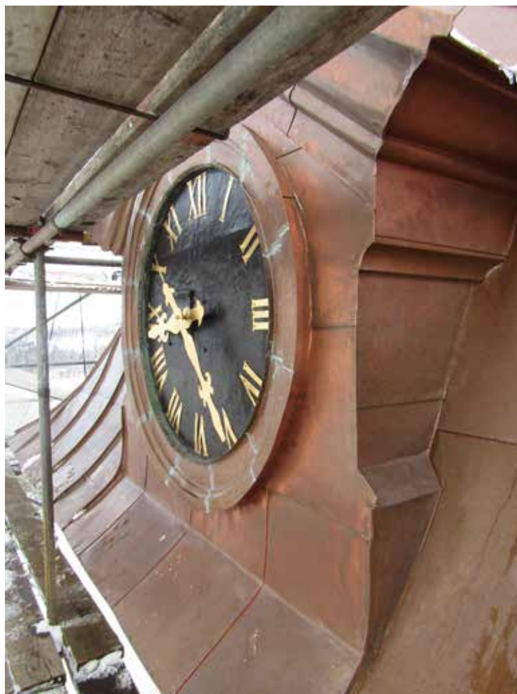
Ovan: Falsar som löper över vinklade partier bör inte som här göras vinklade, utan som en rundning. Till höger: En urtavla efter omtäckning. Nedtill kan man ana hur de rundade falsarna vid frontens sidor utfördes.
