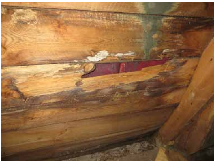
Ovan: Takbottnen bestod av brädor med överlappande kanter.
