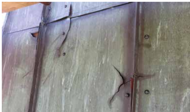
Till höger: Sprickor i takplåten hade lagats temporärt med skruvar för att inte större skador skulle uppstå.
