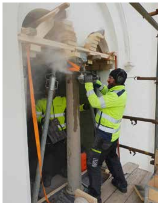
Kolonnetten sågas av
