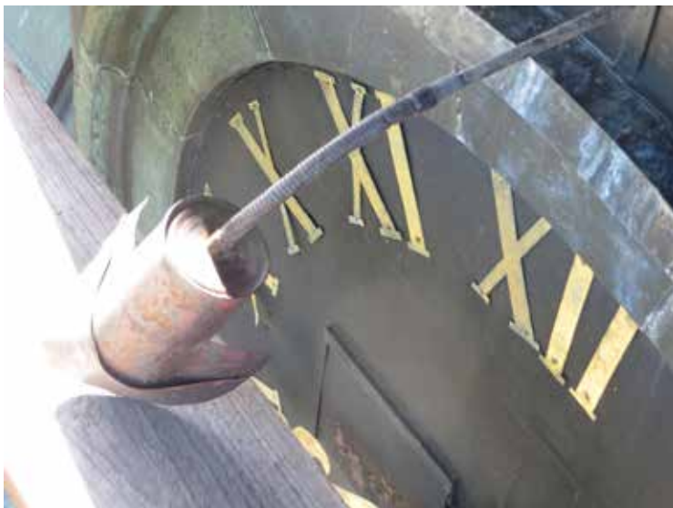
Ovan: Ventilslits upptill på spiran. Till vänster: Belysningsarmatur, troligen tillverkad av en konservburk, togs bort och ersattes inte av någon ny.
