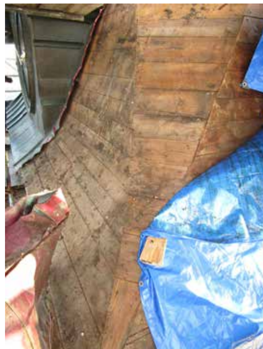
Ovan: Takbottnens nedre del med demonterad plåt. Till vänster: Kraftigt rötskadad profil vid den nedre kanten av spirans övre del.
