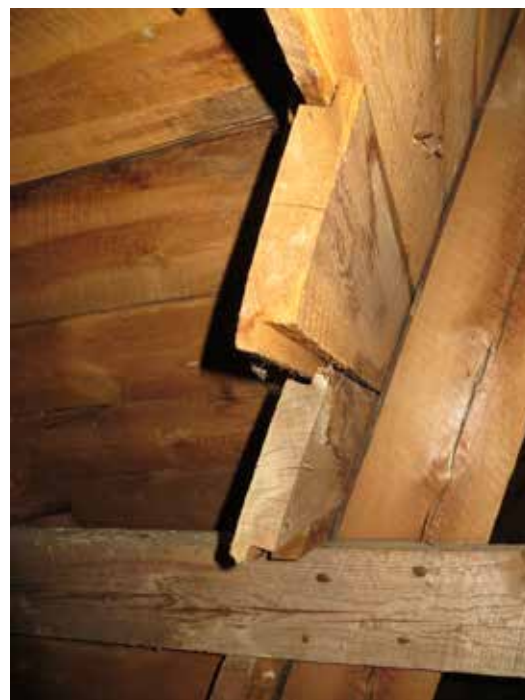
Ovan: Takbottnen bestod av brädor med överlappande kanter.
