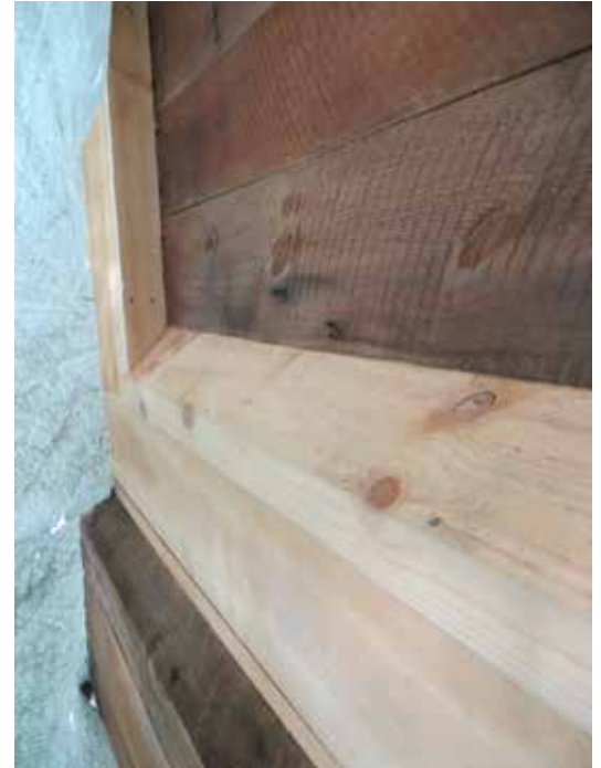
Ovan: Byte av ramvirke på spirans mellandel. Där kunde blindingens virke däremot sparas. Ovan till vänster: Spirans mellandel med blindingar efter omläggningen.
