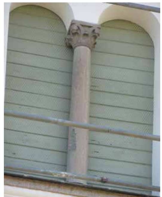
Ovan: En mindre skadad kolonnett med endast yttlig spjälkning.
