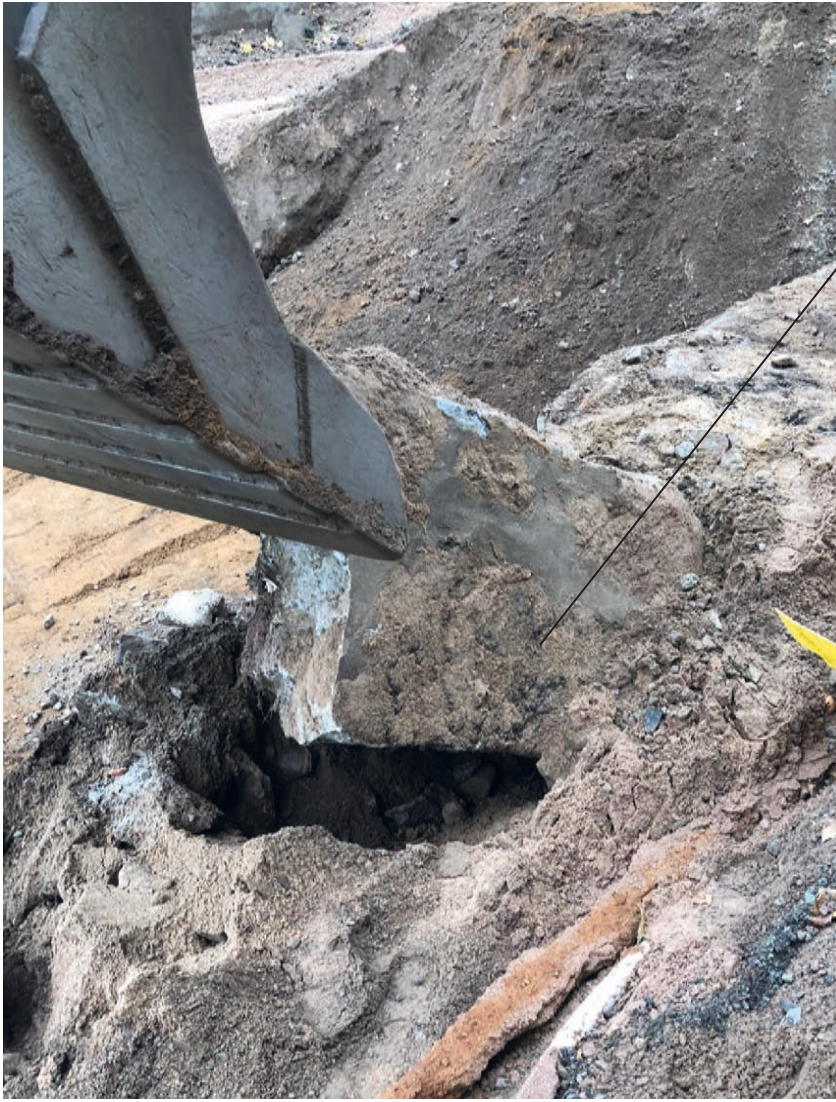
Figur 11. Den stora huggna granitstenen som syns på figur 10. Här syns den pålagda putsen på den norra sidan av stenen. Putsen fortsätter ca 1 meter under den nuvarande murtoppen på denna sida.
