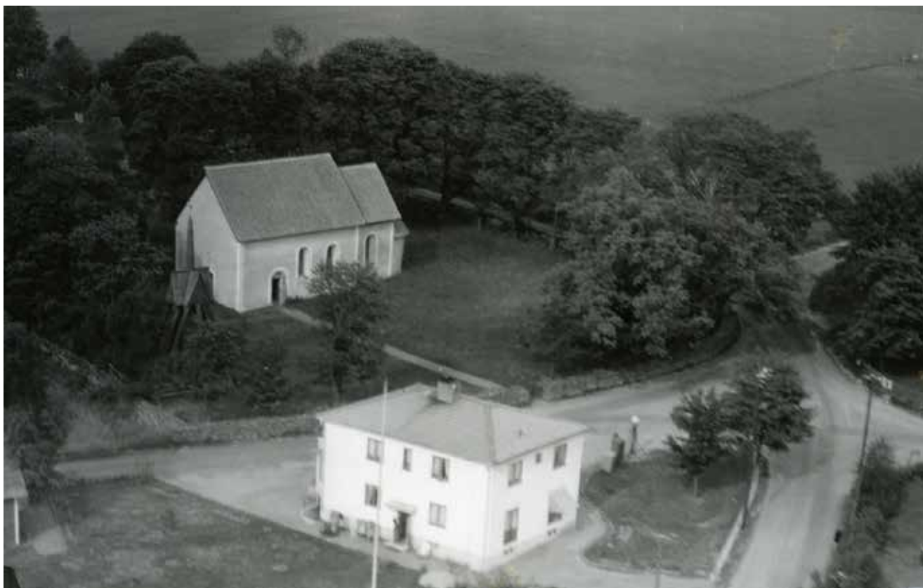
Flygbild över Myresjö gamla kyrka 1947. Vid vägskälet har sockenstugan nyligen ersatts av en lanthandel. Foto: AB Flygtrafik. JLM
