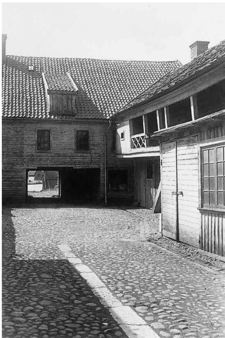
FIGUR 10. Fotografi från Smedjegatan 40. Bodbyggnad med körport mot söder. Intill denna ligger en loftbod med svalgång från 1786. Loftboden är flyttad och finns idag på Östra Storgatan 76. Foto från omkring 1920. Ett exempel på hur innergården i kvarteret Abborren kan ha sett ut.
