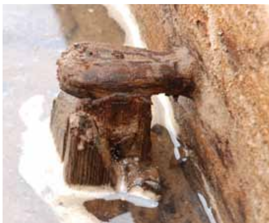
FIGUR 34. Låskonstruktion från en av träkistorna som hindrat ramen av stockar att flyta upp mot vattenytan.
