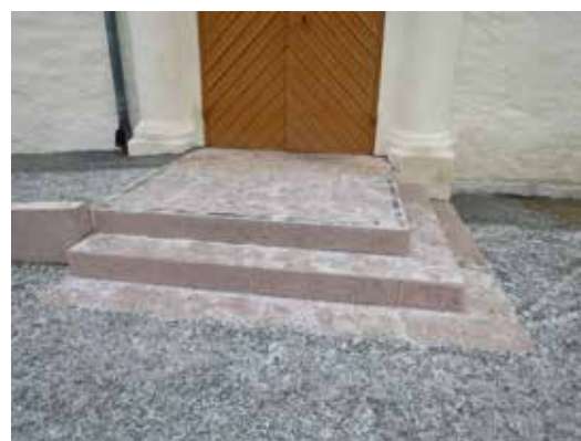
Befintlig trappsten bibehölls närmast dörren. Det övre viloplanet försågs med kontrastmarkering av grå granit längs kanterna. I rampens sträckning fick grusgången breddas något in i kanten av närliggande gravkvarter.
