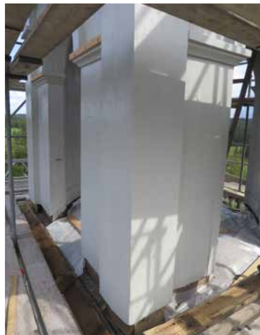
Lagningar på lanterninens fasad.
