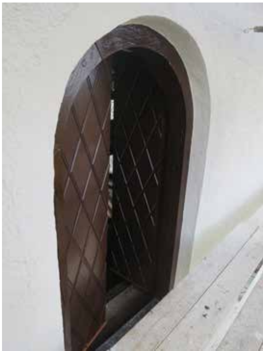
Ena ljudluckan efter lagning och ommålning. Luckorna målades med oljefärg i en brun kulör för att efterlikna tjära på avstånd.
