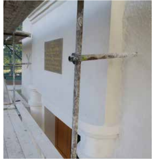
Arkitraven i västportalen efter avfärgning och omförgyllning av inskriptionen på minnestavlan.
