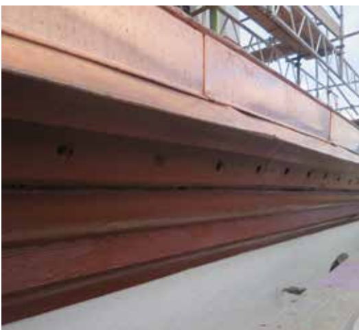
Plåttäckningen på tornet fick rakt utsprång i likhet med tidigare. Hål borrades upp i listen för förbättrad luftning av vinden.
