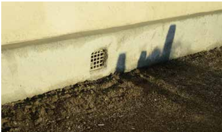
Parti av sockeln målad i ljusgrå kulör med ventilgaller i samma nyans.
