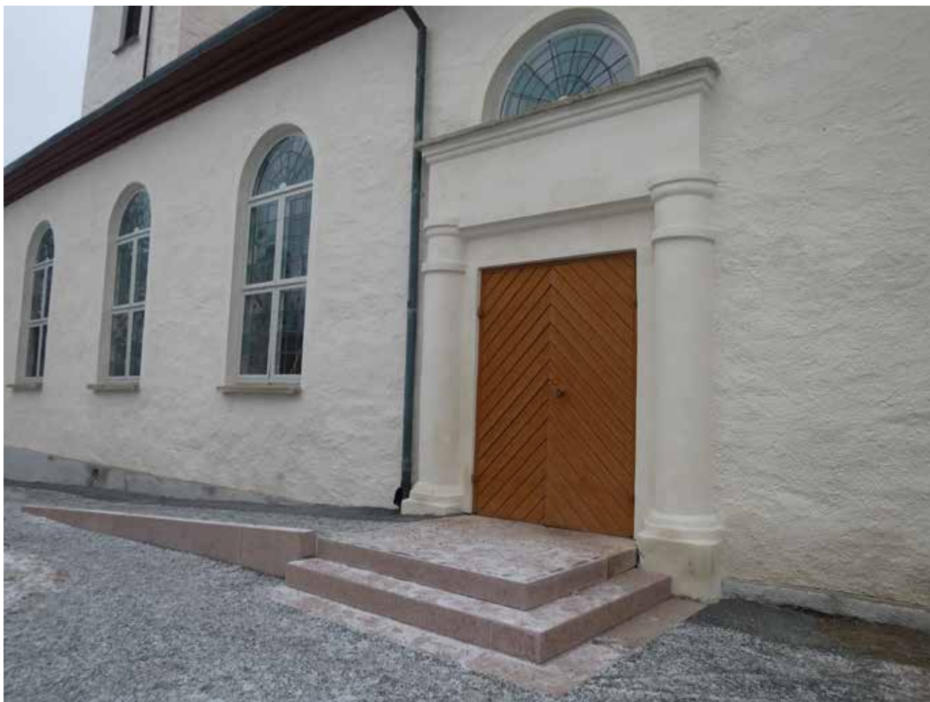
Den nya tillgänglighetsrampen framför södra entrén av röd krysshämrad Vångagranit. Handledaren är ännu inte på plats.
