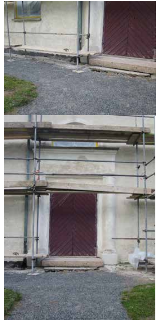
Södra entrén före anläggningen av tillgänglighetsrampen.
