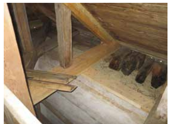
Takstolsdelar som byttes ut togs tillvara och lades in på tornvinden. Detta eftersom takstolen innehöll delar som misstänkts komma från den medeltida kyrkan. Delar som bedöms vara medeltida skulle kunna användas vid en framtida dendrokronologisk datering av den gamla kyrkan.
