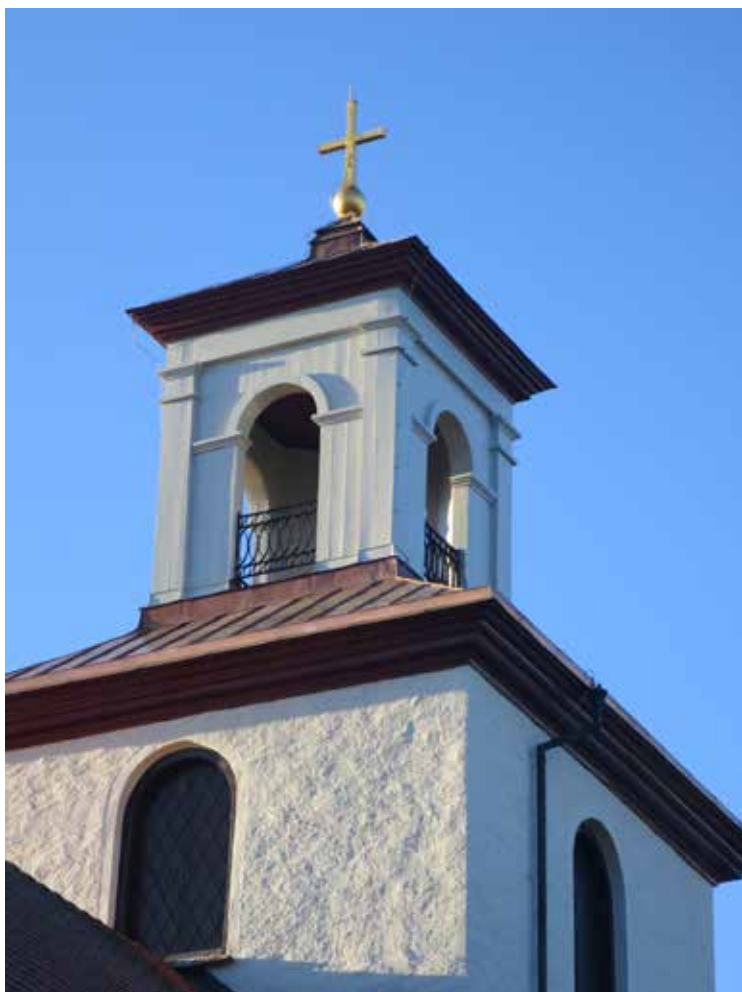
Lanterninen och tornets krön med de nya koppartaken.
