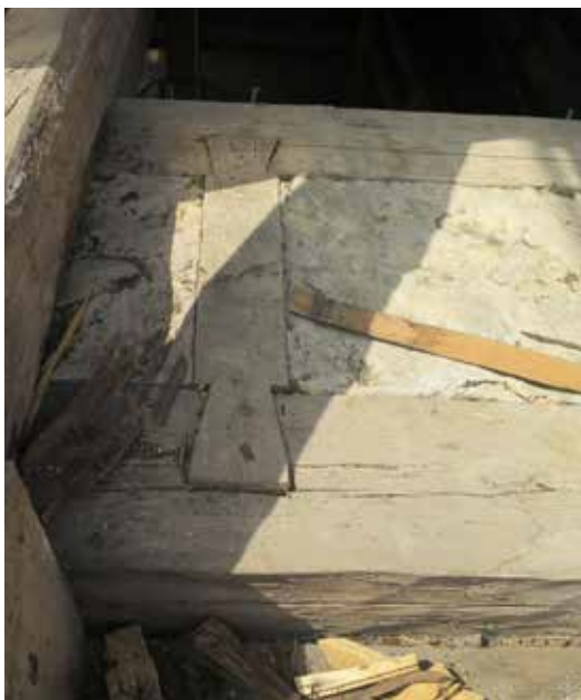
Remstyckena på tornmurens krön hölls samman med inlaxade brådor. Utrymmet mellan remstyckena var fyllt med kalkbruk.
