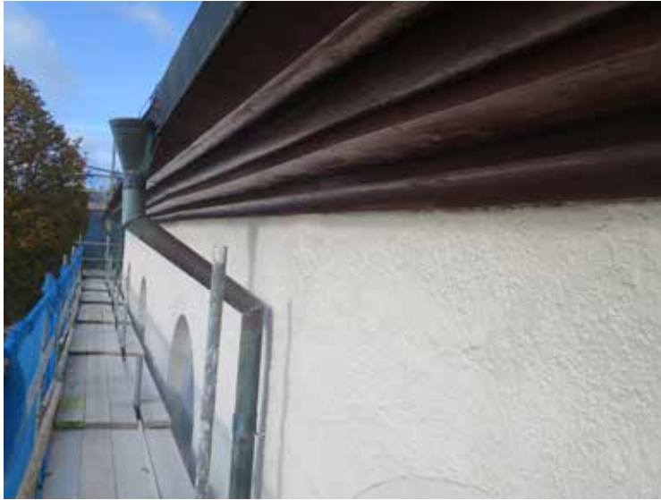
Del av långskeppets södra fasad efter avfärgning och ommålning av taklist.
