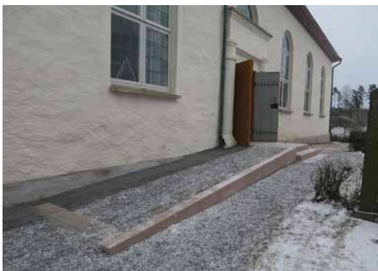
Rampen bestod av sidostycken av röd granit medan gångytan gjordes med packat stensmjöl med samma toppgrus som i gångarna. Längst ned i lades en stoppsten i röd granit.
