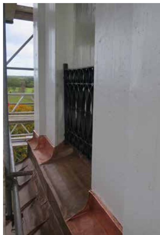
En viktigt detalj var anslutningsplåten vid lanterninens bas. En bräda placerades bakom så att plåten hamnade i liv med fasadpanelen. Plåtlisten målades sedan in i fasadens kulör med en modern primer.
