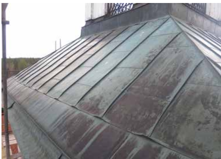
Koppertaket på tornet är sannolikt från 1960-talet med ståndränna och hög övre anslutningslist.
