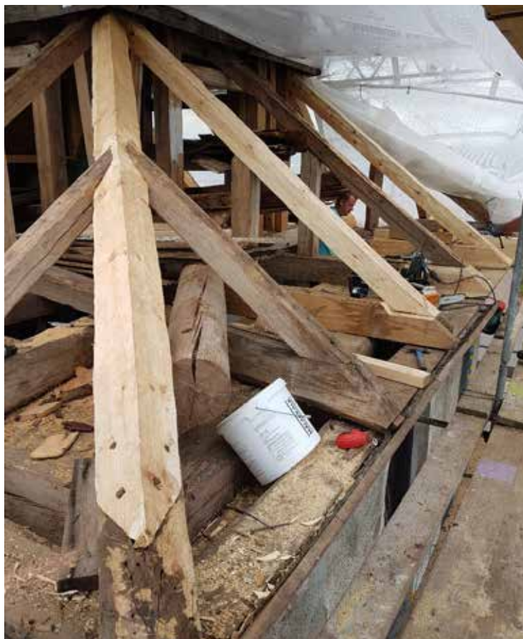
Lagningar i två av takstolarna åt söder. Skadade högben ersattes i sin helhet, med hänsyn till bärrigheten. Bindbjälkarnas ändar lagades i med skarvning halvt i halvt. Lagningarna spikades med smidd spik lika befintlig takstol.
