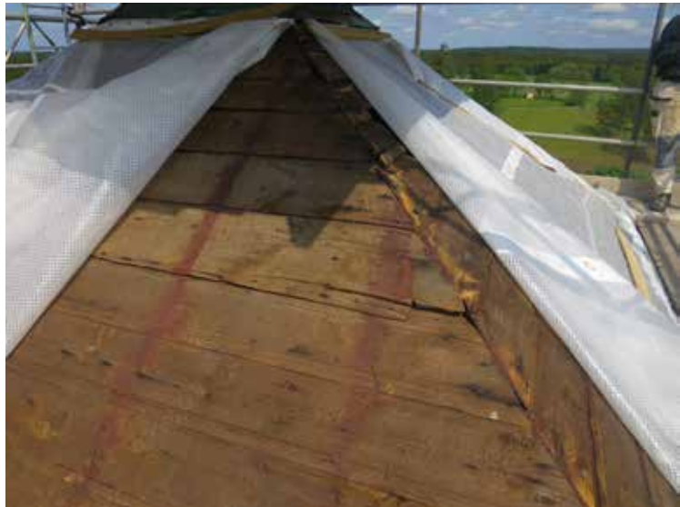
Spår efter ett rödmålat plåttak återfanns på lanterninens taksvall.
