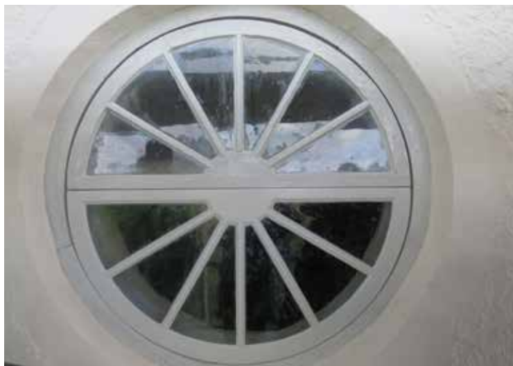
Ny fönsterbåge tillverkades till tornets rundfönster. Den nedre bågen är nyttillverkad med den befintliga som förlaga. Nyttillverkat munblåst glas har använts till rutorna.
