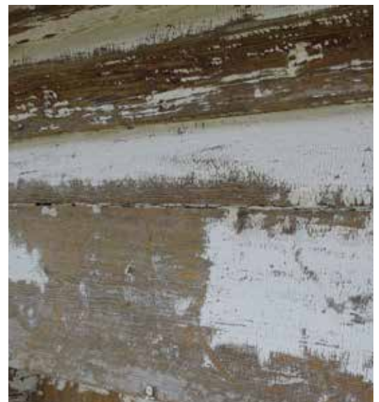
Bevarad järnoxidbrun originalfärg på lanterninens taklist.
