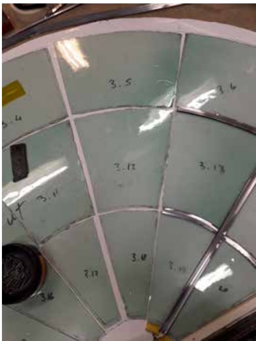
Lunettformad båge under restaurering. All blyspröjs byttes mot ny. Foto: Blyfönsteriet AB.
