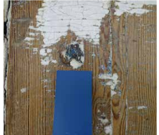
Spår av bevarad originalfärg på lanterninens fasad, sannolikt marmorering i berlinerblått och svart.
