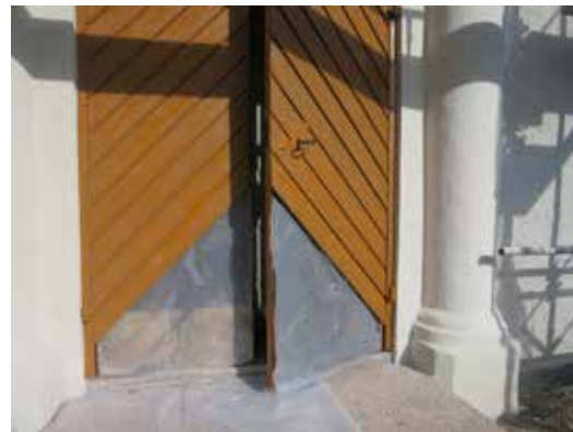
Rötskadade panelbrädor nederst på södra porten ersattes med nya.
