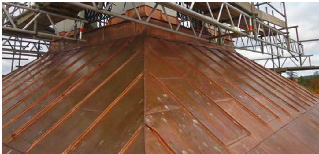
Torn - och lanterninetakens nya koppartäckningarn präglas av hantverksmässigt utförande.
