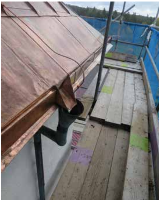
Befintliga stuprör bibehålls.
