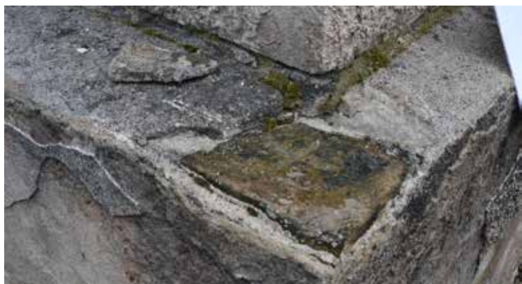
Före restaureringen påträffades ett hugget kors i en sten i tornets sockel. Korset fanns i det sydvästra hörnet. Eftersom det var oklart om detta var ett äldre konsekrationkors eller en fixpunkt putsades korset över.
