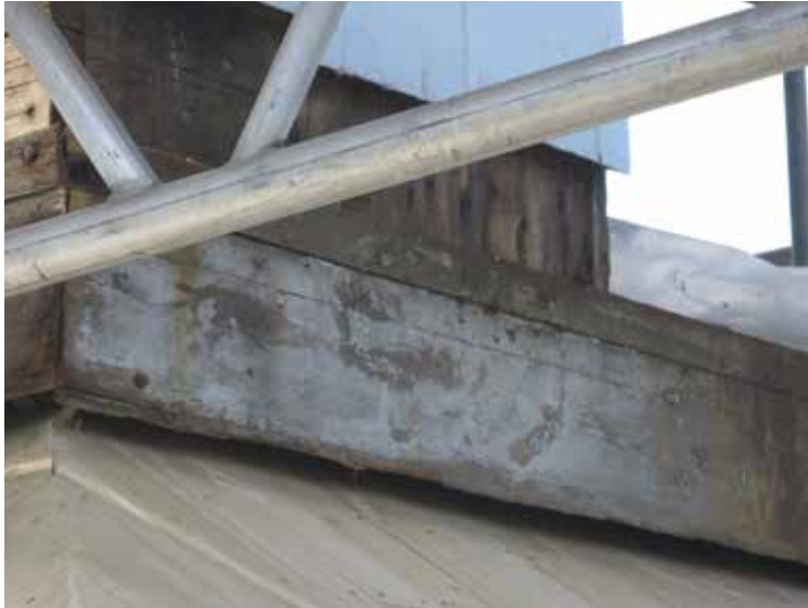
Spår av bevarad originalfärg på lanterninens fasad, sannolikt marmorering i berlinerblått och svart.
