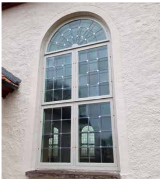
Ett av blyfönstren åt norr efter restaurering.
