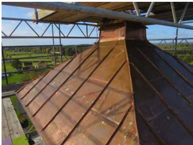
Lanterninens tak med ny skivtäckning i kopparplåt utan ståndränna. Med den bevarade originallisten fick takfoten ett något utvikt avslut.
