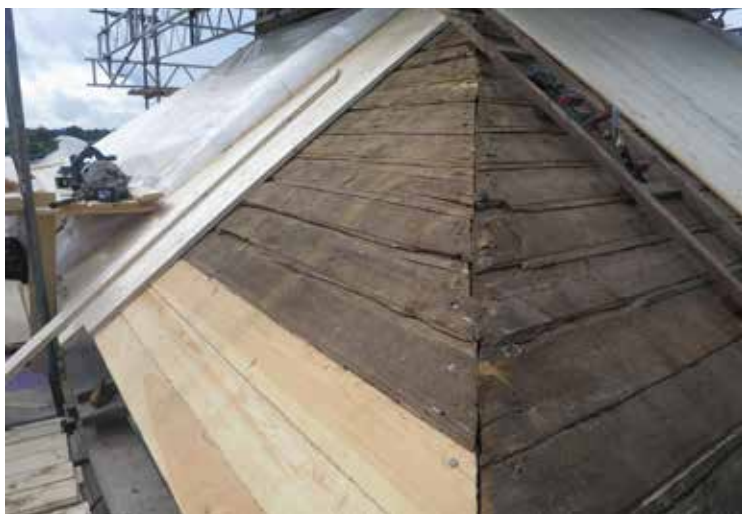
Lagningar av den äldre taksvallen på den östra sidan.
