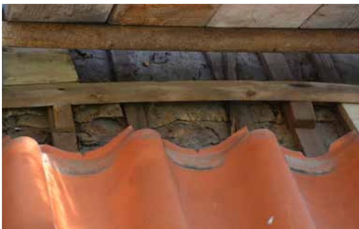
Under dagens tegeltak på långskeppet finns nävertäckningen från 1835 ännu bevarad.
