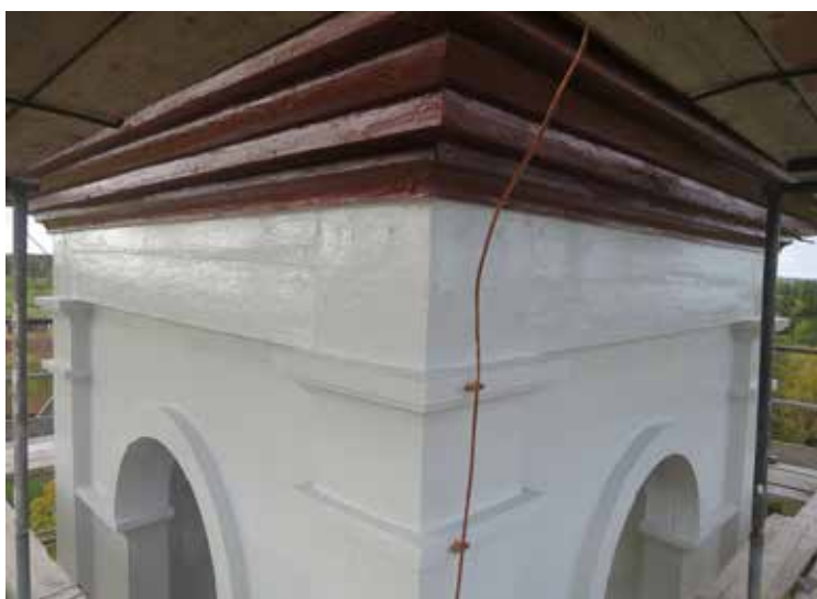
Lanterninen fick en något ändrad färgsättning med ljust gråa fasader och rödbrun taklist. Att återställa den marmorering som den ursprungligen haft bedömdes inte som realistiskt i dess utsatta läget.
