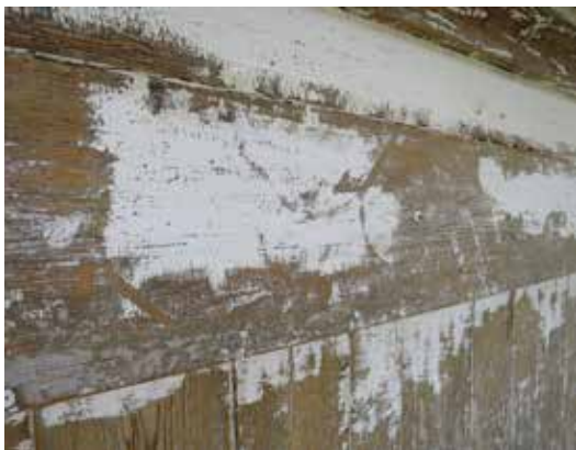
Spår av marmorering på lanterninfasad. Denna var gjord i ett ganska grovt manér. De grova penseldragen var säkert en förutsättning för att dekoren skulle synas från marken.
