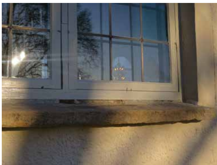
Fogen mellan karmbottenstycken och solbänkar kommer att lagas med ett genomfärgat naturhydrauliskt kalkbruk.
