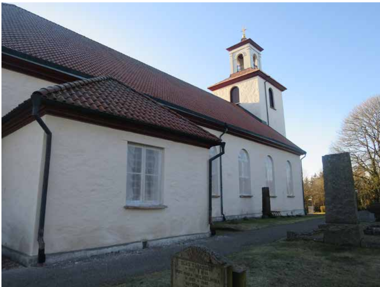
Kyrkans norra fasad. Återmonteringen och slutstrykningen av fönsterbågarna återstod vid besiktningen.
