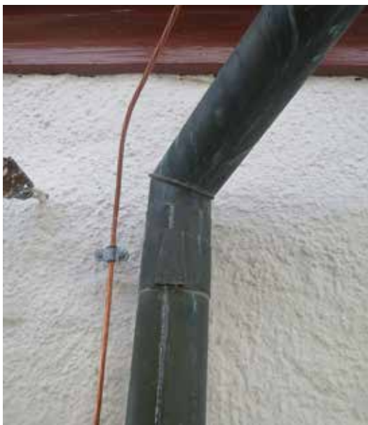
Nya åskledaren med fäste i stål isolerat med bly.
