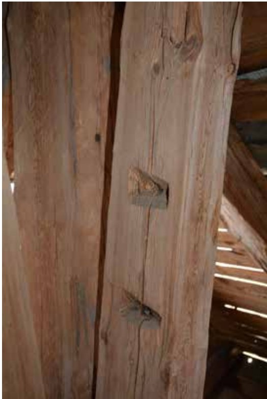
Återanvända delar, i tornets takstol, sannolikt hämtade från den gamla kyrkan.
