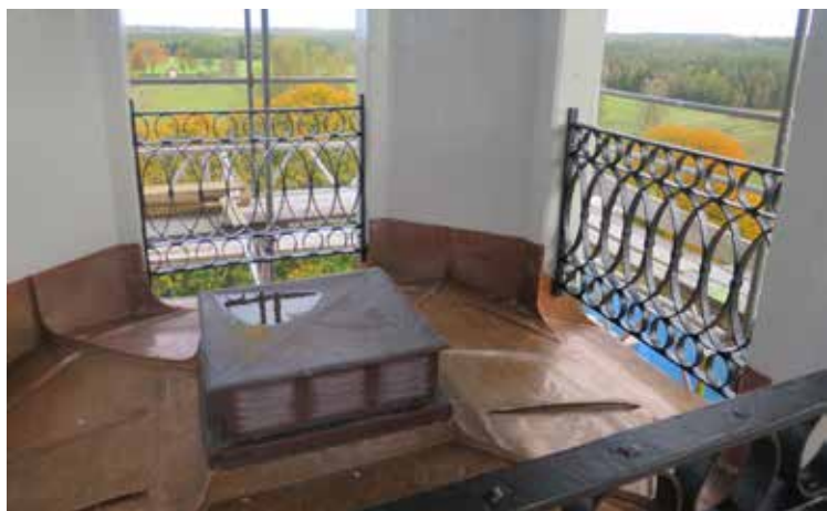
Ny koppartäckning invändigt i lanternien. Den tidigare takluckan bibehålls.
