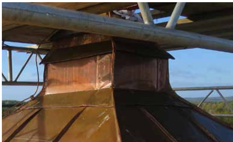
Krönets speciella säteritaksform bibehålls. Däremot utfördes den inte med små plåtformat, vilket annars är karaktäristiskt för äldre plåtslageri.
