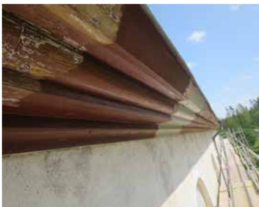
Uppstrykningsprov inför val av kulör på taklisterna, antingen järnoxidbrun eller grå.
