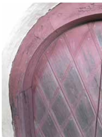
Ljudluckorna med sentida rombisk panel. Oljefärgen i bränd terra är kraftigt nedbruten. Under denna framträder stenkolstjärna.
