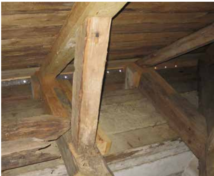
Lagningar av två av torntakets takstolar.
