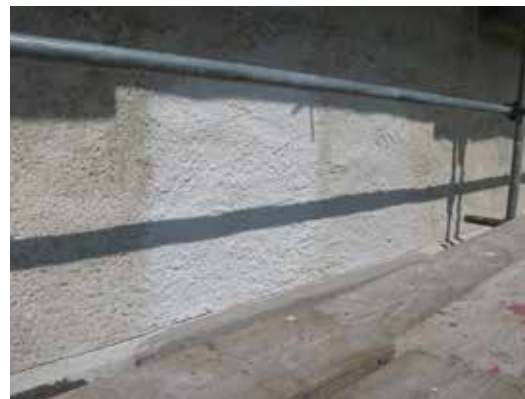
Uppstrykningsprov inför val av brytning på fasadfärgen.
