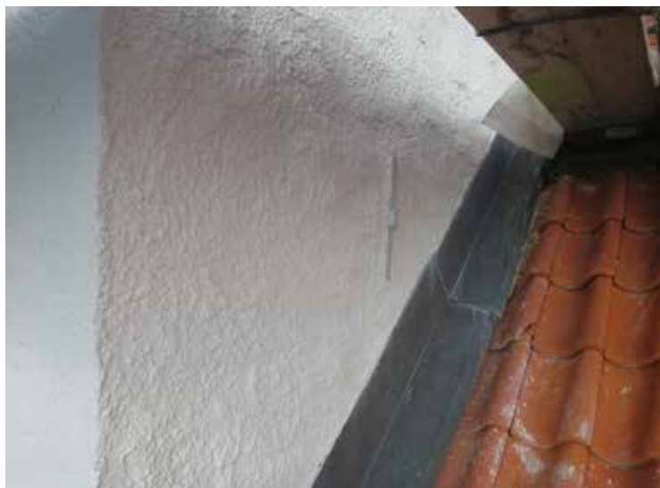
Delar av tornfasaden med ankarjärn inmålat med oljefärg i fasadens kulör.
