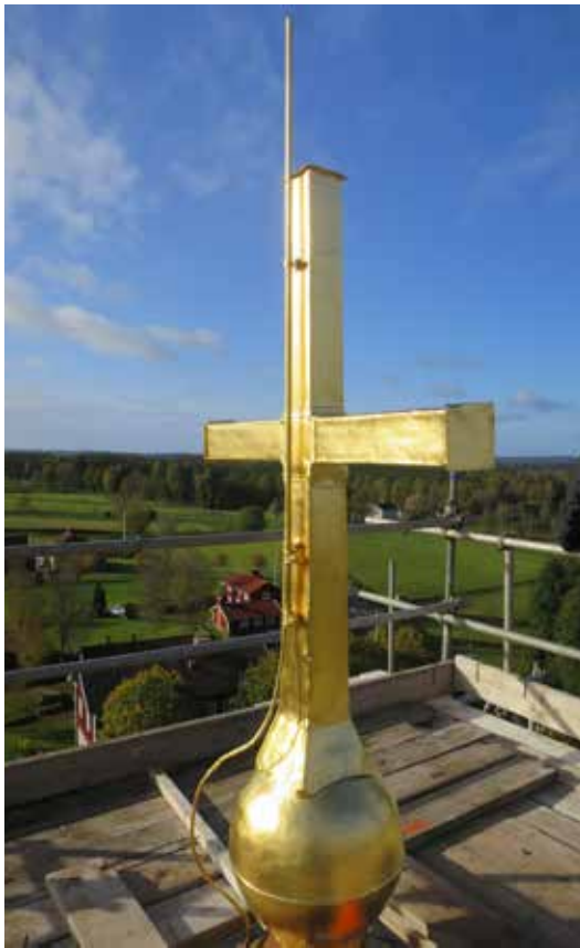
Tornets krönprydnad efter omförgyllning. Den nya åskledaren fästes in i prydnaden och förgylldes även den för att bli mindre synlig.
