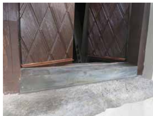
Ljudluckorna försågs med dropplist av kopparplåt längs de nedre kanterna, som skydd mot inträngande fukt.
