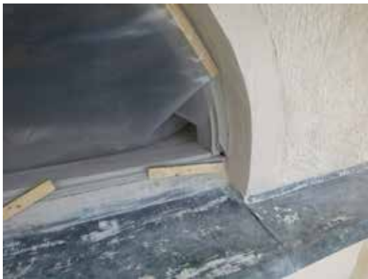
Målningen av krönplåten över västportalen kvarstod vid slutbesiktningen.
