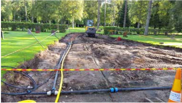
Anläggningsarbetet har inletts, 4 september 2018. Foto: Kenneth Claesson.
