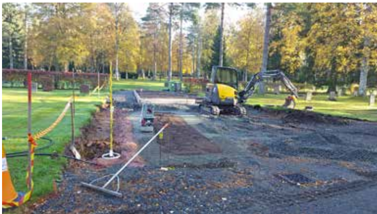
Pågående anläggningsarbete, 10 oktober 2018. Foto: Kenneth Claesson.
