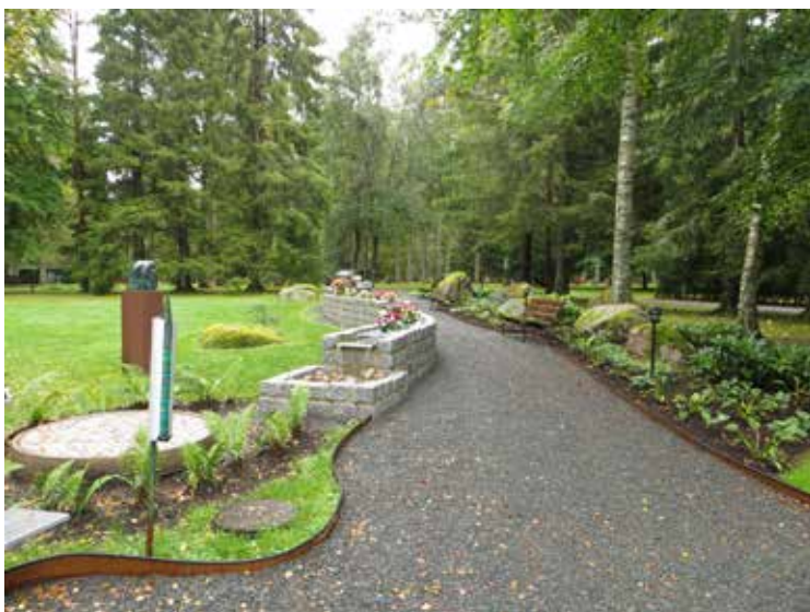
Viss plantering utförd, från delbesiktning 2017.
