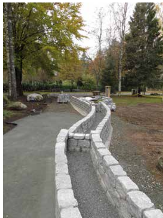
Vattenrännan med dess sektionering.
