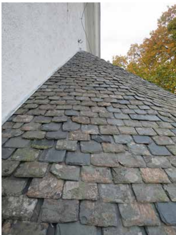
Södra delen av taket efter färdigställd omläggning.
