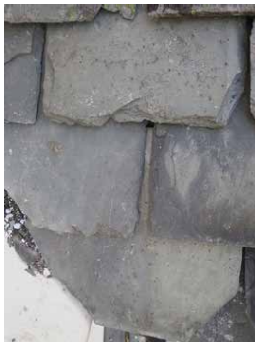
Bristande överlappning mellan plattorna förekom med otätheter där vatten kunde ledas in.
