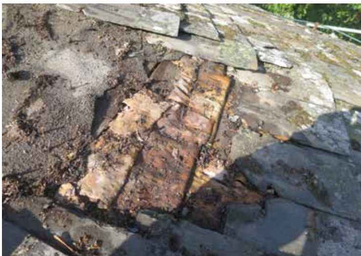
Nävertäckningen bestod av liggande ark i två överlappande lager.
