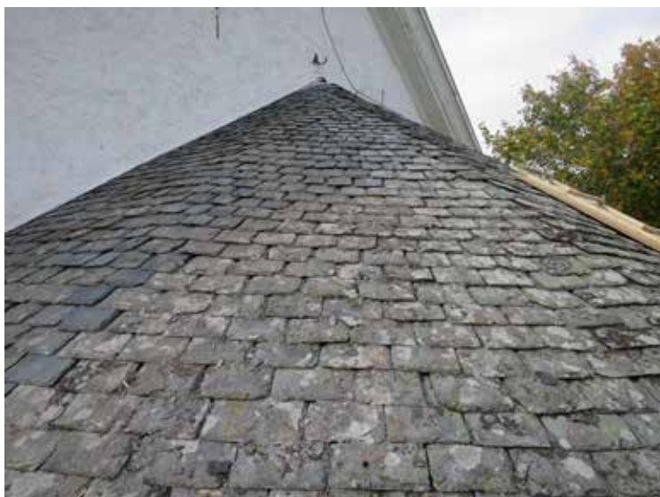
De omlagda delarna gick att urskilja både eftersom skiffret i dessa delar varierade i utseende och täckningen var något mindre jämn.
