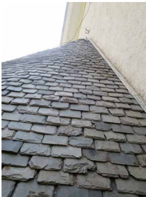
Norra delen av taket efter omläggning.
