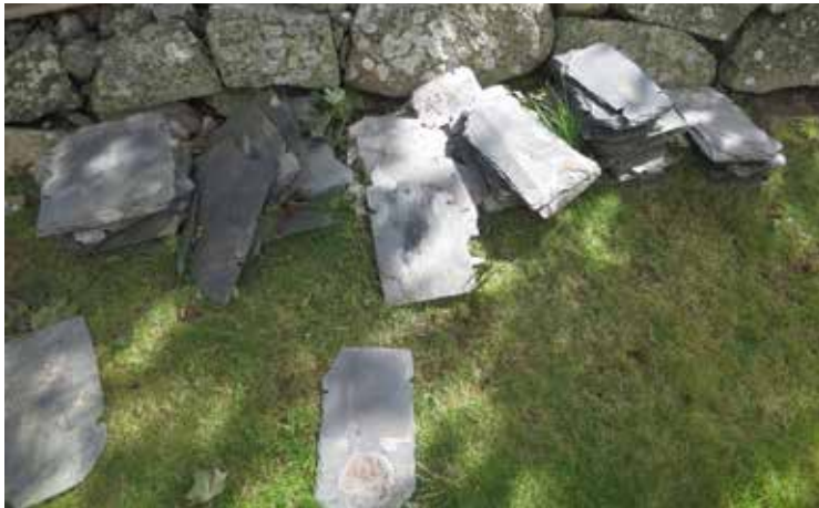
Täckningen bestod av Dalslandskiffer i rektangulära fjällformade plattor. Här har delar av skiffret tagits ned.
