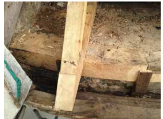
Den södra sektionen av hammarbandet och stickbjälken fick bytas.
